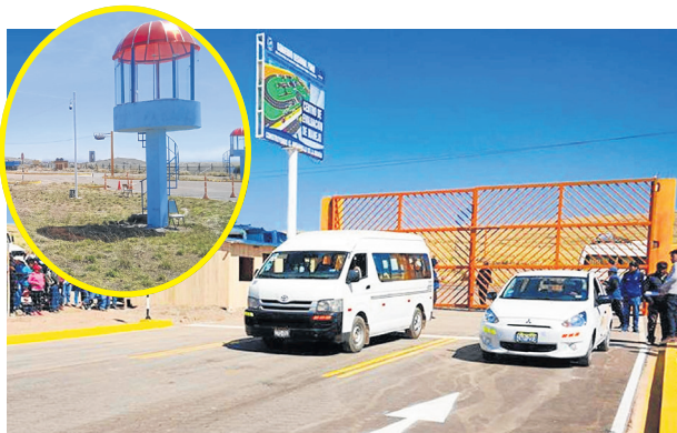
Las obras deficientes las reveló diario Sin Fronteras.
