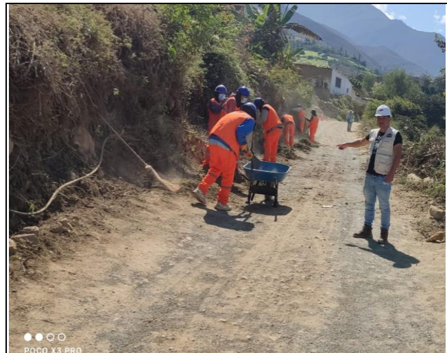
Foto 04: VERIFICACION DEL PERSONAL REALIZANDO LA ACTIVIDAD DE ROCE Y LIMPIEZA EN LA PROGRESIVA 00+250 KM
