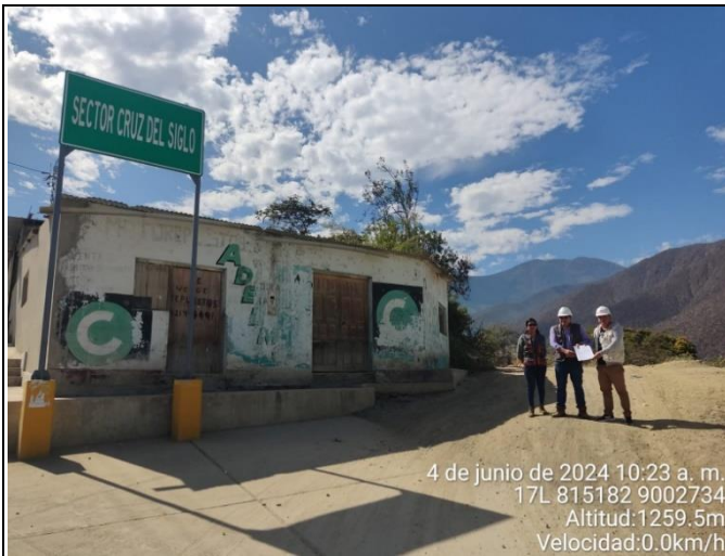
Foto 01: ENTREGA DE TERRENO EN EL TRAMO
