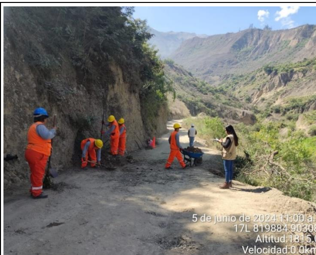
Foto 03: VERIFICACION DEL PERSONAL REALIZANDO LA ACTIVIDAD DE ROCE Y LIMPIEZA EN LA PROGRESIVA 00+100 KM
