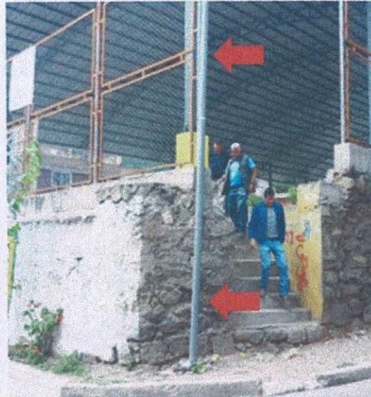
Fig. 03. Se evidencia bajada de TUBERIA PVC SAL 4", falta de culminación.
