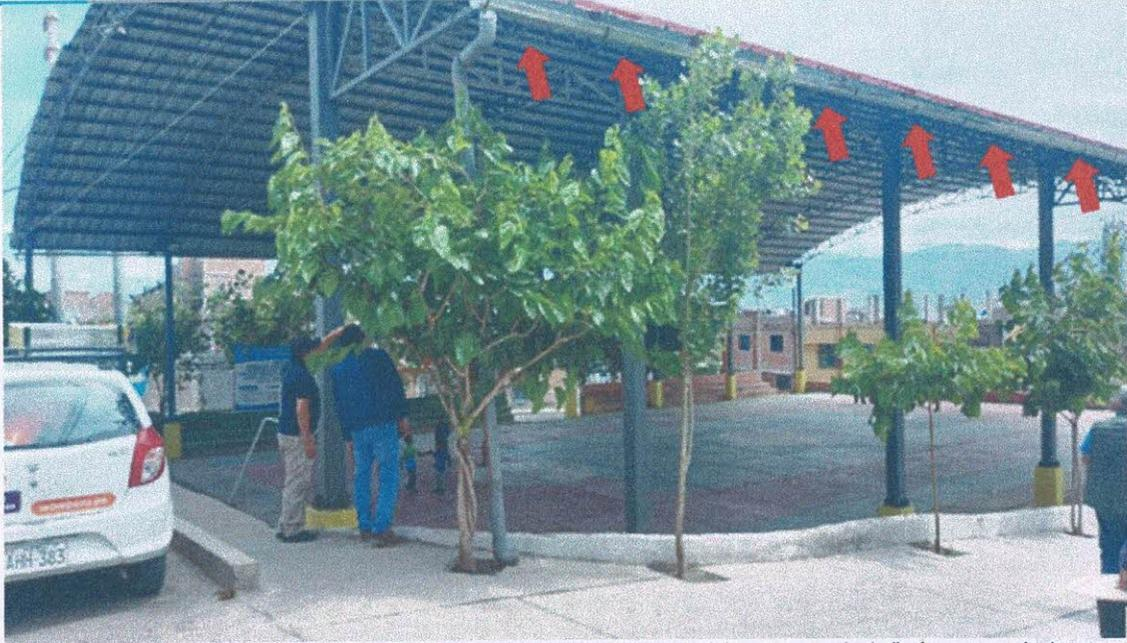
Fig. 02. Se evidencia una mala colocación de las canaletas de evacuación pluvial, en temporada de lluvia se acumula de agua pluvial, ya sea por pendiente o la sección (se hará un cambio de canaleta)
