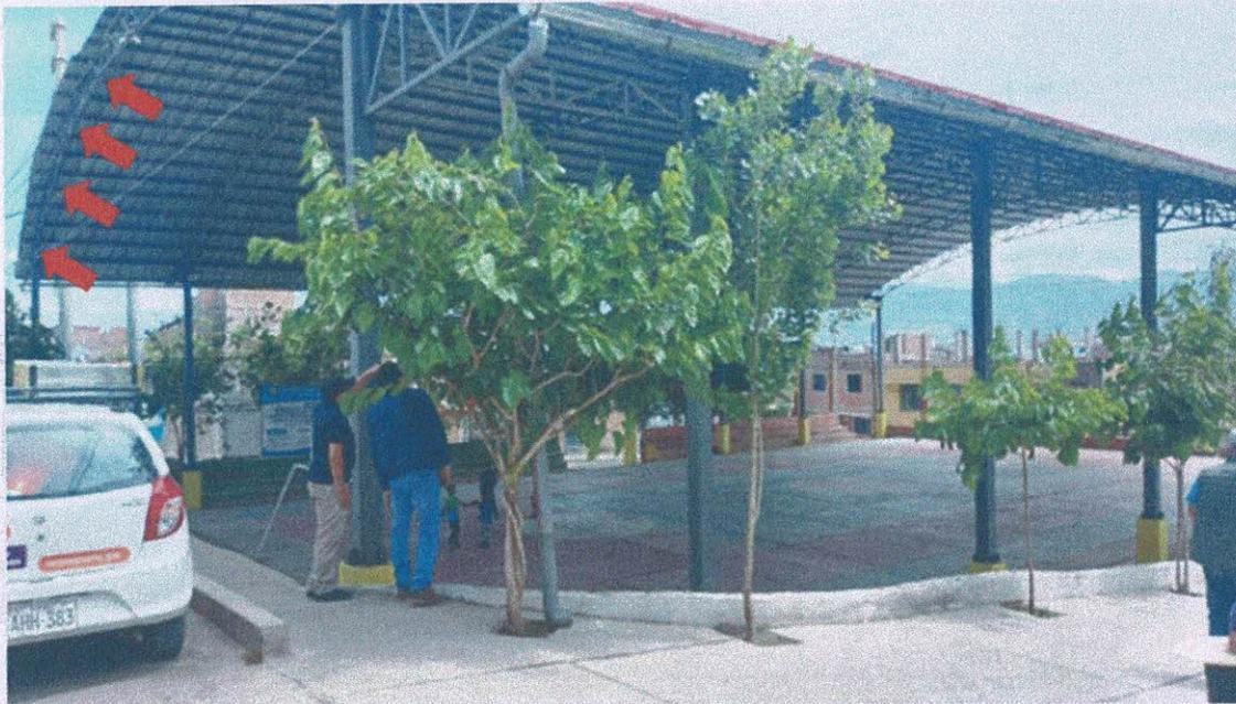
Fig. 01. Se evidencia mal corte en los extremos en la cobertura de Aluzinc de la Losa Deportiva.
