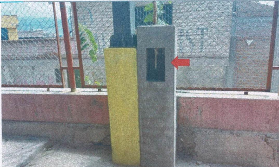
Fig. 04. Se evidencia la falta de ejecución de la conexión de la red pública de electricidad
