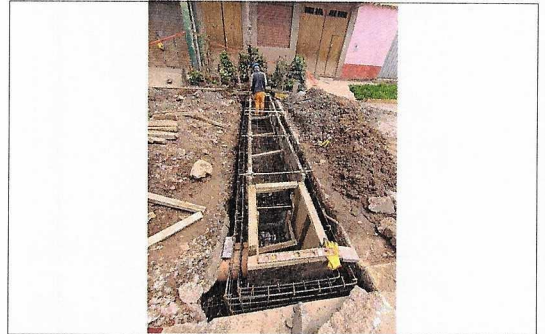
Colocado de acero y encofrado de sumidero en bocacalles.
