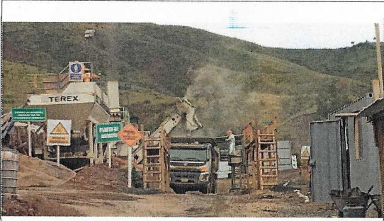
Planta de asfalto. Produccion para la 2da capa con el MAC 2 a partir del km. 1+550 carril izquierdo.
