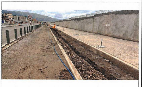
Trabajos para colocación de hidrante áreas verdes, progresiva 2+000.
