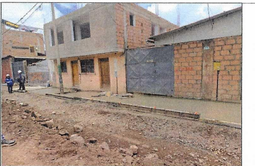
Vaciado de veredas en el Sector Túpac Amaru, margen derecha.
