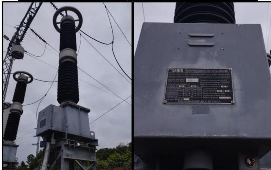
Asimismo, la celda de línea de Tarapoto hacia Moyobamba (L-1018), tiene fecha de placa de sus elementos que lo conforma como SL, TT y SB es del año 1997, los cuales al año 2028 tendrán una antigüedad mayor a 30 años, por lo que esta celda de línea requiere su cambio, las fotografías de las placas de los elementos de esta celda se muestran a continuación:
