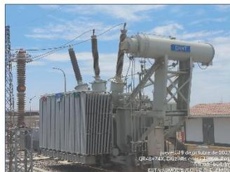
Transformador de Potencia de 100/126 MVA
