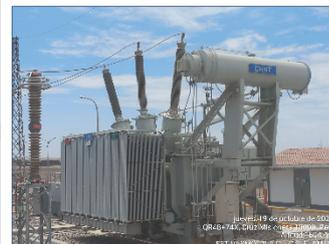
Transformador de Potencia de 100/126 MVA
