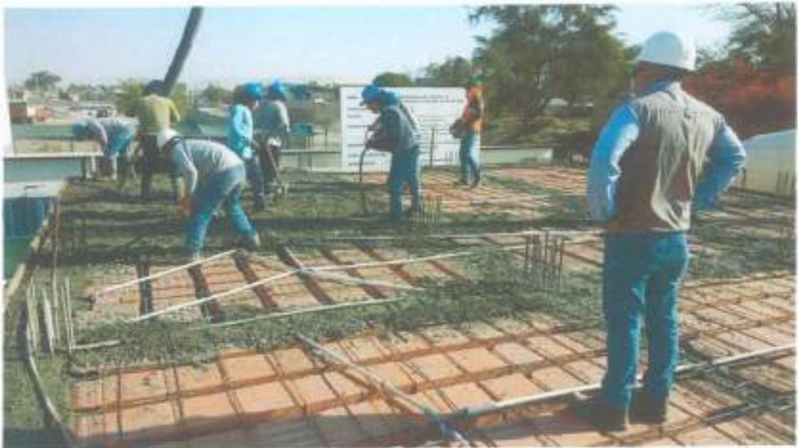
VIGAS - CONCRETO F'C=210KG/CM2. - LOSA ALIGERADA - CONCRETO F'C=210KG/CM2 - TUBERIA PVC-SAP ELECTRICA DE 25 mm
