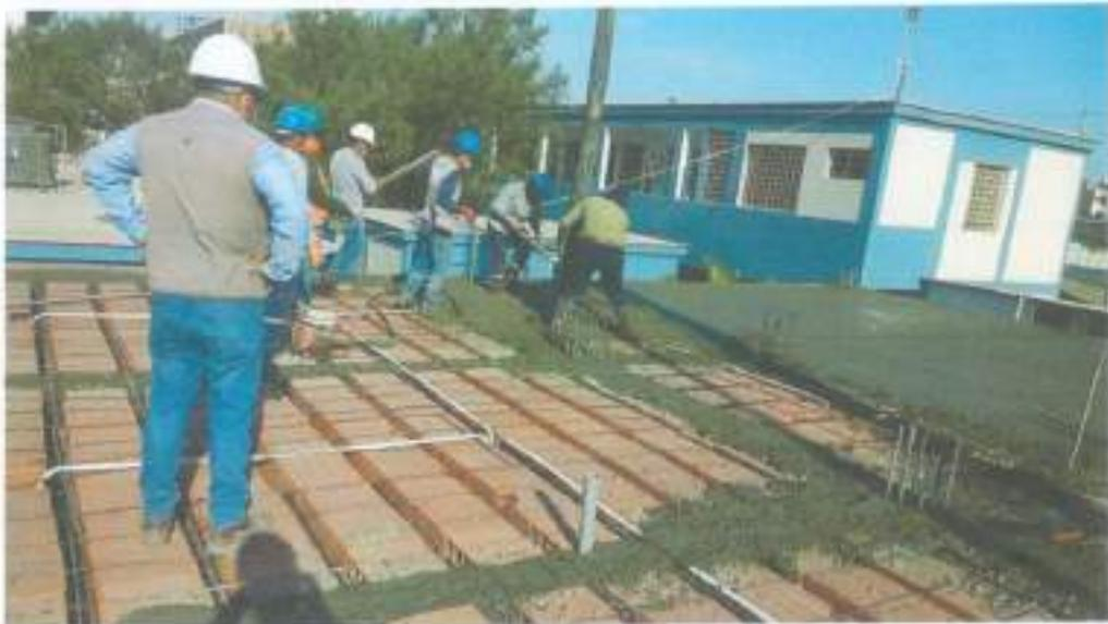
VIGAS - CONCRETO F'C=210KG/CM2. - LOSA ALIGERADA - CONCRETO F'C=210KG/CM2 - TUBERIA PVC-SAP ELECTRICA DE 25 mm
