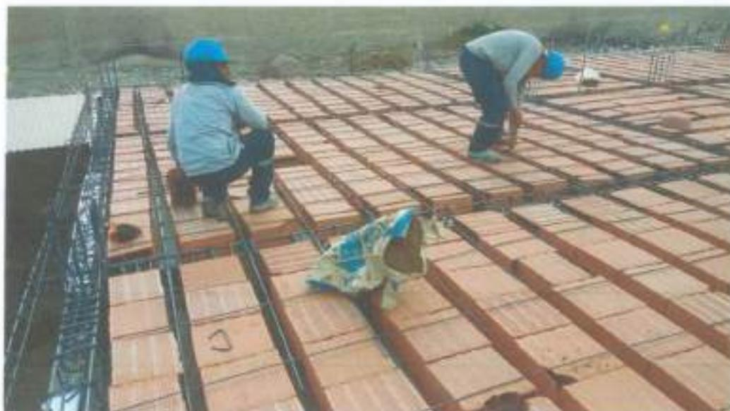
LOSA ALIGERADA - LADRILLO HUECO DE ARCILLA 15X30X30CM - LOSA ALIGERADA - ACERO
