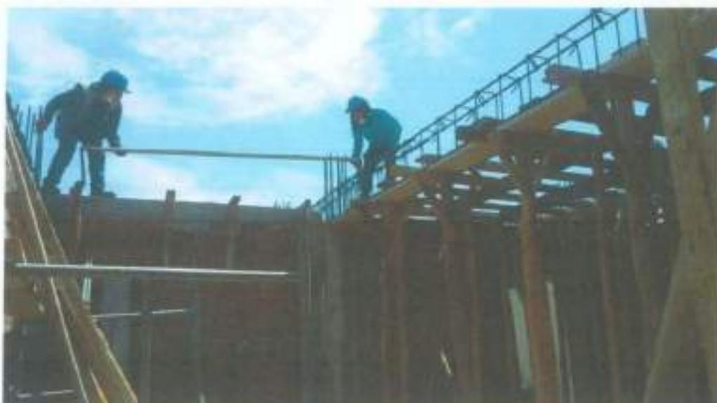
LOSA ALIGERADA - ENCOFRADO Y DESENCOFRADO NORMAL / VIGAS - ACERO  $FY=4200\text{KG}/\text{CM}^2$
