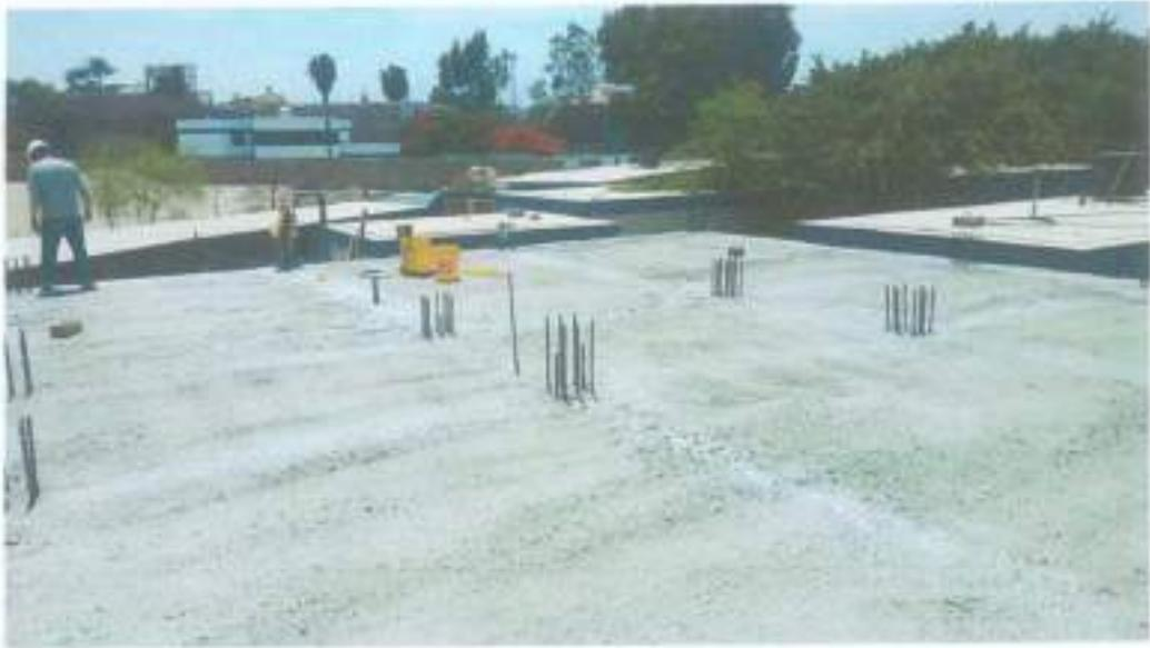
LOSA ALIGERADA - CONCRETO F'C=210KG/CM2
