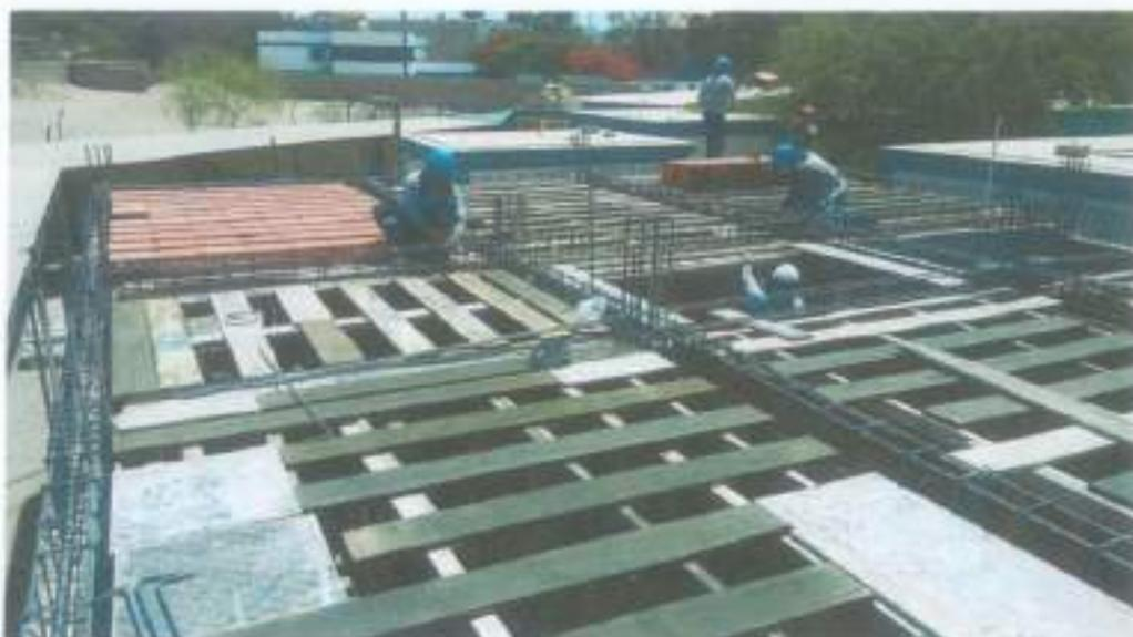
LOSA ALIGERADA - ENCOFRADO Y DESENCOFRADO NORMAL / VIGAS - ACERO  $FY=4200\text{KG}/\text{CM}^2$
