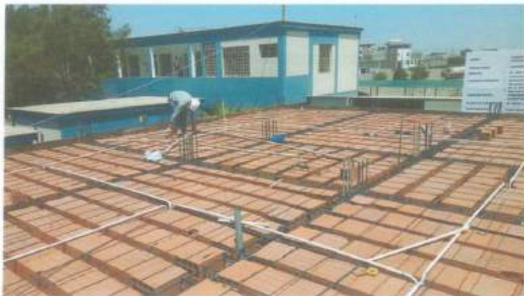
TUBERIA PVC-SAP ELECTRICA DE 25 mm- LOSA ALIGERADA - LADRILLO HUECO DE ARCILLA 15X30X30CM
