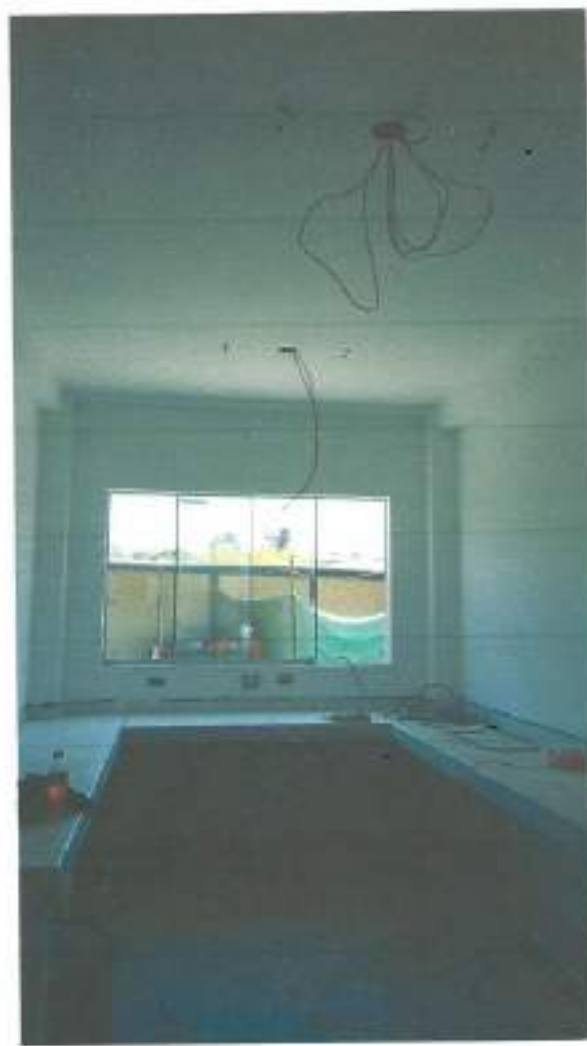
CABLEADO (SALIDA PARA ALUMBRADO DE TECHO)
