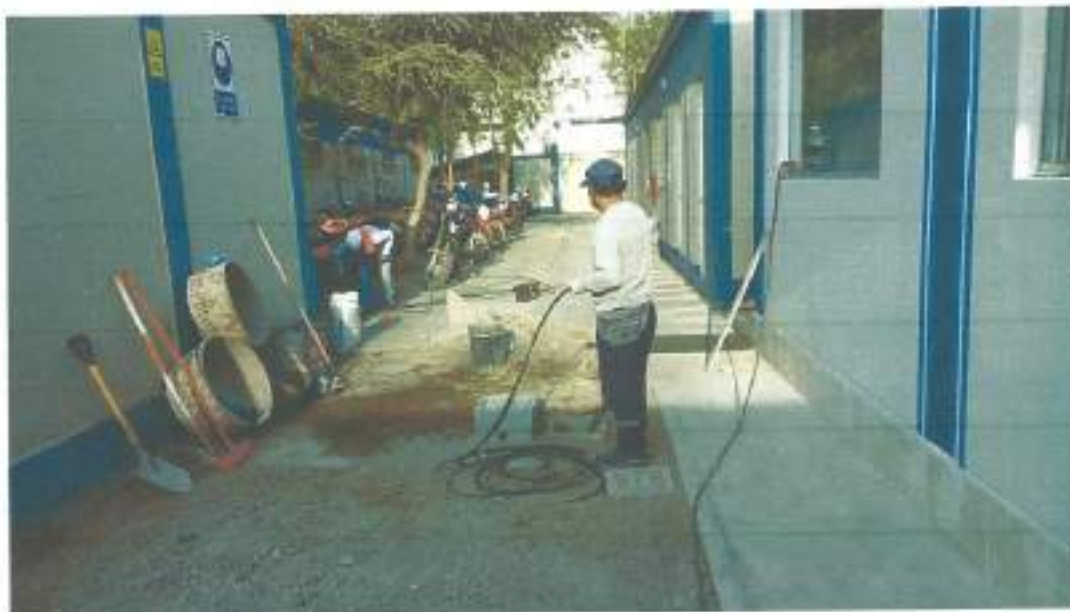
INSTALACION DE ACOMETIDA
