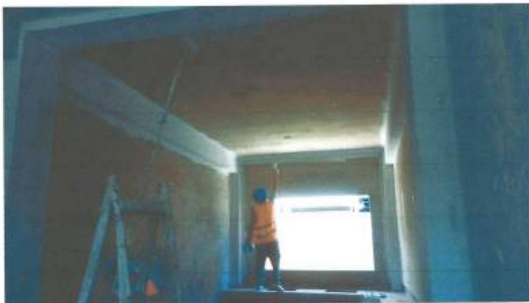
PINTURA LATEX EN VIGAS DOS MANOS
