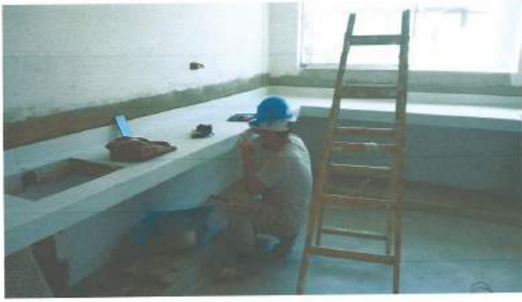
ENCHAPE DE MESA DE CONCRETO CON PORCELANATO DE 0.60X0.60
