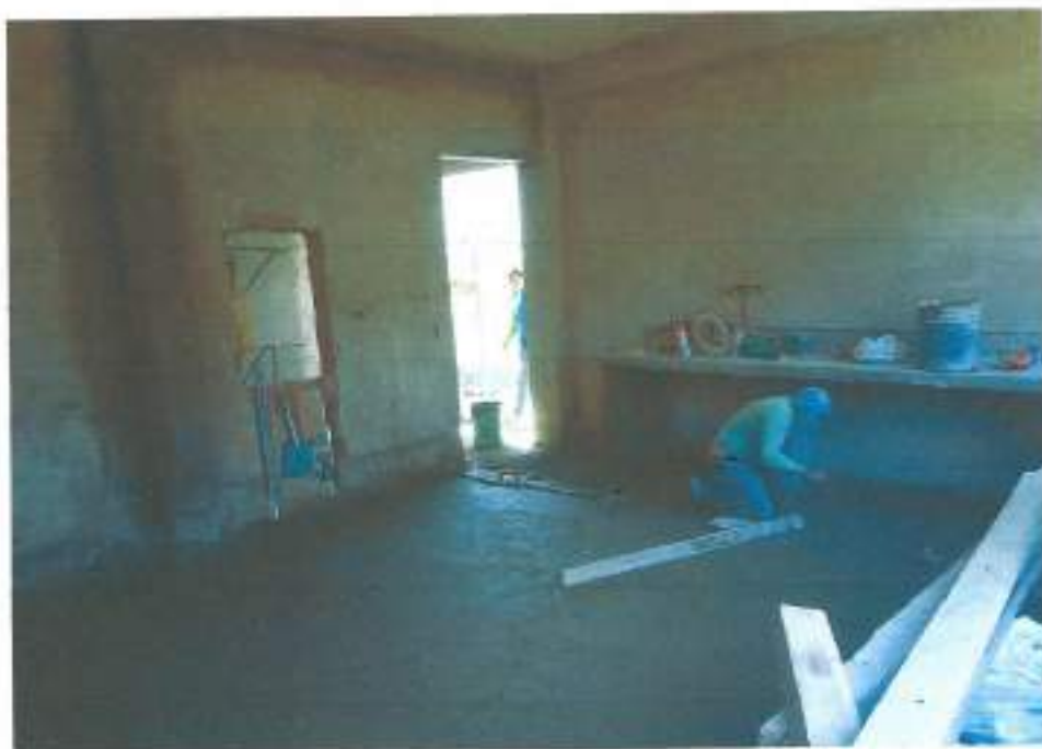
CONTRAPISO E=40MM (MEZCLA C:A BASE 1:5 ACABADO 1:2)
