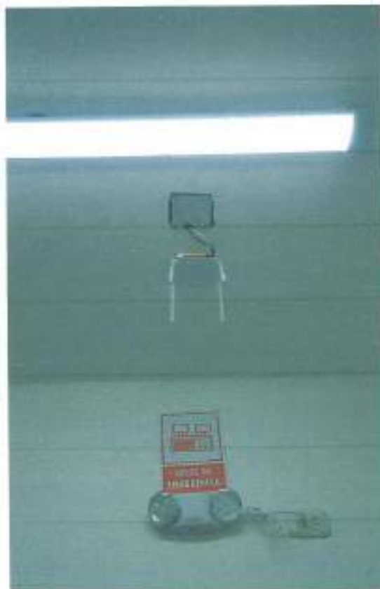
ARTEFACTO PARA LUZ DE EMERGENCIA CON EQUIPO Y LAMPARA DE 2x22 w/ PLACA CON ACCESORIOS PARA REPETIDOR O ROUTER EN TECHO DE 4 CANALES
