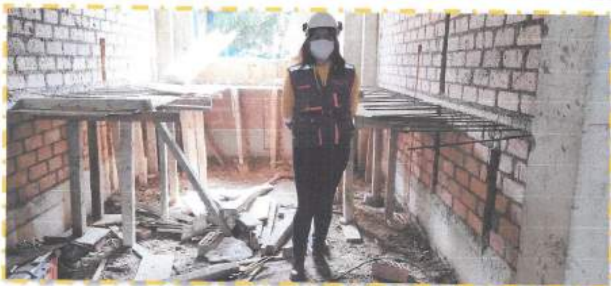
Fotografía N° 09: la supervisión verifica el encofrado de la mesada.
