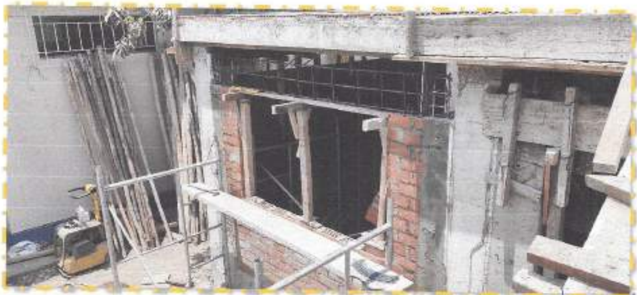
Fotografía N° 02: en la imagen se aprecia a la columneta y armado de acero en los dinteles.
