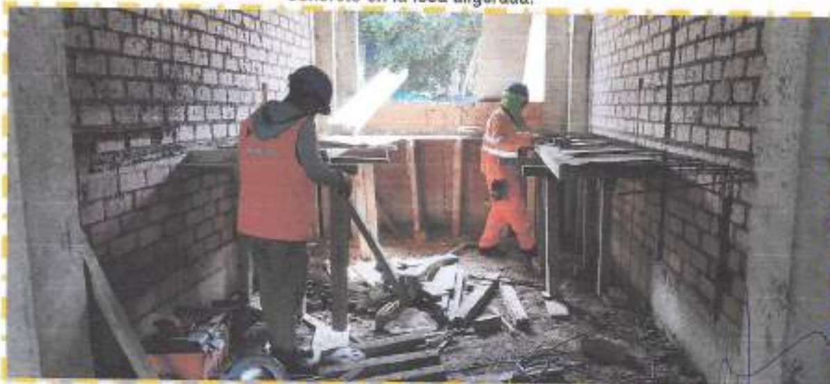
Fotografía N° 08: en la imagen se aprecia el encofrado de las mesadas interiores.
