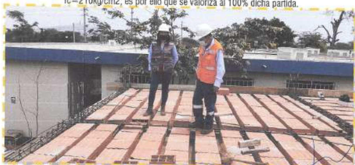
Fotografía N° 05: la ingeniera supervisor y el residente de obra verifican la colocación de ladrillos de techo, las dimensiones de las vigas, VB, etc.
