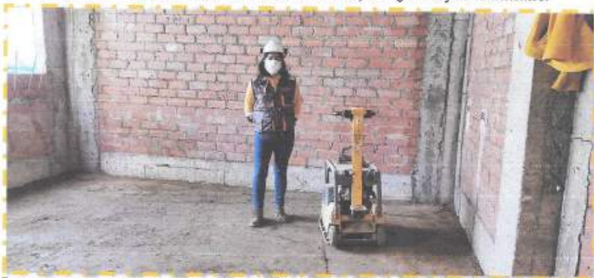
Fotografía N° 16: la supervisión verifica la compactación del material de préstamo en el ambiente interior.
