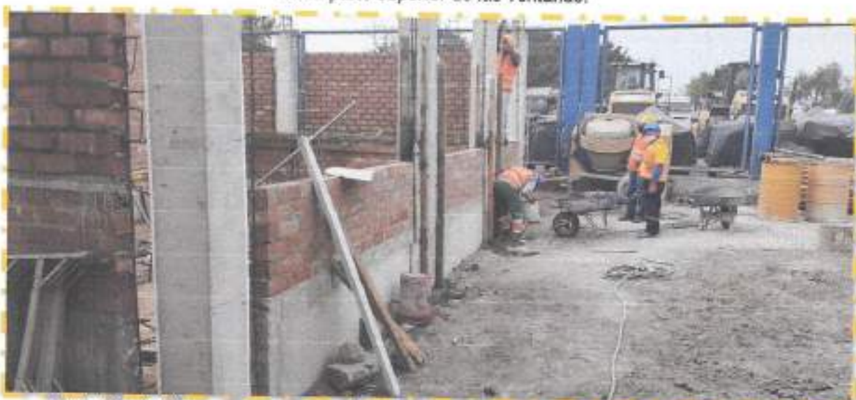
Fotografía N° 04: se aprecia que todas las columnas se encuentran vaciadas con concreto f_c=210\text{kg/cm}^2 , es por ello que se valoriza al 100% dicha partida.
