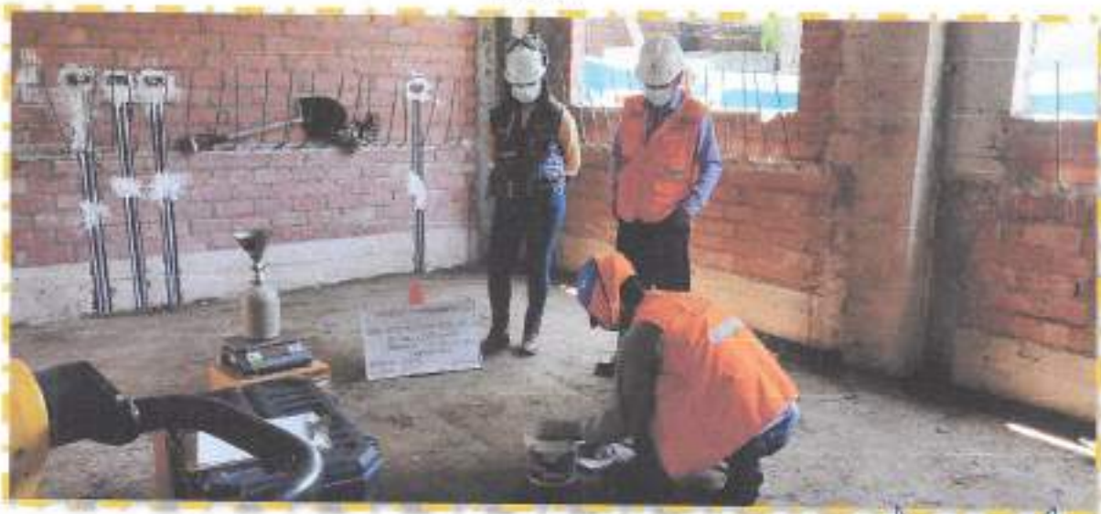
Fotografía N° 17: se verifica la correcta realización del ensayo de compactación por método de cono de arena en el ambiente interior, para su posterior vaciado de concreto simple-en-falso simple.
