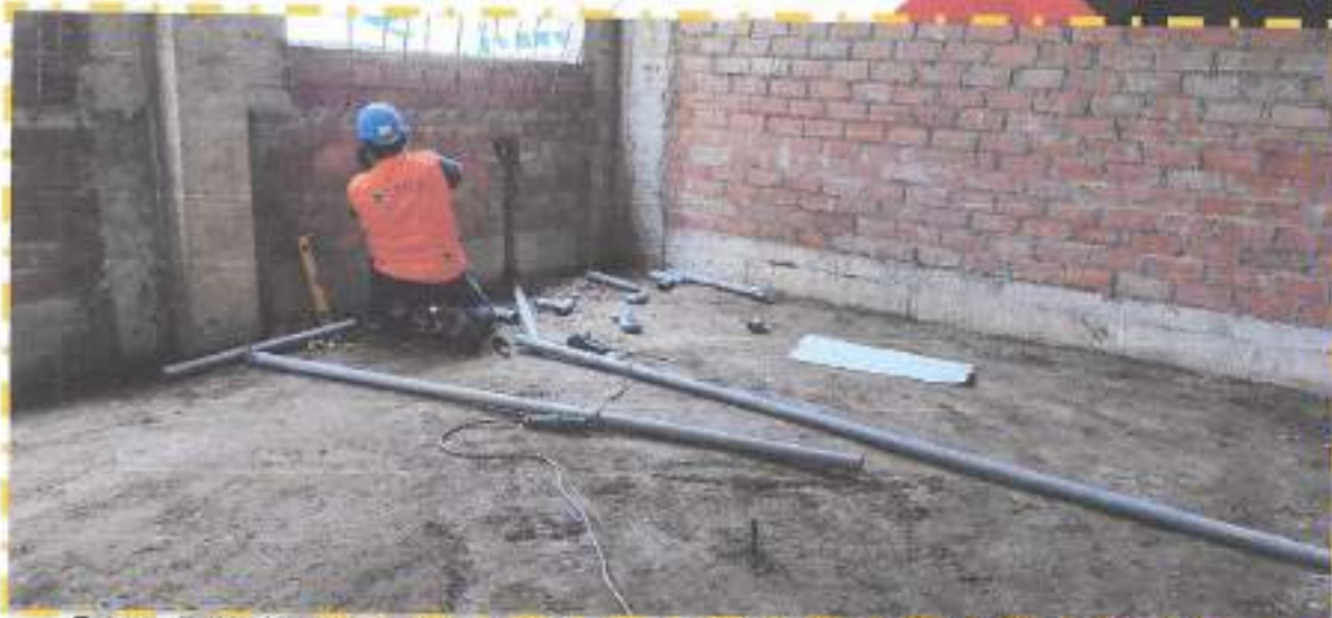
Fotografía N° 15: se aprecia la instalación de tuberías para agua fría y tomacorrientes.
