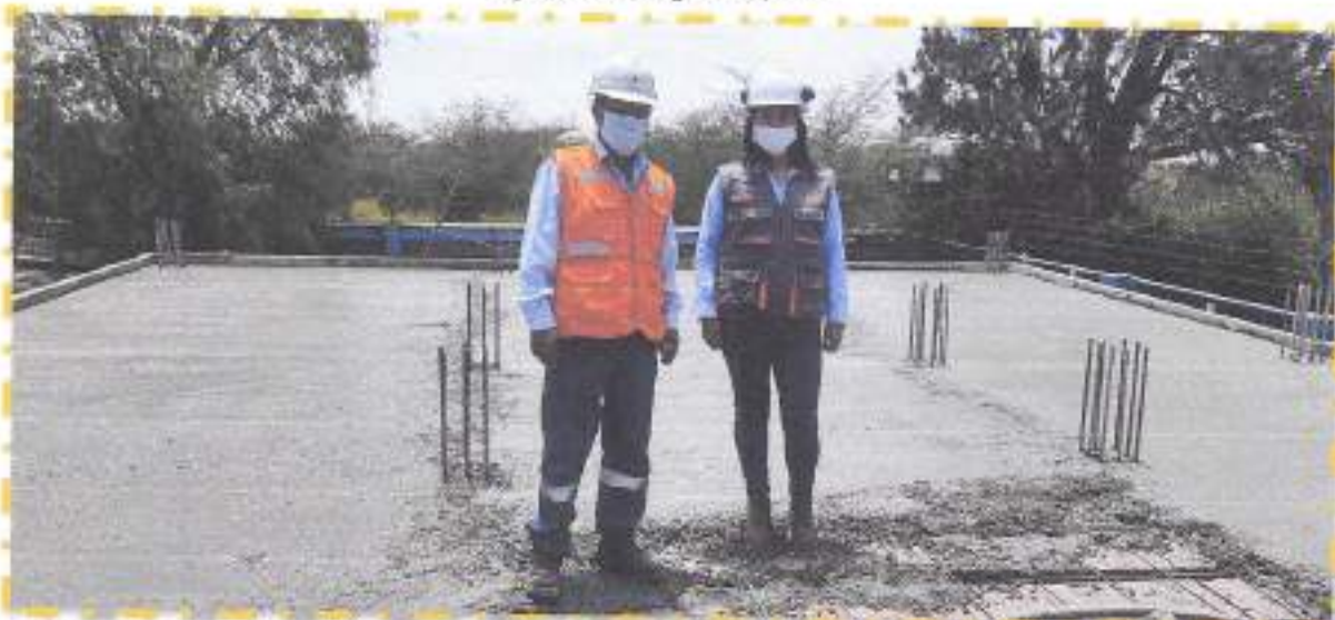
Fotografía N° 07: los ingenieros encargados de la ejecución de obra verifican el vaciado de concreto en la losa aligerada.
