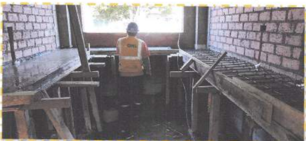
Fotografía N° 10: se aprecia el armado de acero y vaciado de concreto en las mesadas.
