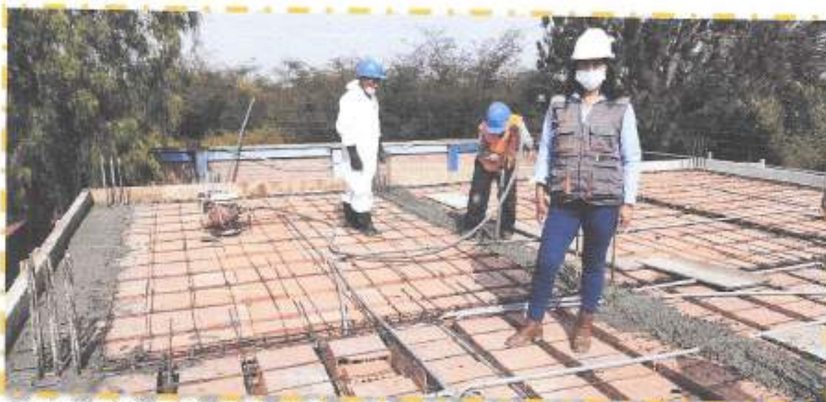
Fotografía N° 06: la supervisora de obra verifica el vaciado de concreto f_c=210\text{kg/cm}^2 en las vigas, losa aligerada, etc.
