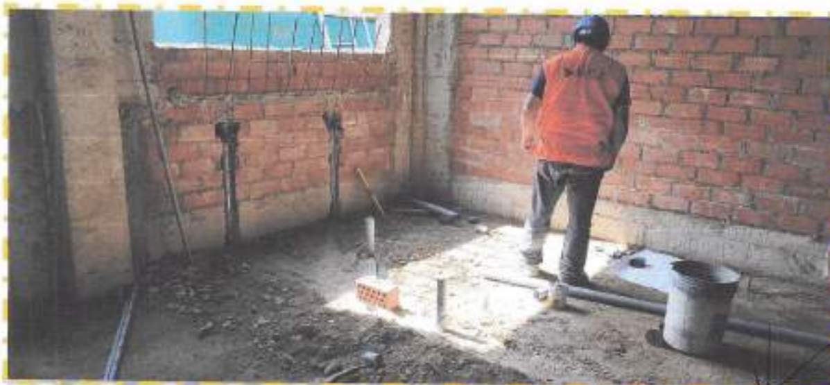
Fotografía N° 14: se aprecia la instalación de tuberías para tomacorrientes.
