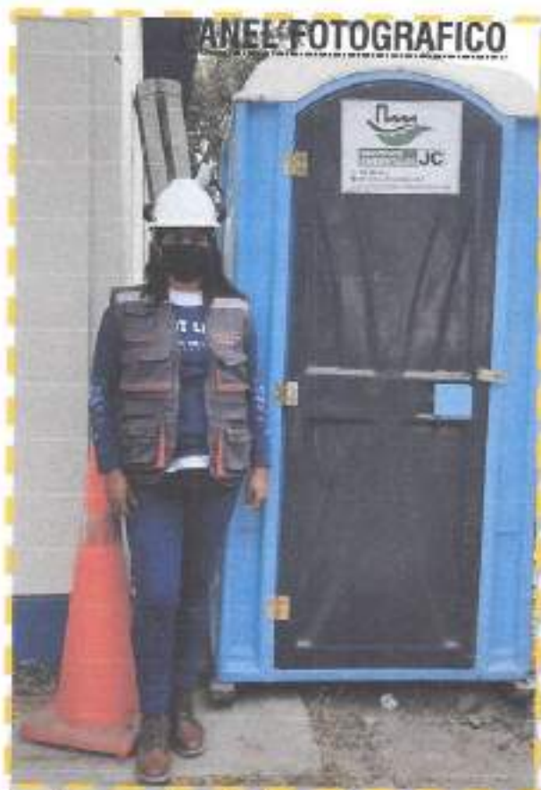
Fotografía N° 01: la ingeniera supervisor de obra verifica la instalación del SS.HH portátil y su correcta funcionamiento.
