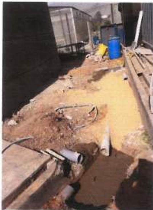
Vista fotográfica, donde se aprecia trabajos para buzón de agua. 04/11/2021
