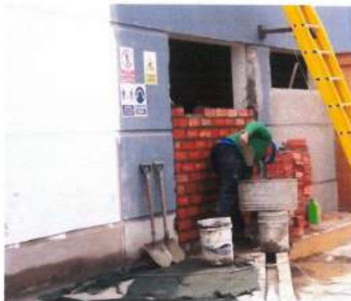
Vista fotográfica de trabajos en asentado de ladrillo de la pared exterior del ambiente Sala de incubación 19/11/2021.
