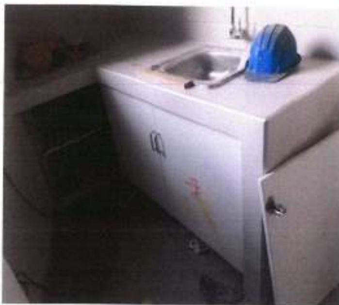
Vista fotográfica donde se aprecia trabajos en melamina 29/11/2021.
