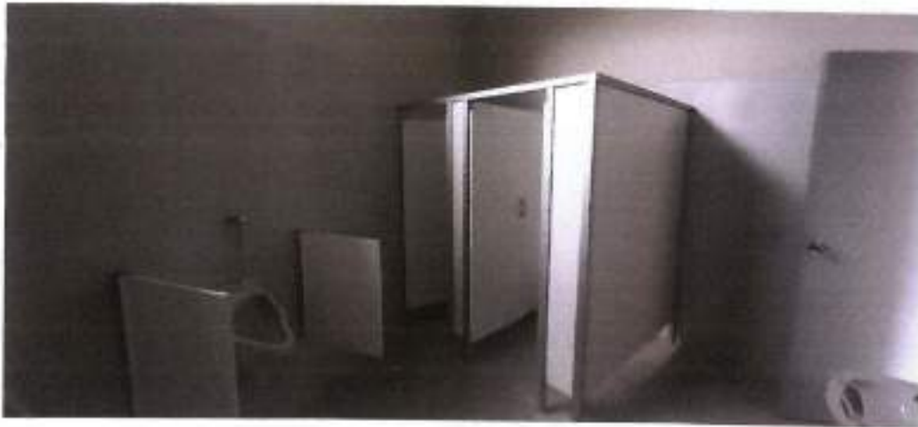
Vista del baño de varones 30 /11/2021.
