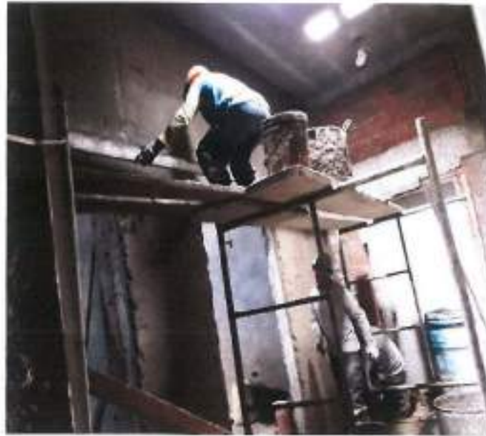
Vista fotográfica de trabajos en tarrajeo de pared en ambiente Sala de Refrigeración 05/11/2021.
