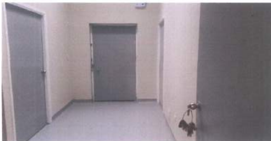
Vista fotográfica donde se aprecia el instalado de todas las puertas con sus respectivos accesorios 02/11/2021.
