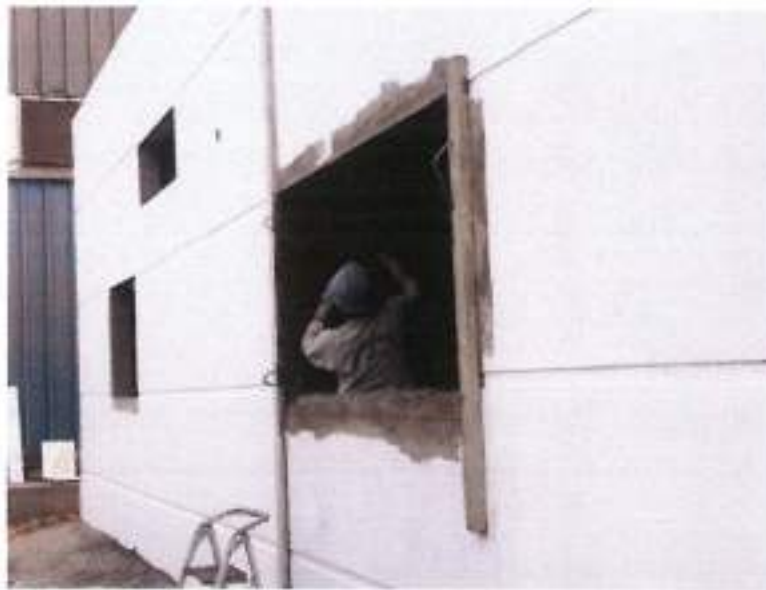
Vista fotográfica, de trabajos en acabados de derrames en ventanas. 05/11/2021
