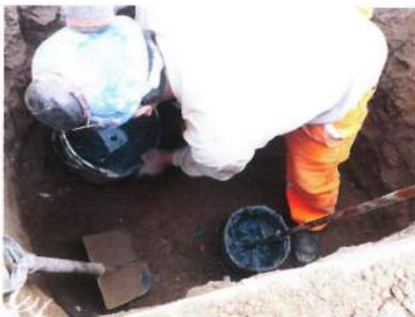
Vista fotográfica, donde se aprecia los trabajos del colocado de cemento conductivo para la instalación de puesta a tierra 11/11/2021.
