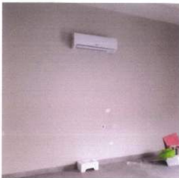
Vista fotográfica donde se aprecia el instalado del aire acondicionado 30 /11/2021.
