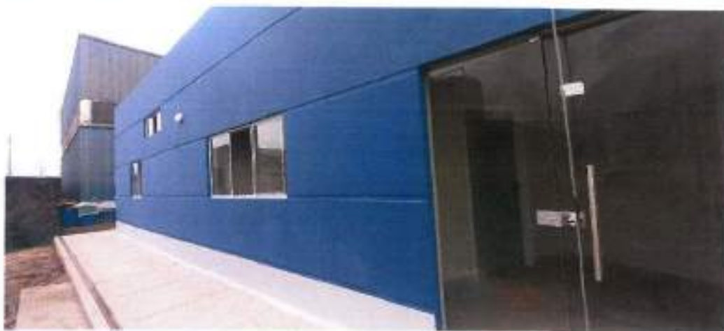
Vista fotográfica donde se aprecia el exterior del laboratorio 30 /11/2021.
