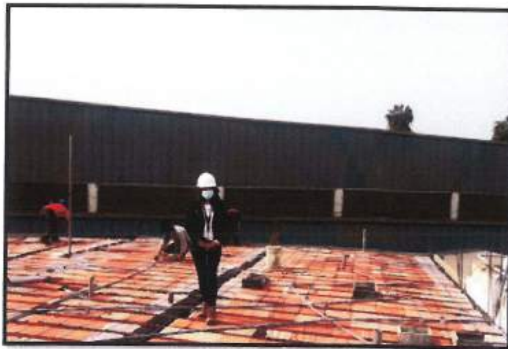
Vista Fotográfica Verificando que los trabajadores cuenten con sus EPPs completos en Obra.
