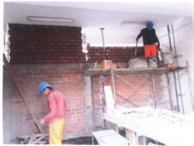
Vista fotográfica de asentado de ladrillo en Sala de Incubación. 12/11/2021
