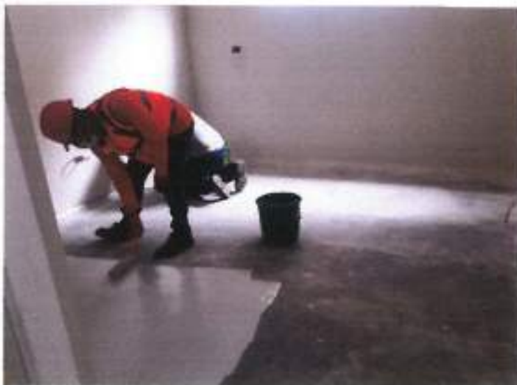
Vista fotográfica de trabajos de instalación de piso epóxico en ambientes e obra 26/11/2021
