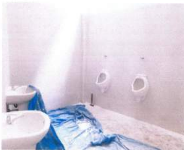
Vista fotográfica de instalación de de urinarios en SS. HH. Hombres 20/11/2021
