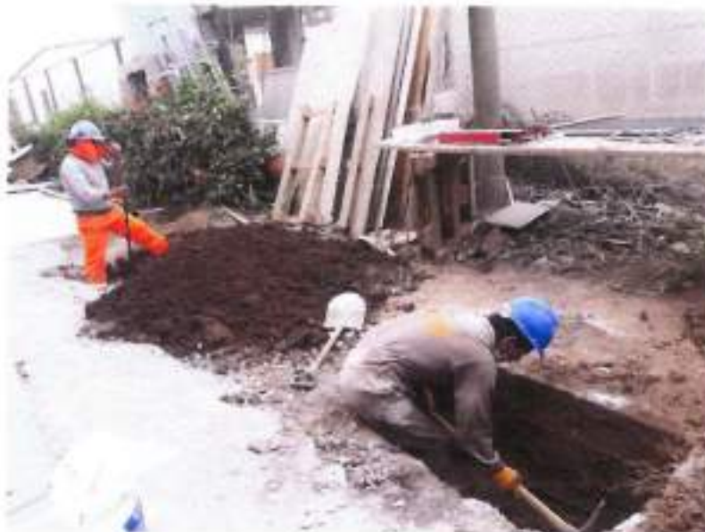
Vista fotográfica, donde se aprecia los trabajos de excavación para la puesta en tierra 10/11/2021
