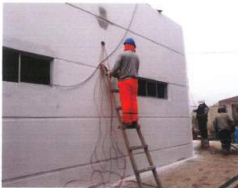
Vista fotográfica de trabajos de cableado eléctrico 23/11/2021.
