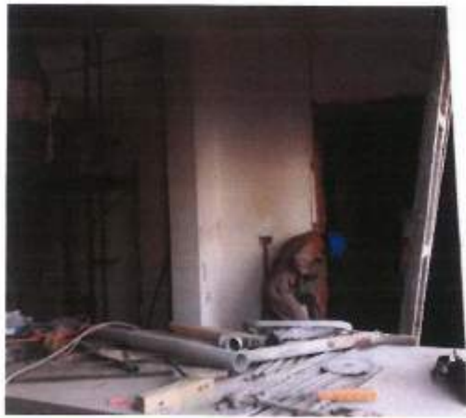
Vista fotográfica de trabajos de demolición en pared del interior de Sala de Incubación. 05/11/2021
