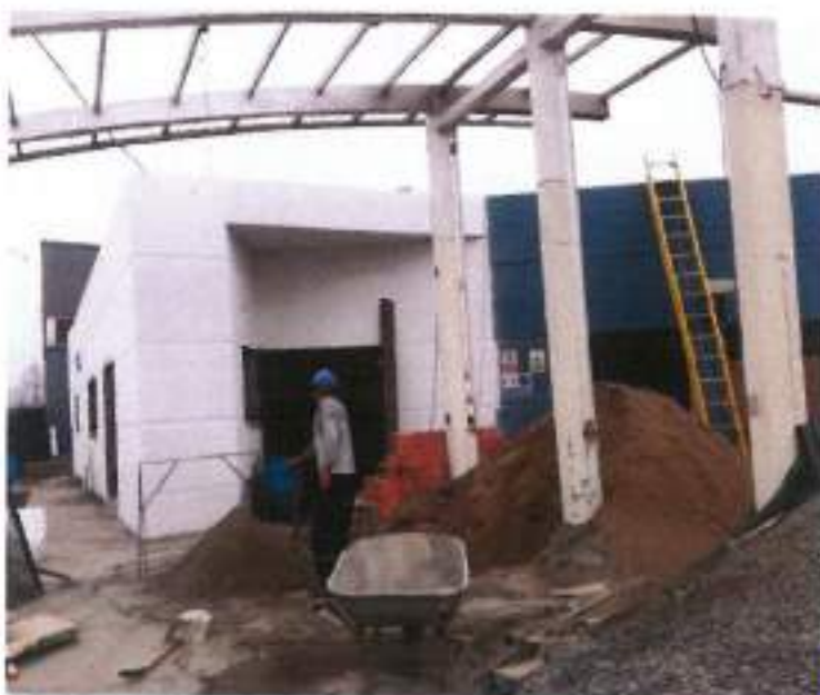
Vista panorámica del pintado de paredes exteriores con pintura base del Laboratorio. 04/11/2021
