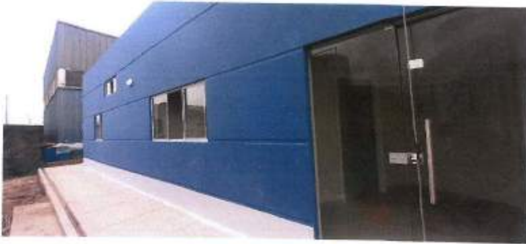
Vista fotográfica donde se aprecia el exterior del laboratorio 30 /11/2021.
