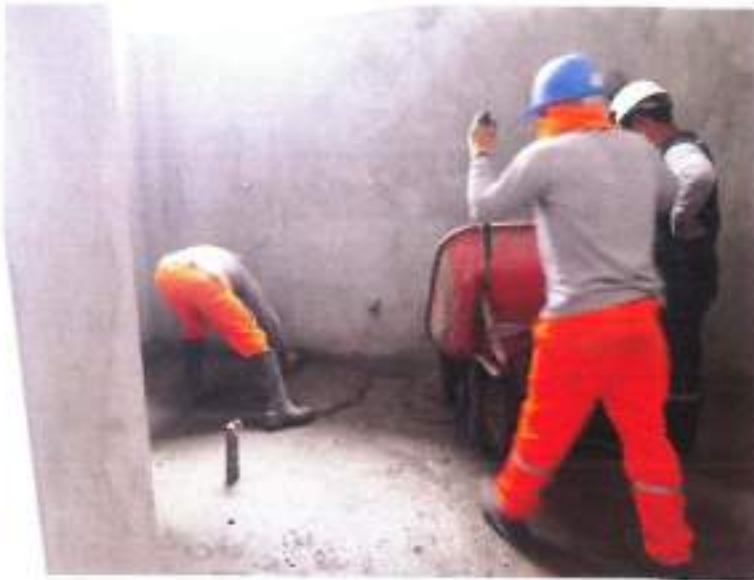
Vista fotográfica, donde se aprecia trabajos de vaciado de concreto en piso 08/11/2021
