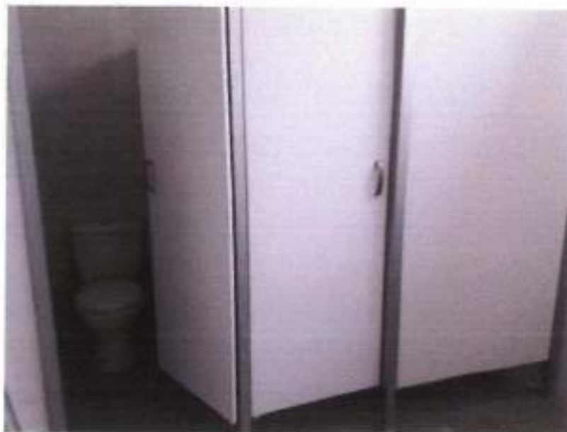
Vista fotográfica donde se aprecia el instalado de puertas en los SS. HH. MUJERES 27/11/2021.
