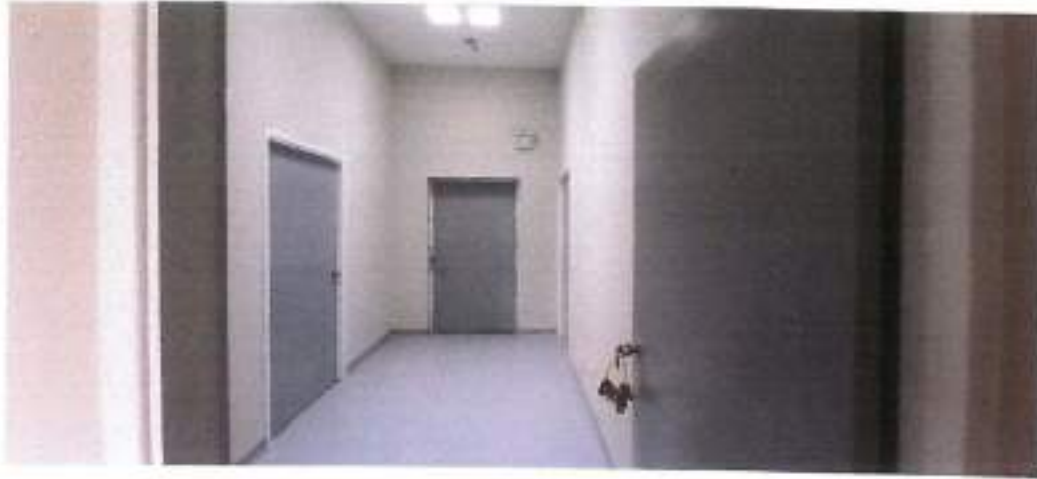
Vista fotográfica donde se aprecia el pasadizo del laboratorio 30 /11/2021.
