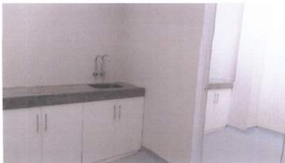
Vista fotográfica donde se aprecia el instalado final de las mesas de granito con sus respectivos accesorios en ambiente Sala de Incubación 01/12/2021.
