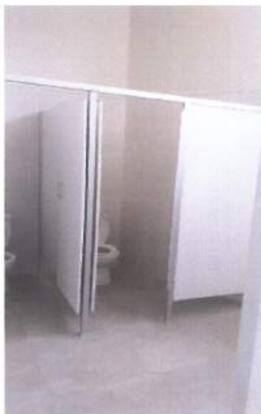
Vista fotográfica donde se aprecia la finalización del ambiente SS.HH damas 02/11/2021
