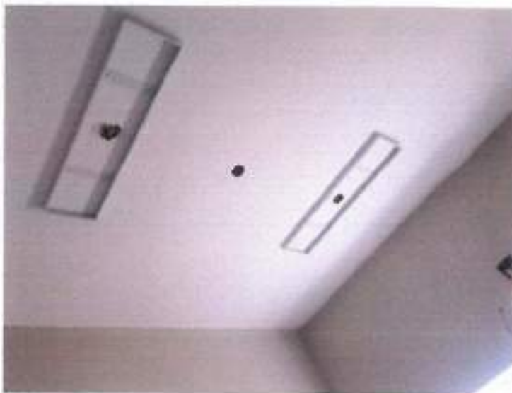
Vista fotográfica de instalación de luces led en techo de los ambientes de la obra 25/11/2021
