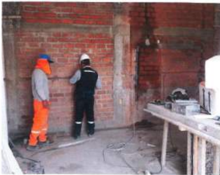
Vista fotográfica, donde se aprecia trabajos de instalación de tuberías para cableado 08/11/2021
