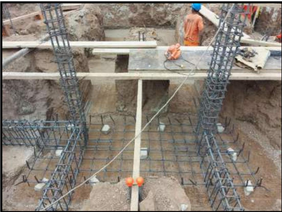
VERIFICACION DE ANCLAJE DE ARMADURA DE VIGAS DE CIMENTACION DE
