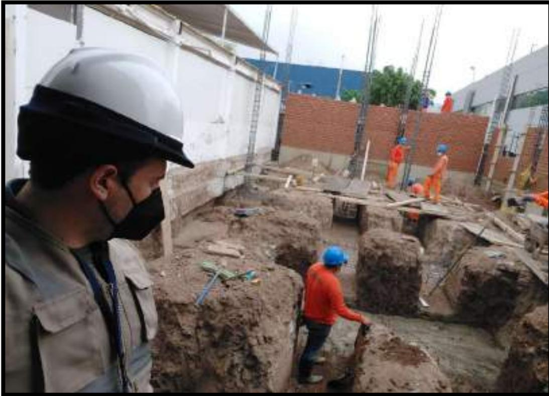
VERIFICACION DEL AVANCE DEL TRABAJO DE EXCAVACION TOTAL DE ZANJAS EN ZAPATAS Y CIMENTACION CONFORME AL PROYECTO
