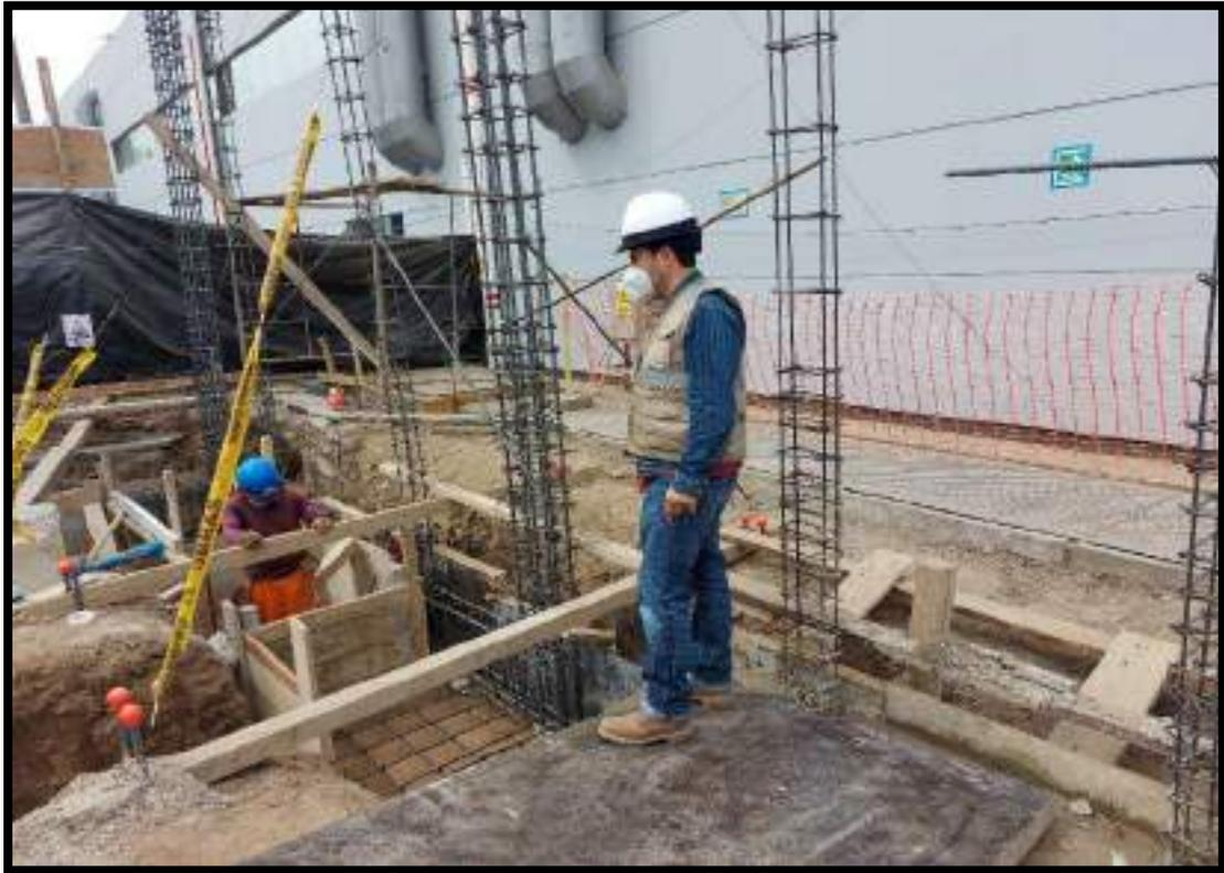
VERIFICACION DEL ENCOFRADO DE ZAPATAS, Y VIGAS DE CIMENTACION
