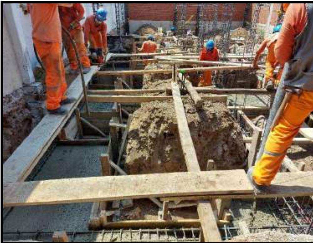
VERIFICACION DEL USO ADECUADO DE VIBRADOR DE CONCRETO EN EL PROCESO DE COLOCACION DE CONCRETO PREMEZCLADO
