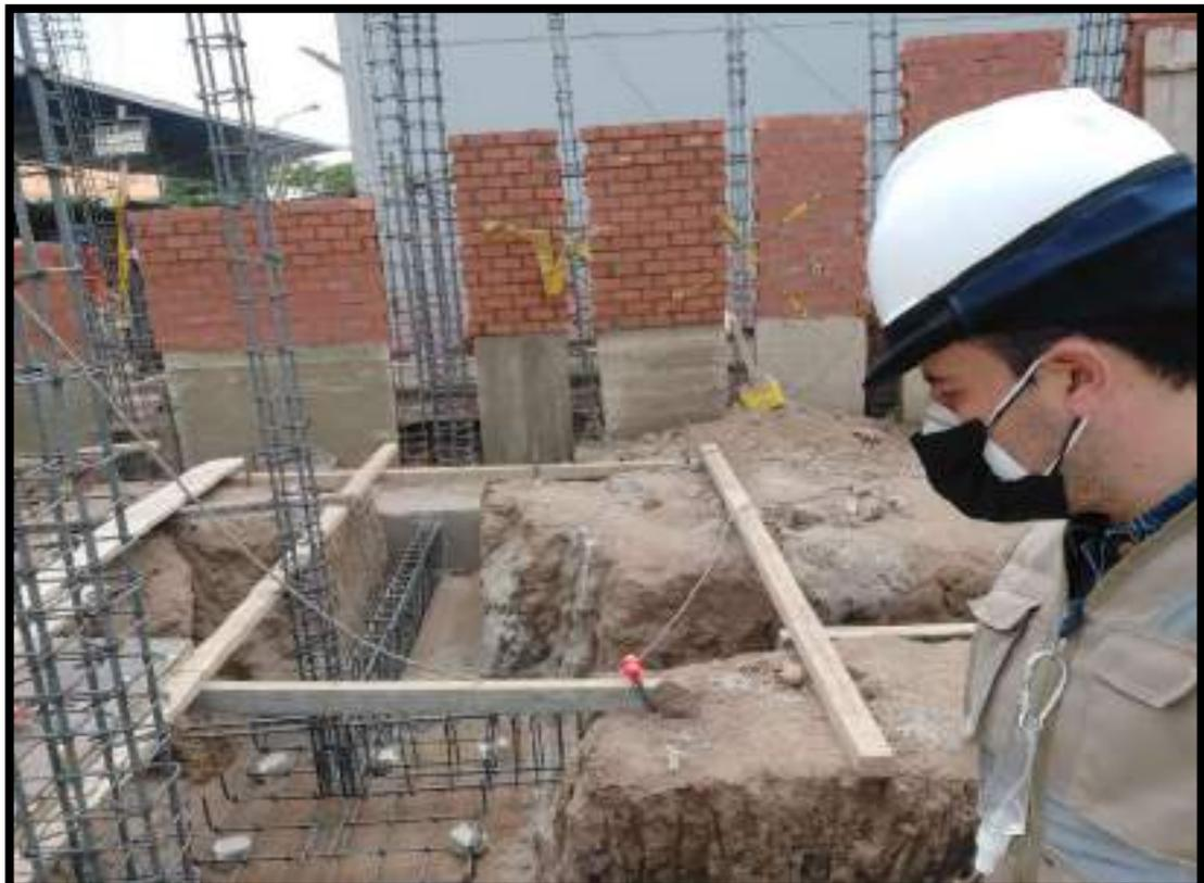
VERIFICACION DE ANCLAJE DE ARMADURA DE VIGAS DE CIMENTACION DE TODOS LOS EJES RESTANTES
