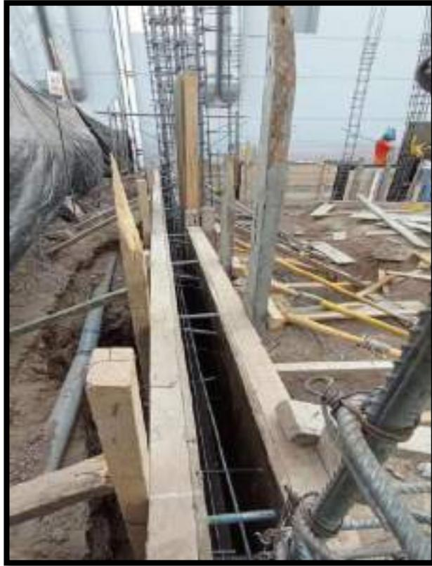
VERIFICACION DEL ENCOFRADO EN SOBRECIMENTOS DE LOS EJES 5-5 Y D-D
