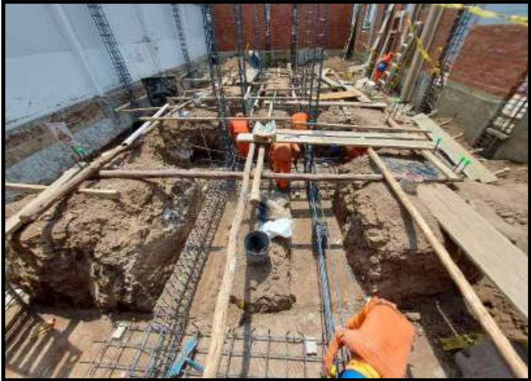
VERIFICACION DE CONFORMACION Y ANCLAJE DE ARMADURA DE VIGAS DE CIMENTACION Y ZAPATAS DE TODOS LOS EJES RESTANTES
