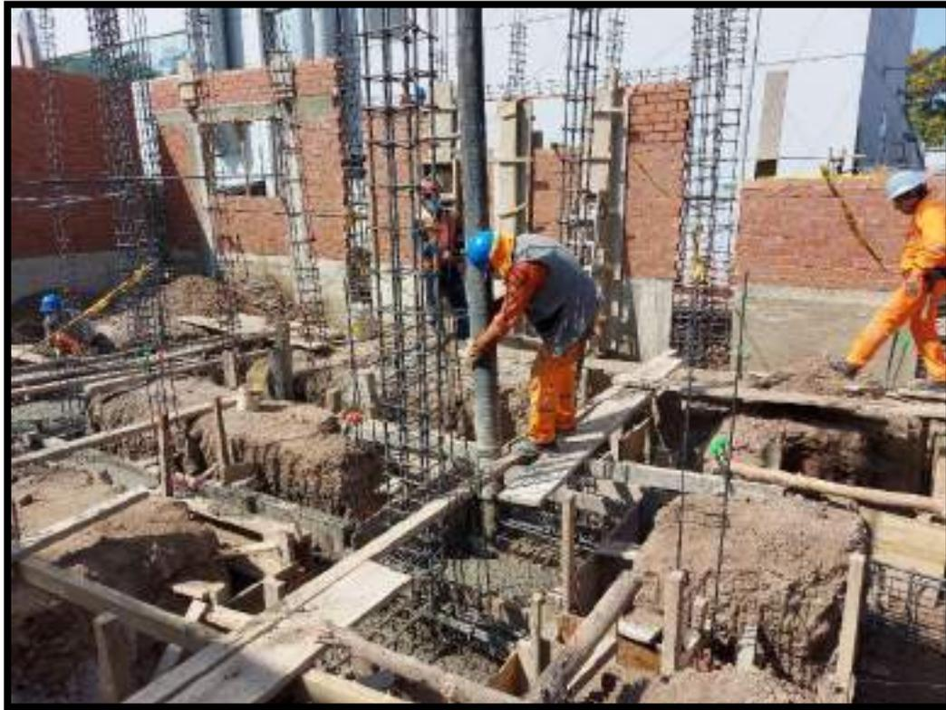
PROCESO DE COLOCACION DE CONCRETO PREMEZCLADO F´C=210KG/CM2 EN ZAPATAS Y VIGAS DE CIMENTACION DE TODOS LOS EJES RESTANTES
