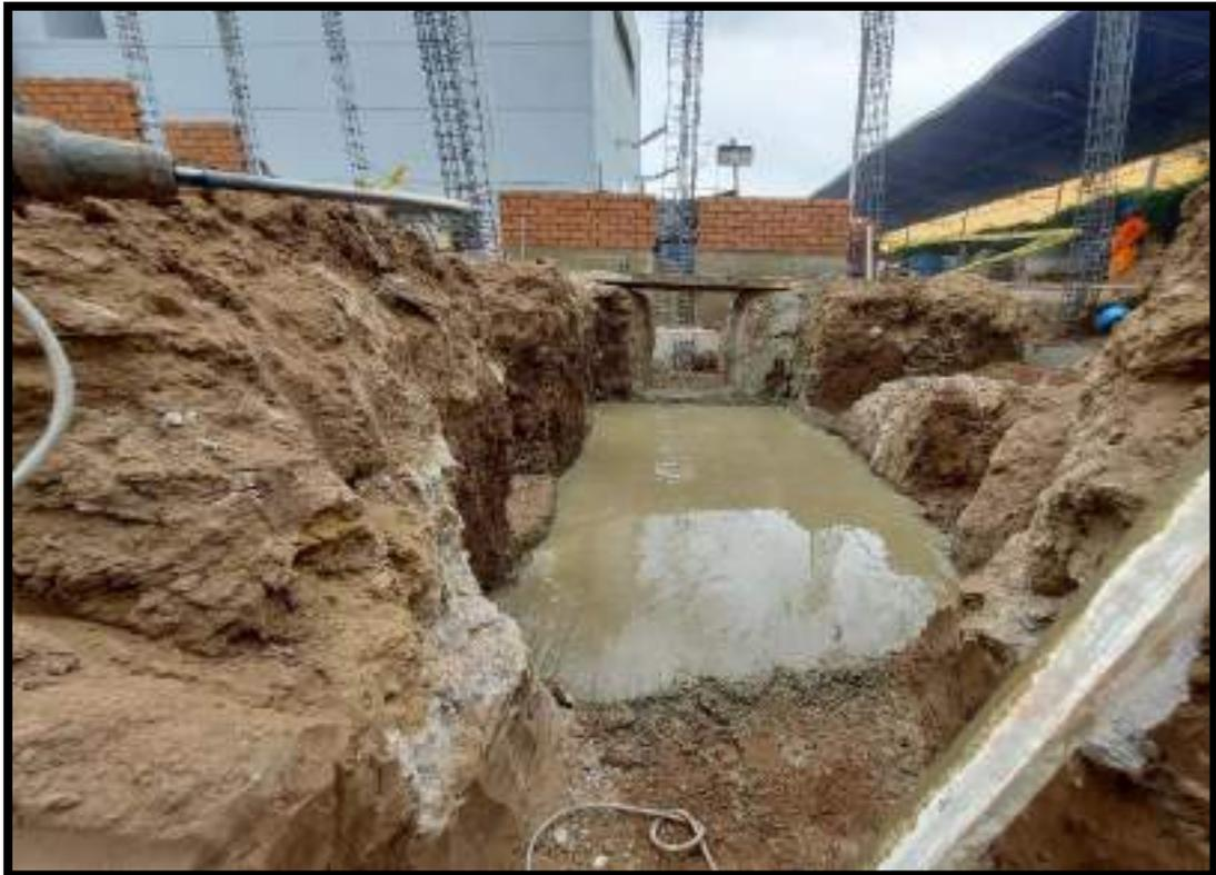
VERIFICACION DEL LLENADO DE CONCRETO F'C=100KG/CM2 EN FALSAS ZAPATAS
