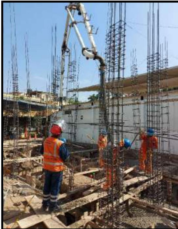
PROCESO DE COLOCACION DE CONCRETO PREMEZCLADO F'C=210KG/CM2 EN ZAPATAS Y VIGAS DE CIMENTACION DE TODOS LOS EJES RESTANTES
