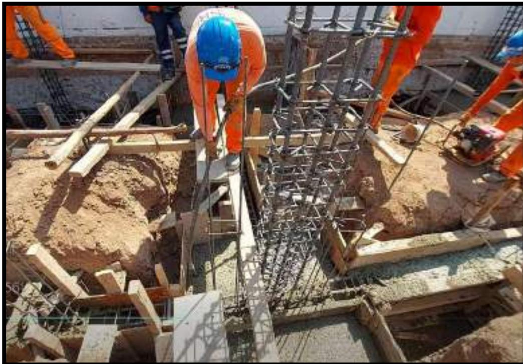
VERIFICACION DEL USO ADECUADO DE VIBRADOR DE CONCRETO EN EL PROCESO DE COLOCACION DE CONCRETO PREMEZCLADO
