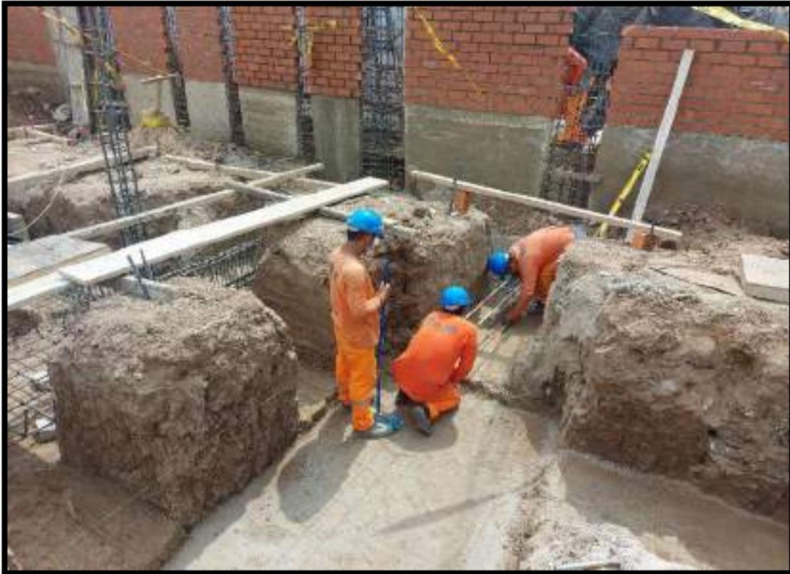
VERIFICACION DE TRAZO Y CONFORMACION DE LA ARMADURA PARA VIGAS DE CIMENTACION DE TODOS LOS EJES RESTANTES
