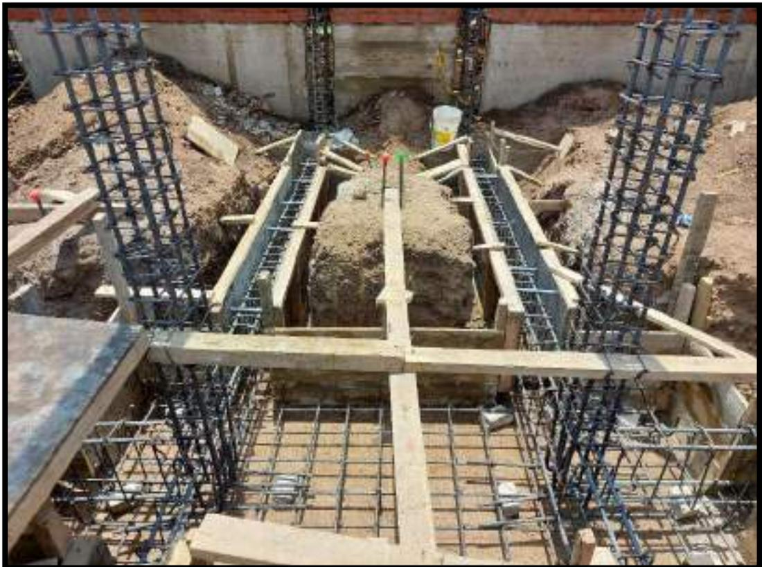
VERIFICACION DE ENCOFRADO Y ANCLAJE DE ARMADURA DE VIGAS DE CIMENTACION, ZAPATAS Y COLUMNAS DE TODOS LOS EJES RESTANTES
