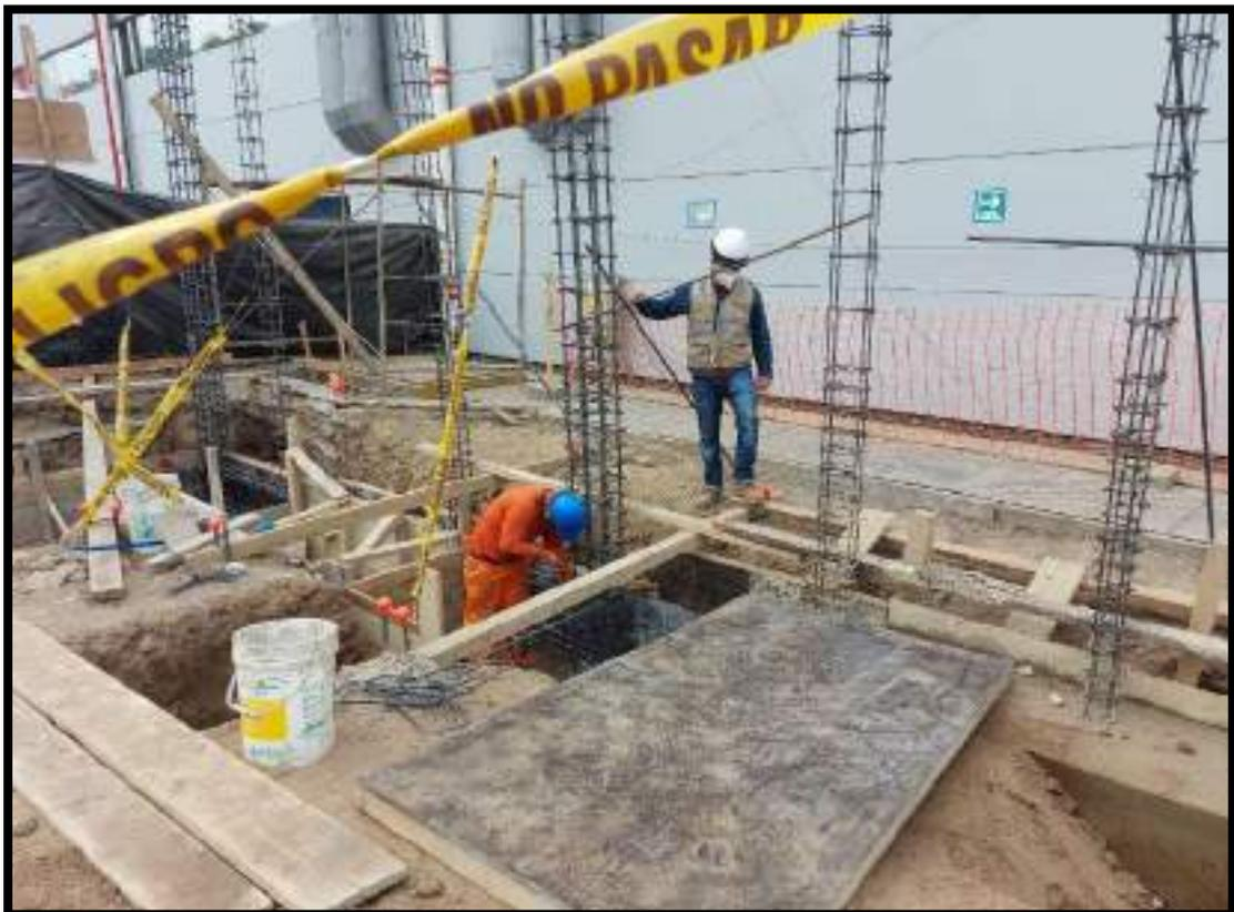
VERIFICACION DEL ENCOFRADO DE ZAPATAS, Y VIGAS DE CIMENTACION
