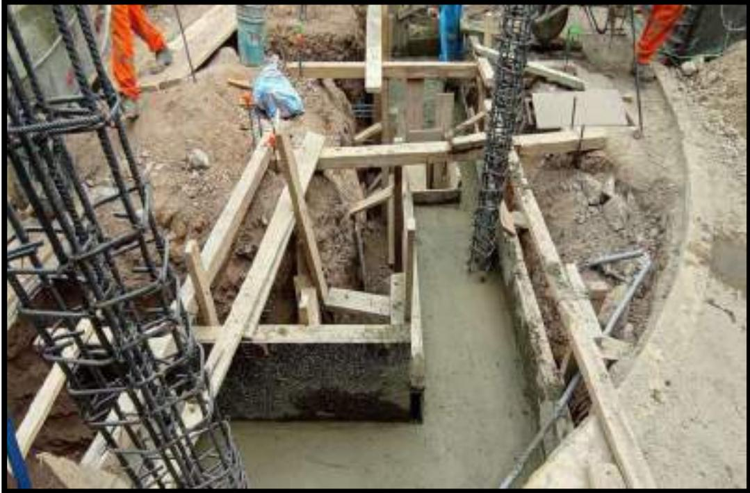
COLOCACION DE CONCRETO F'C=210KG/CM2 PREMEZCLADO EN ZAPATAS, Y VIGAS DE CIMENTACION EL EJE D-D
