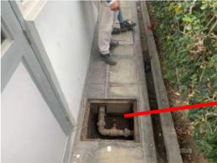
Válvula de Red de Agua de 2", con Tubería PVC de 2".
