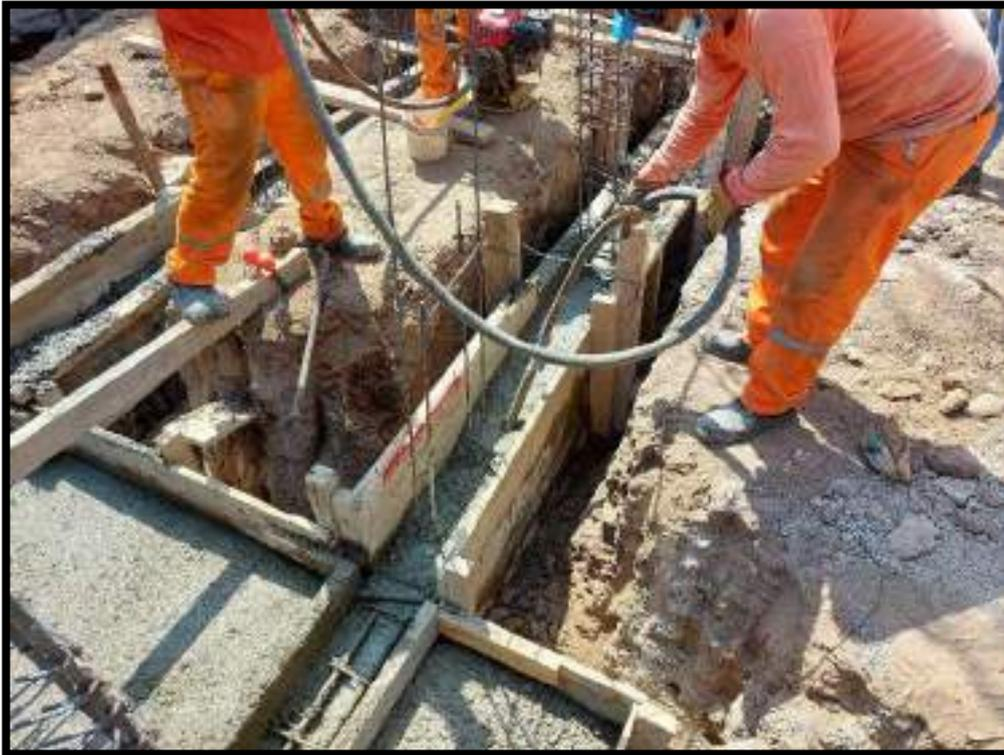
VERIFICACION DEL USO ADECUADO DE VIBRADOR DE CONCRETO EN EL PROCESO DE COLOCACION DE CONCRETO PREMEZCLADO
