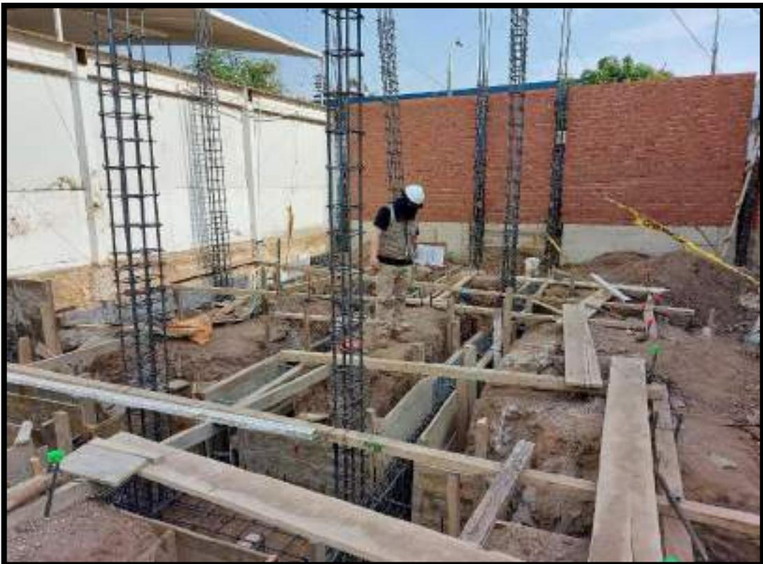
VERIFICACION FINAL DE ENCOFRADO Y ANCLAJE DE ARMADURA DE VIGAS DE CIMENTACION, ZAPATAS Y COLUMNAS DE TODOS LOS EJES RESTANTES
