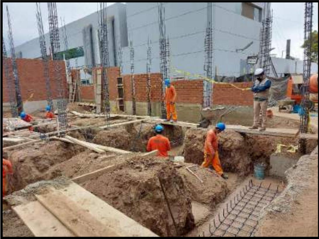
VERIFICACION GENERAL DE ANCLAJE DE ARMADURA DE ZAPTAS EN TODOS
