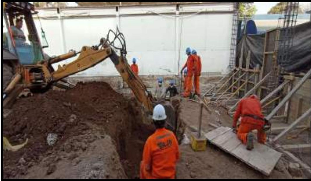
CONTINUIDAD DE LOS TRABAJOS DE EXCAVACION DE ZANJAS CON EL USO DE MAQUINARIA
