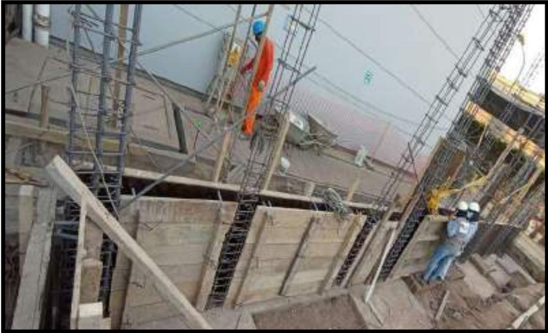
VERIFICACION DEL ENCOFRADO DE SOBRECIMIENTO EL EJE D-D
