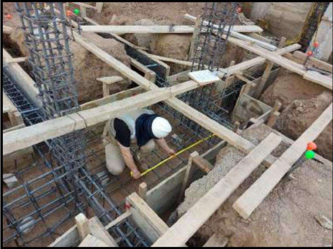
VERIFICACION DEL DIMENSIONAMIENTO Y ACERO ESPECIFICADO EN ARMADURAS DE VIGAS DE CIMENTACION, ZAPATAS Y COLUMNAS DE TODOS LOS EJES RESTANTES
