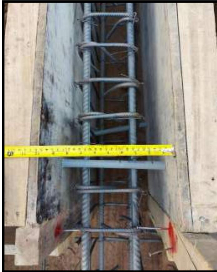
VERIFICACION DE RECUBRIEMIENTO EN ANCHO Y ALTURA DE ARMADURA DE VIGAS DE CIMENTACION, ZAPATAS Y COLUMNAS DE TODOS LOS EJES
