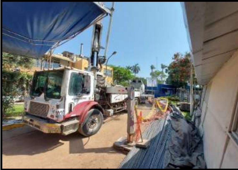
UTILIZACION DE CONCRETO PREMEZCLADO F'C=210KG/CM2 PARA ZAPATAS Y VIGAS DE CIMENTACION DE TODOS LOS EJES RESTANTES
