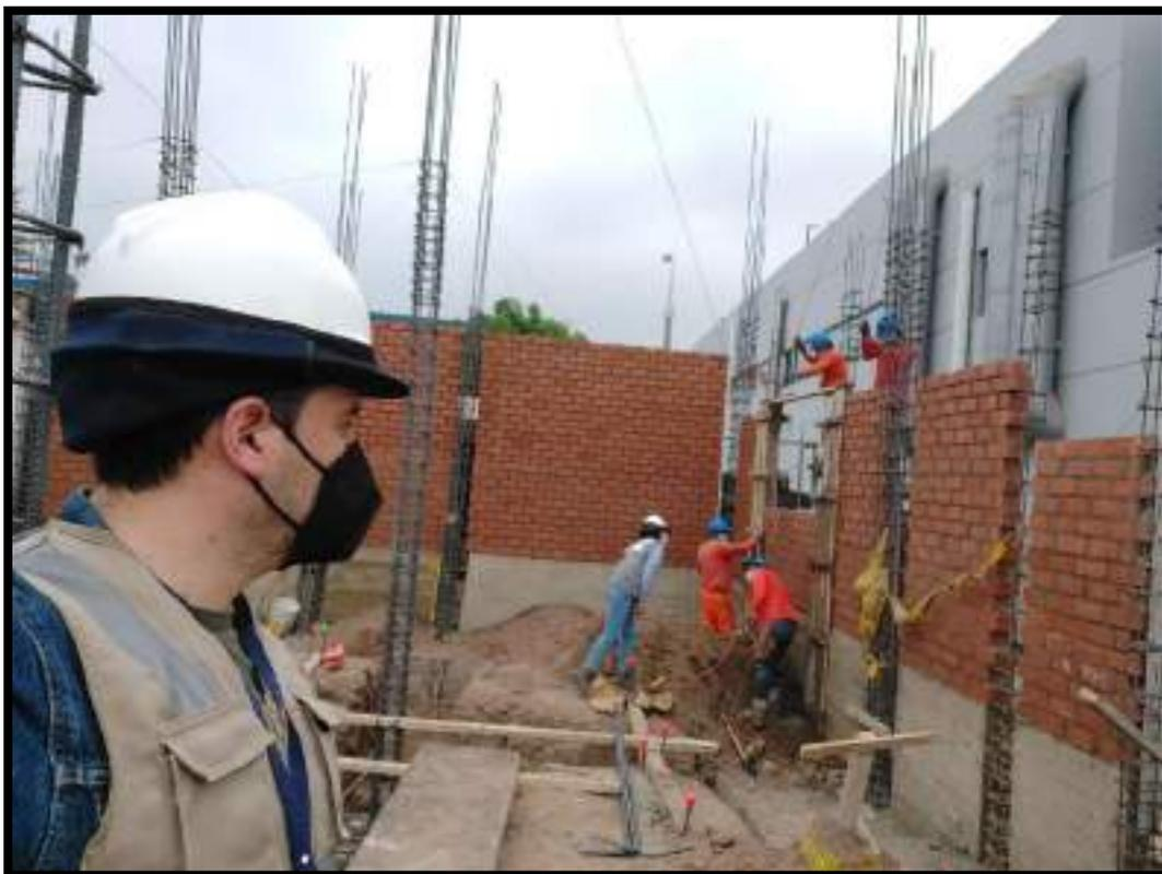
VERIFICACION DEL TRABAJO DE ASENTADO DE LADRILLO Y REFORZAMIENTO DE COLUMNETAS EN EL EJE D-D
