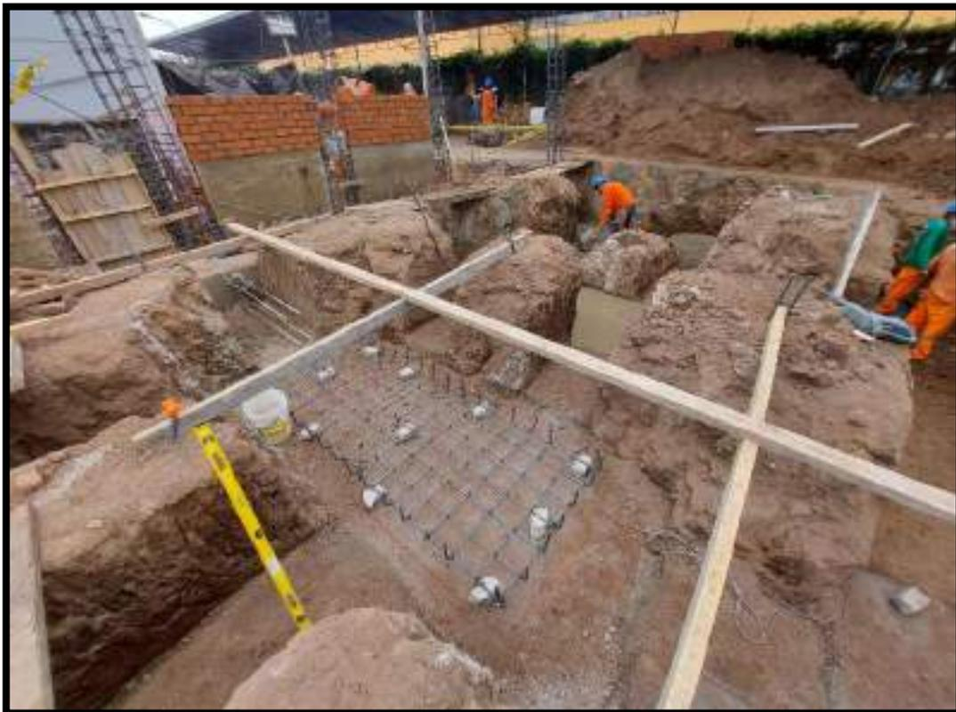
VERIFICACION DEL ANCLAJE Y NIVELACION DE ARMADURA DE ZAPATAS EN LOS EJES INTERIORES
