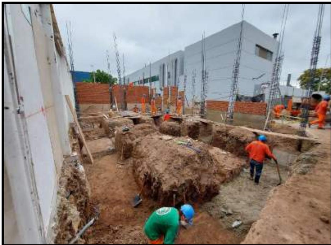
VERIFICACION DEL INICIO Y AVANCE DEL TRABAJO DE ASENTADO DE LADRILLO DE SOGA EN LOS EJES 5-5 Y D-D Y LLENADO DE CONCRETO  $f'c=100\text{KG}/\text{CM}^2$  EN FALSAS ZAPATAS
