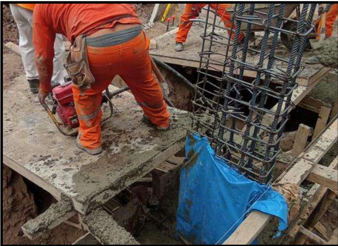
VERIFICACION DE LA UTILIZACION DEL VIBRADOR DE CONCRETO EN PROCESO DE COLOCACION DEL CONCRETO
