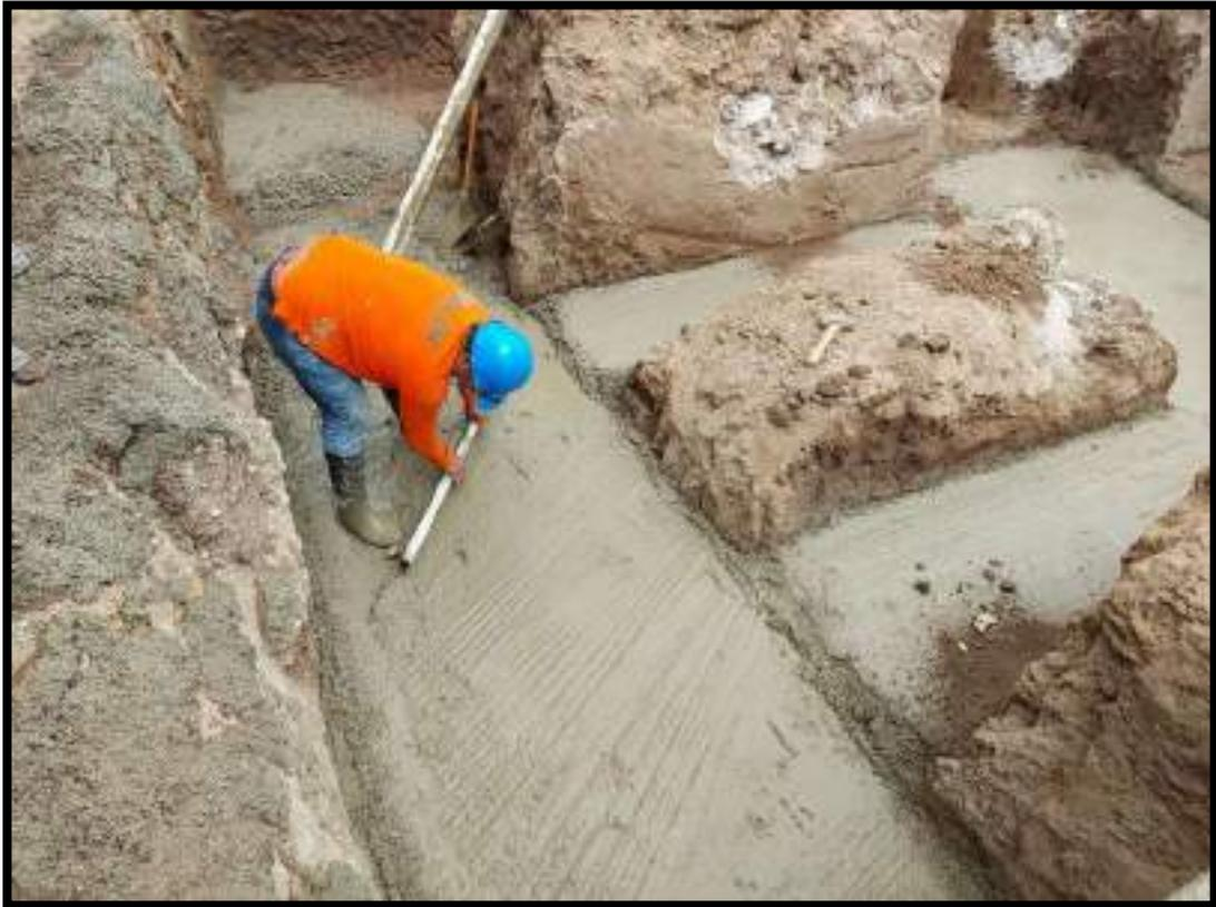
VERIFICACION DEL LLENADO DE CONCRETO F'C=100KG/CM2 EN FALSAS ZAPATAS
