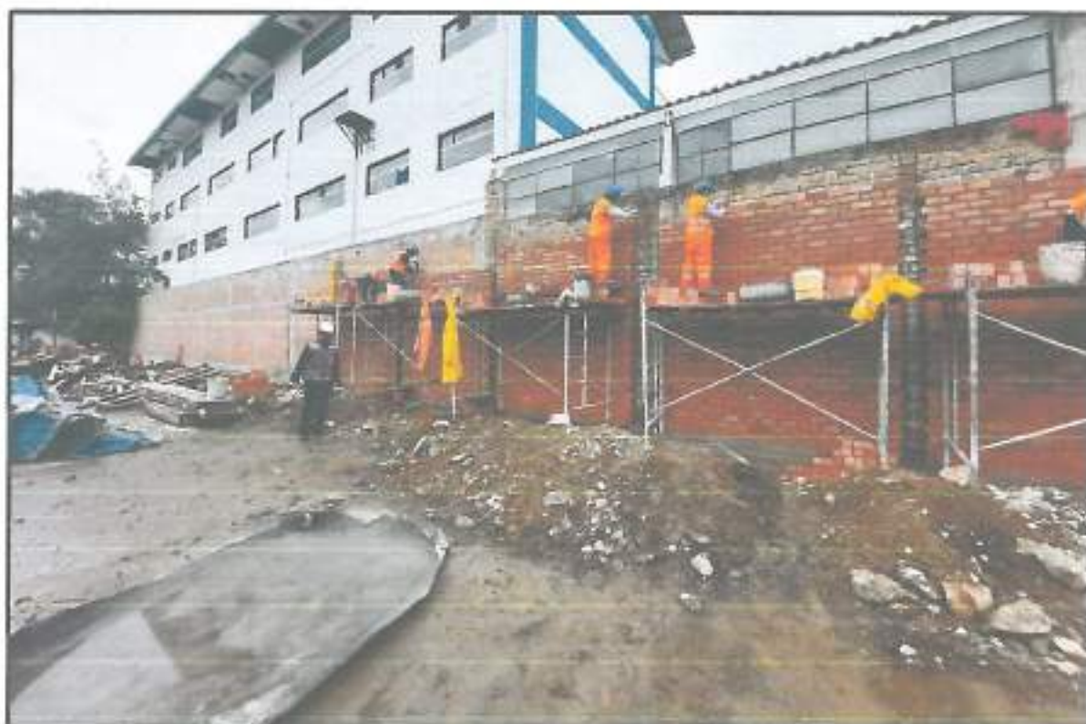
Fotografía N° 07: se verifican los trabajos de albañilería de asentado de ladrillo en el cerco perimétrico colindante con SENATI.
