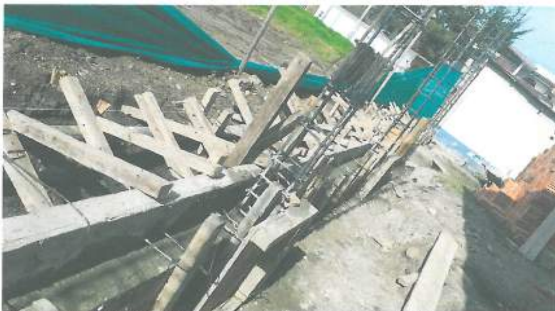
Foto N° 03: Vaciado de sobrecimiento f'c=175 \text{ kg/cm}^2 en muro perimetral.
