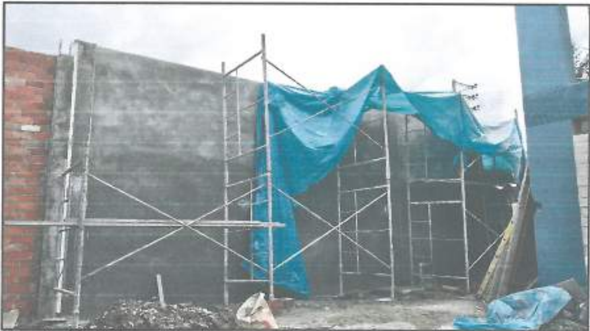
Fotografía N° 06: en la toma fotográfica se visualizan los trabajos de tarrajeo en el cerco perimétrico.
