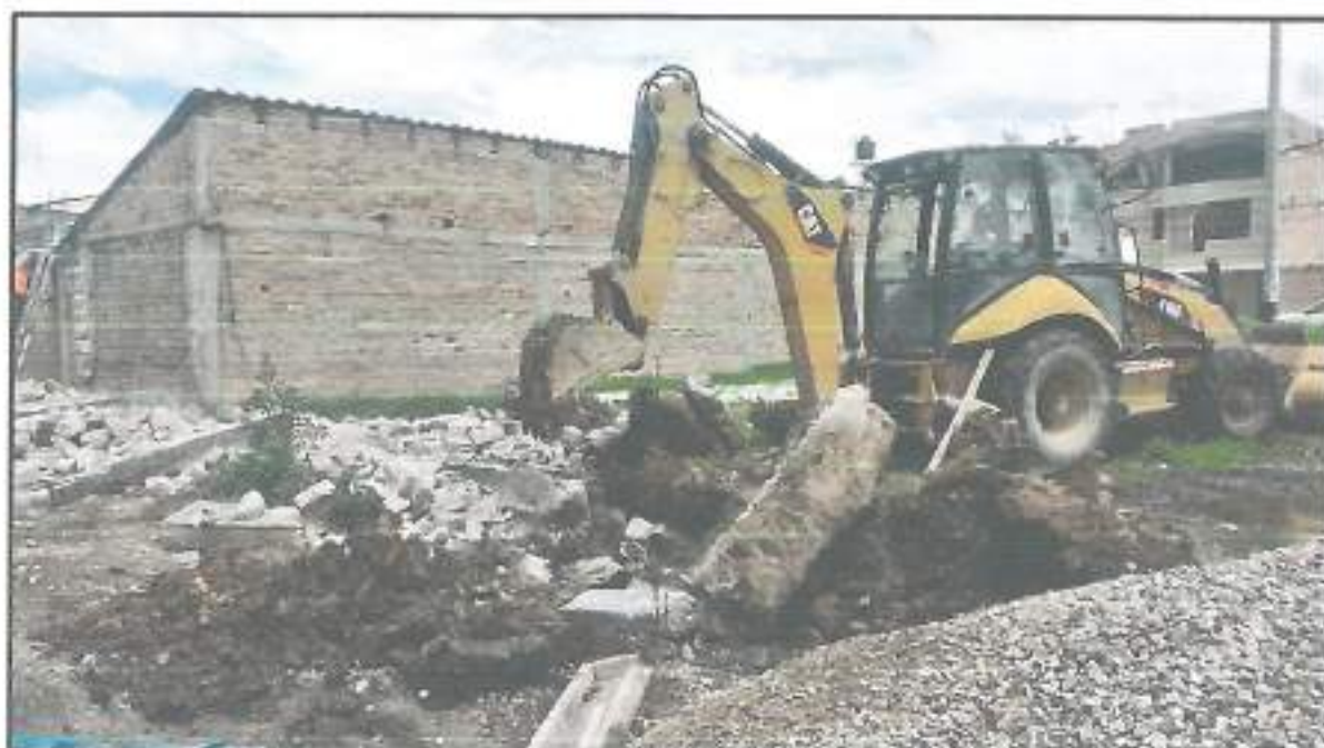
Fotografía N° 03: en la imagen se aprecian los trabajos de demolición de cimentaciones existentes, para la construcción de una cimentación nueva.
