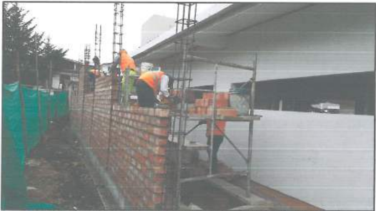
Fotografía N° 05: se verifican los trabajos del asentado de ladrillo en el cerco perimétrico.
