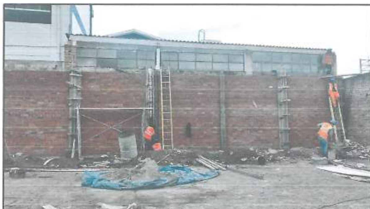
Fotografía N° 08: en esta imagen se visualizan los trabajos de encofrado y vaciado de columnas en el cerco perimétrico.
