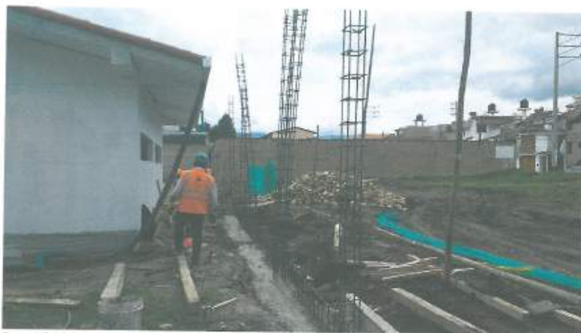
Foto N° 01: Vaciado de concreto 1:10 más 30% de piedra grande en cimiento corrido.
