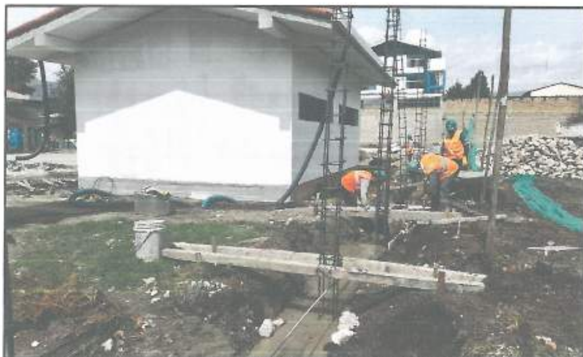
Fotografía N° 04: después de los trabajos de excavación se procede a realizar el izado de columnas y el vaciado de la cimentación.
