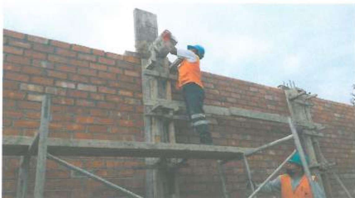
Foto N° 04: Vaciado de columnas f'c=210 \text{ kg/cm}^2 en muro perimetral.
