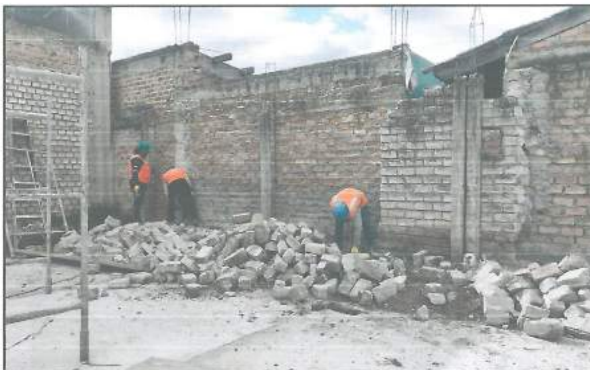
Fotografía N° 02: en esta imagen se aprecian los trabajos de demolición manual del cerco existente, para su construcción.
