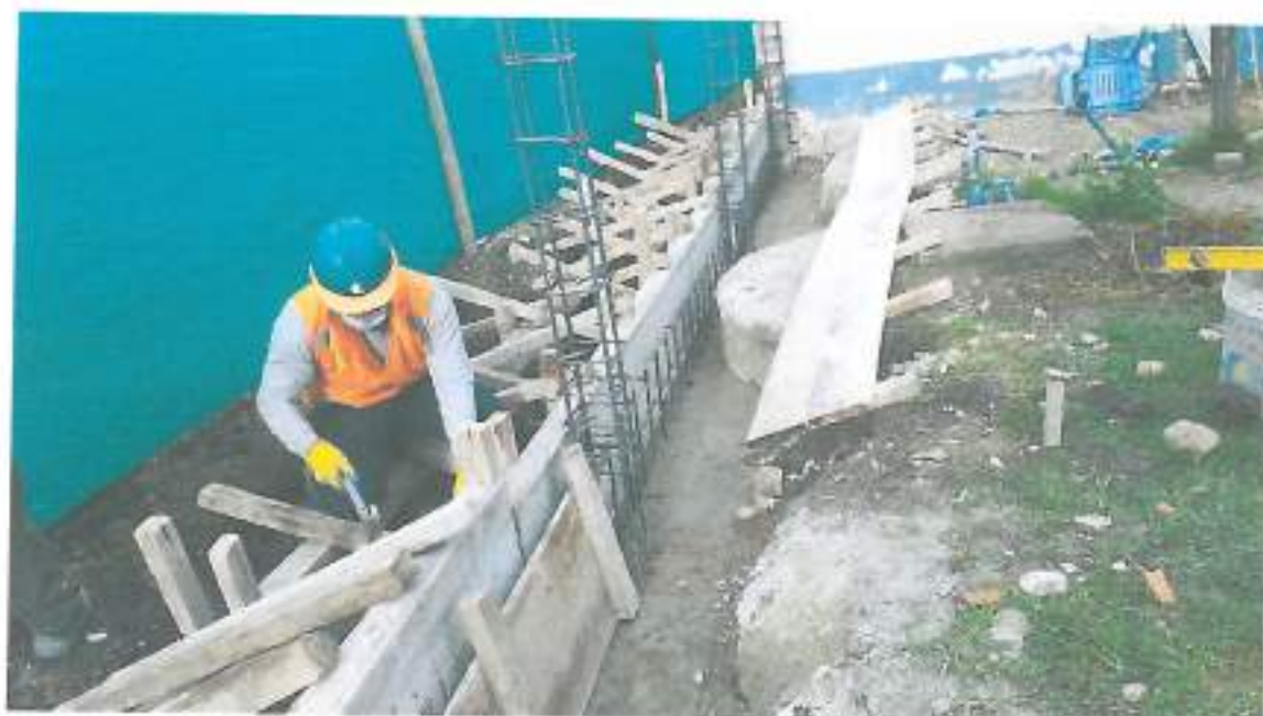
Foto N° 02: Encofrado de sobrecimiento para muro perimetral.
