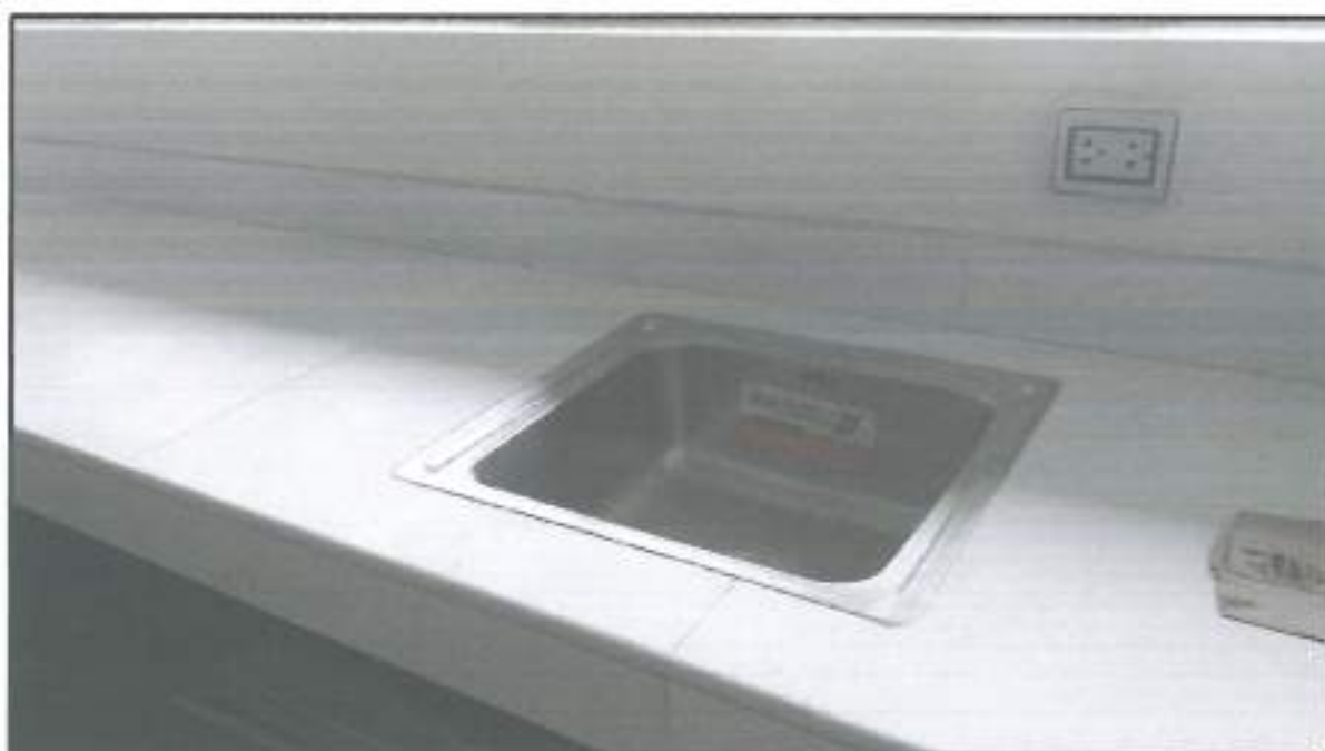
Fotografía N° 08: se observan los trabajos de enchapado con porcelanato y los lavatorios de acero inoxidable.
