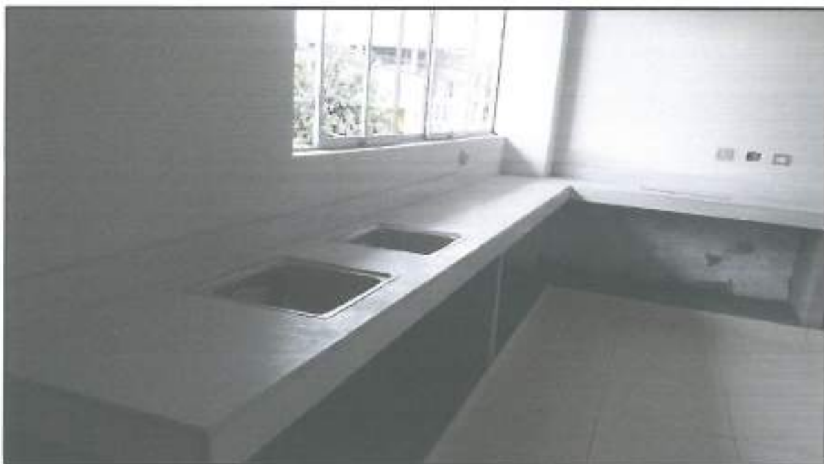
Fotografía N° 07: en esta fotografía se observa los trabajos de enchapado de mesas de concreto con porcelanato en el módulo de oficina segundo nivel.
