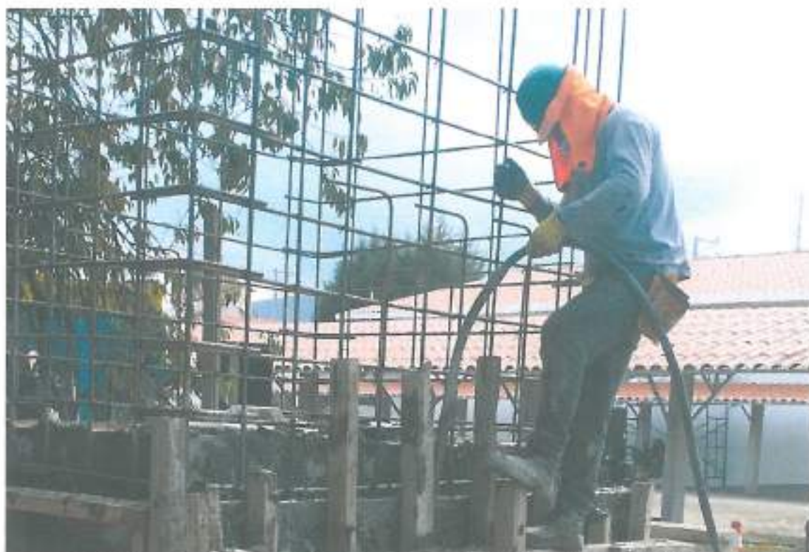
Foto N° 06: Vibrado de concreto f'c=210 en cámara de bombeo de aguas pluviales.
