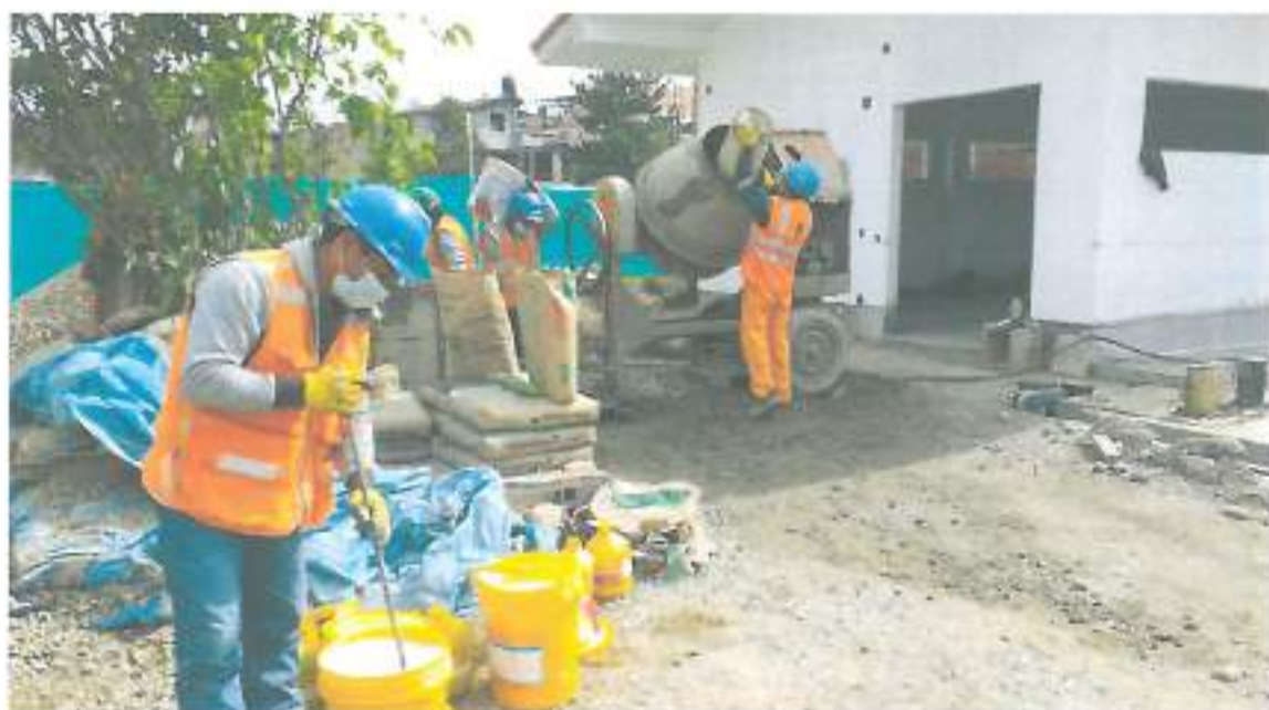
Foto N° 05: Preparación de concreto f'c=210 con aditivo acelerante e impermeabilizante para cámara de bombeo de aguas pluviales.
