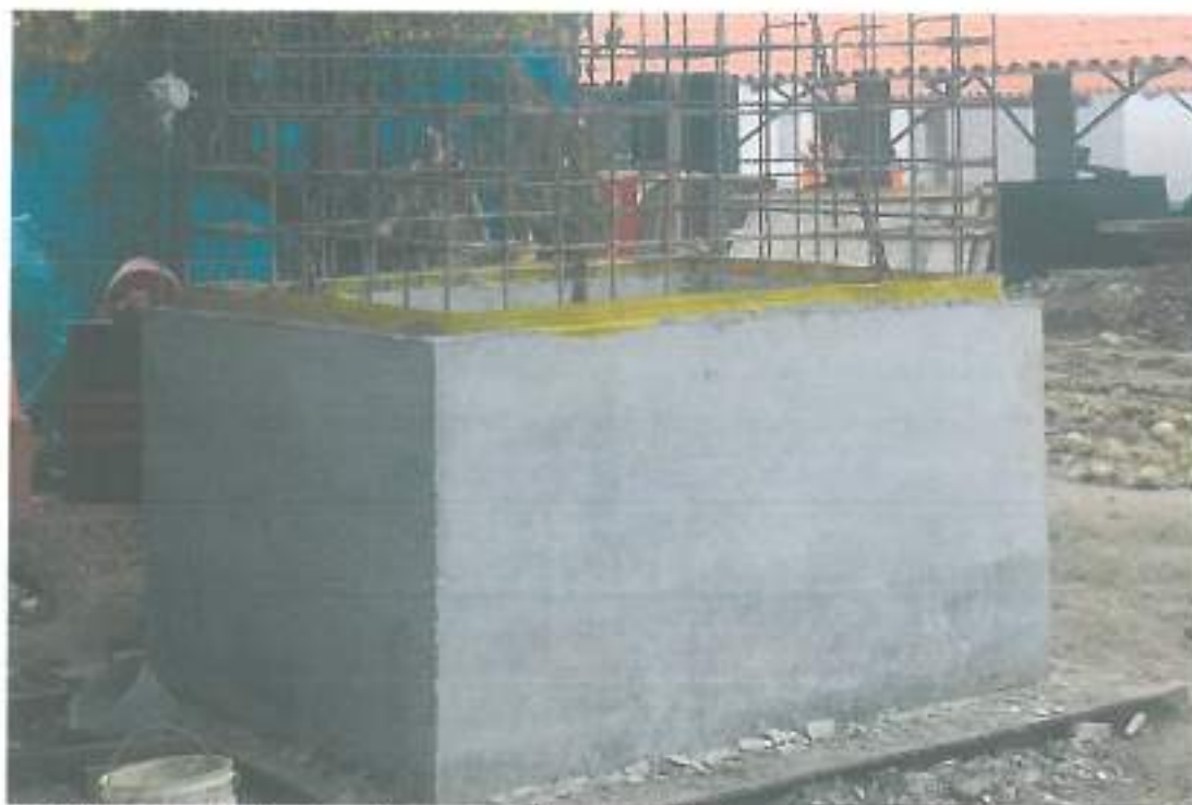
Foto N° 07: Instalación de wáter stop en cámara de bombeo de aguas pluviales.
