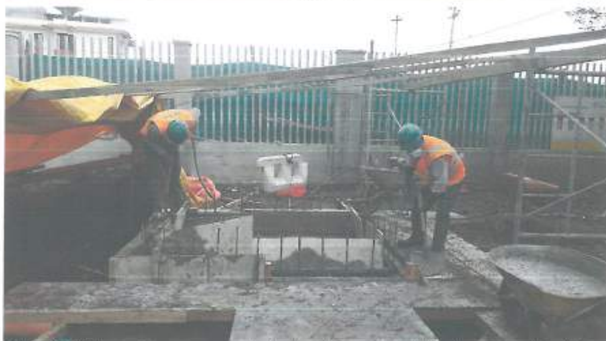
Fotografía N° 05: en esta imagen se aprecia el vaciado de concreto y el vibrado correspondiente de la cámara de bombeo.
