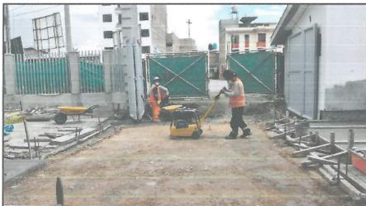
Fotografía N° 02: en la toma fotográfica se verifican los trabajos de compactado de patio de ingreso peatonal y para luego realizar el encofrado de la canaleta en el ingreso
