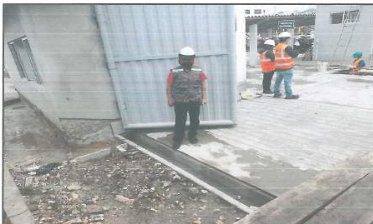
Fotografía N° 03: en esta imagen se aprecia al Gerente de Obra, verificando la canaleta del ingreso peatonal.
