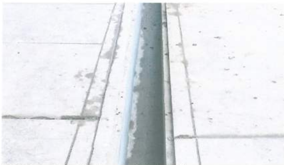
Foto N° 04: Canaleta f'c= 175 en ingreso a módulo de auditorio.
