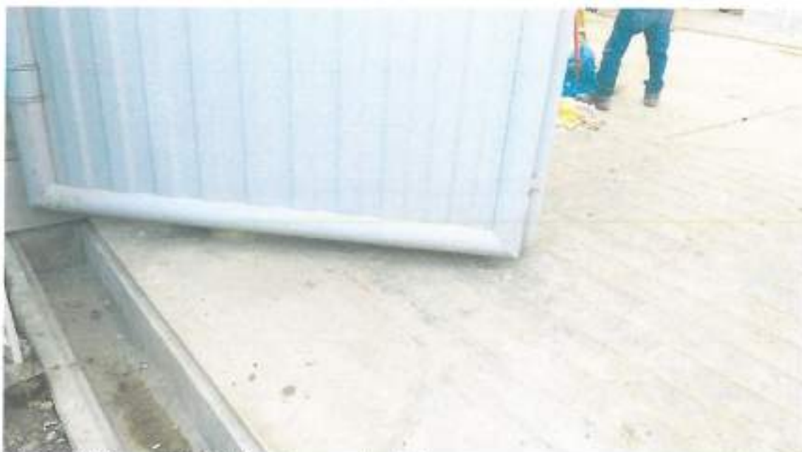
Foto N° 03: Canaleta f'c= 175 en ingreso principal.
