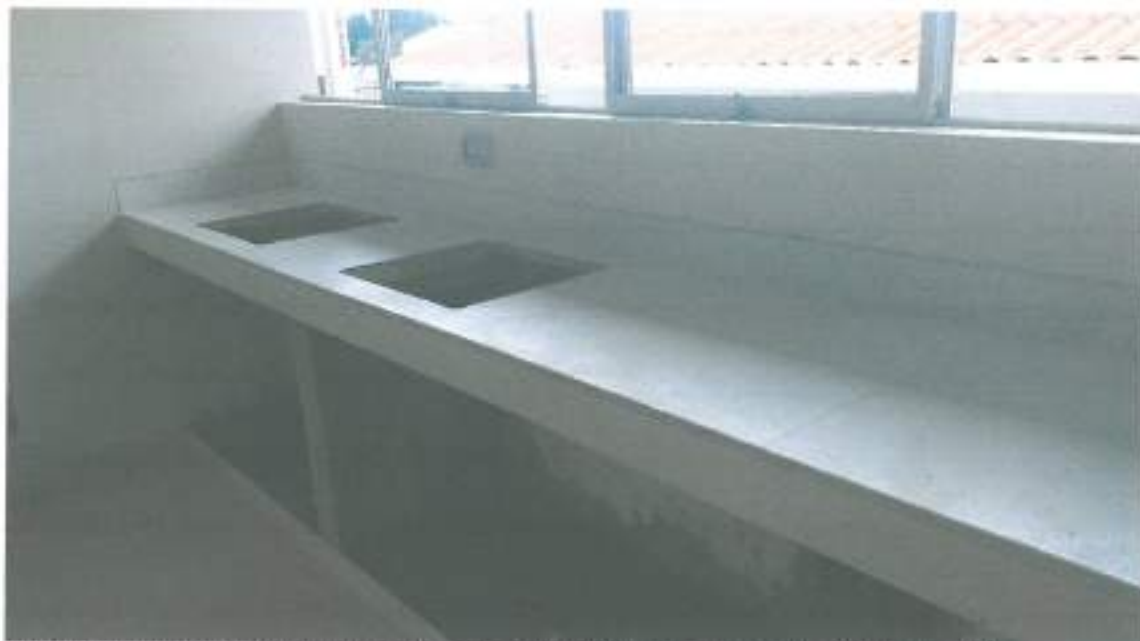
Foto N° 01: Instalación de porcelanato de .60 x .60 cm en mesas de módulo de oficinas segundo nivel.
