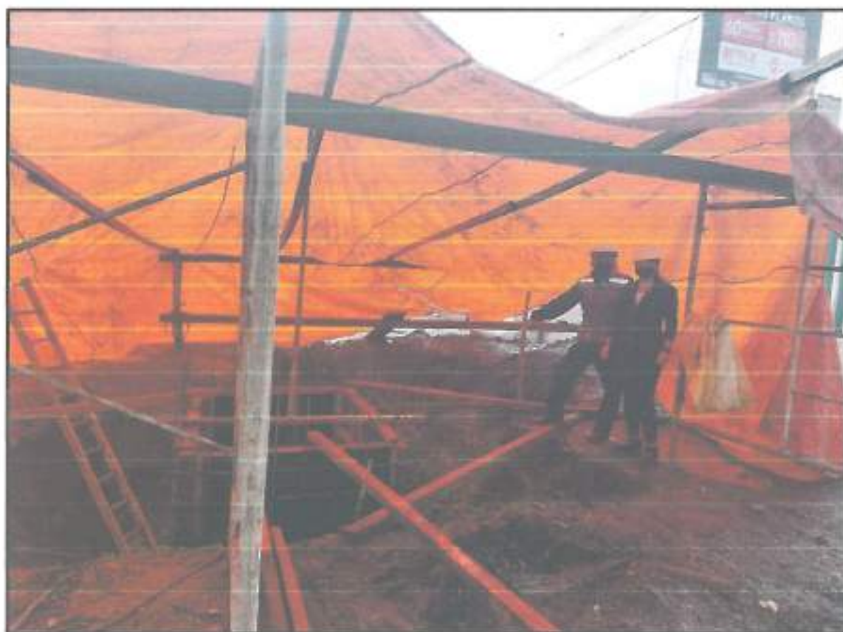
Fotografía N° 04: se verifican los trabajos de encofrados de la cámara de bombeo.
