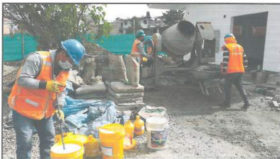
Fotografía N° 06: se verifica la preparación del impermeabilizantes para evitar filtraciones del agua en la cámara de bombeo.
