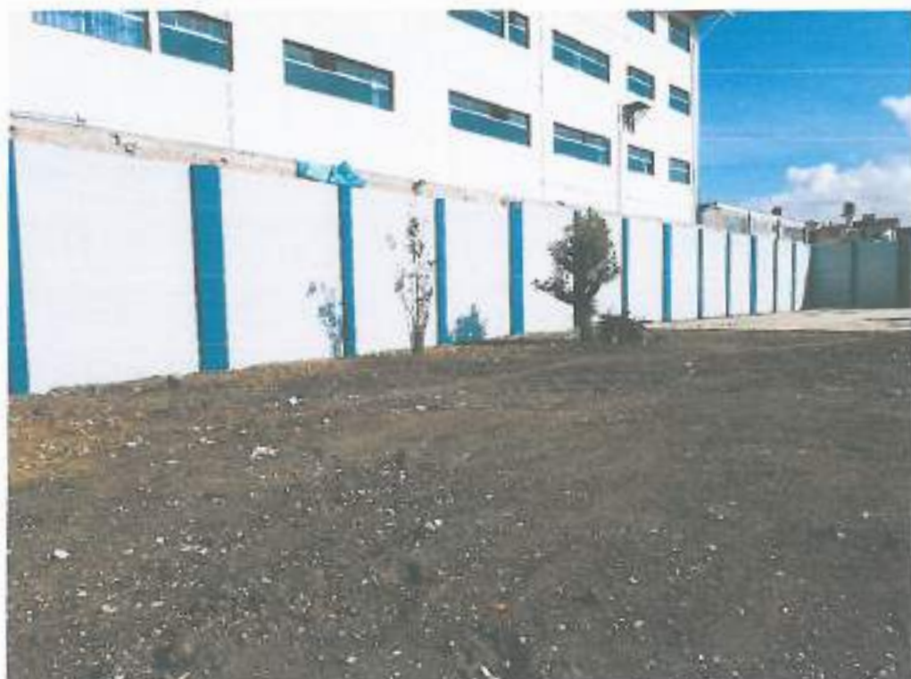
FOTO N° 04: Pintado de muro perimétrico, segunda mano.
