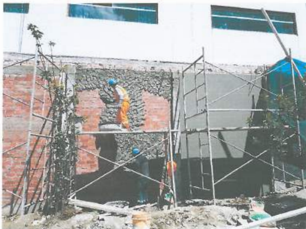
FOTO N° 02: Muro perimétrico, vista interior en proceso de tarrajeo.
