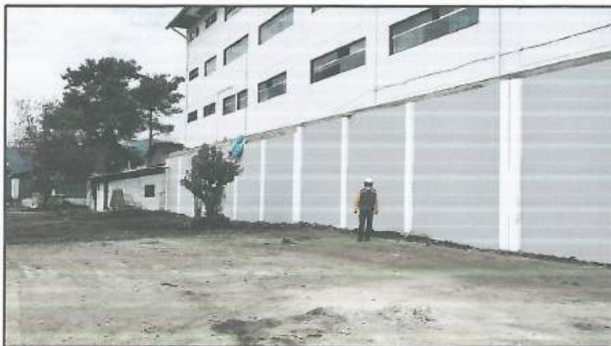
Fotografía N° 03: se visualiza al gerente de obra verificando los trabajos de pintura.
