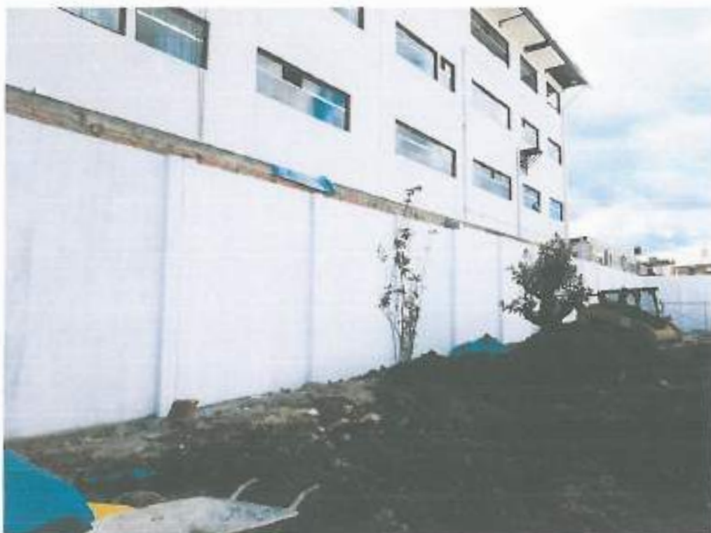
FOTO N° 03: Imprimación de muro perimétrico, segunda mano.
