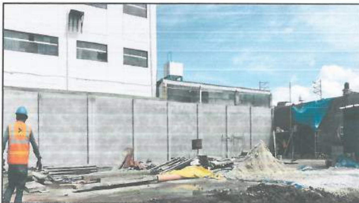
Fotografía N° 02: se observan los trabajos de terraje en el cerco perimétrico.
