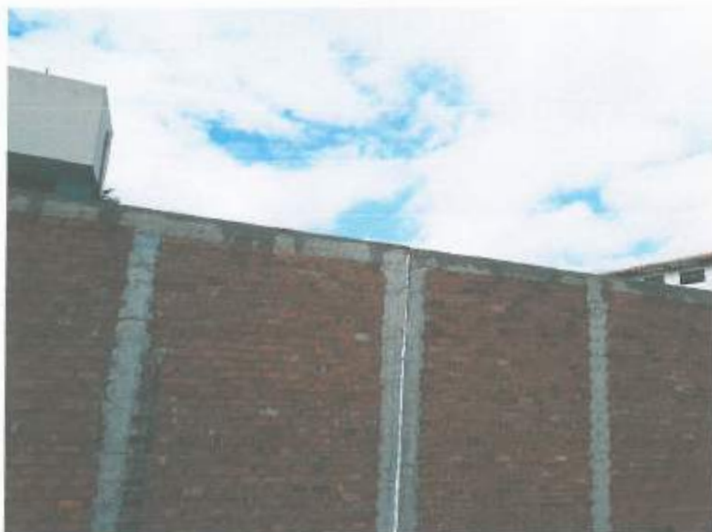
FOTO N° 01: Muro perimétrico terminado, vista posterior.
