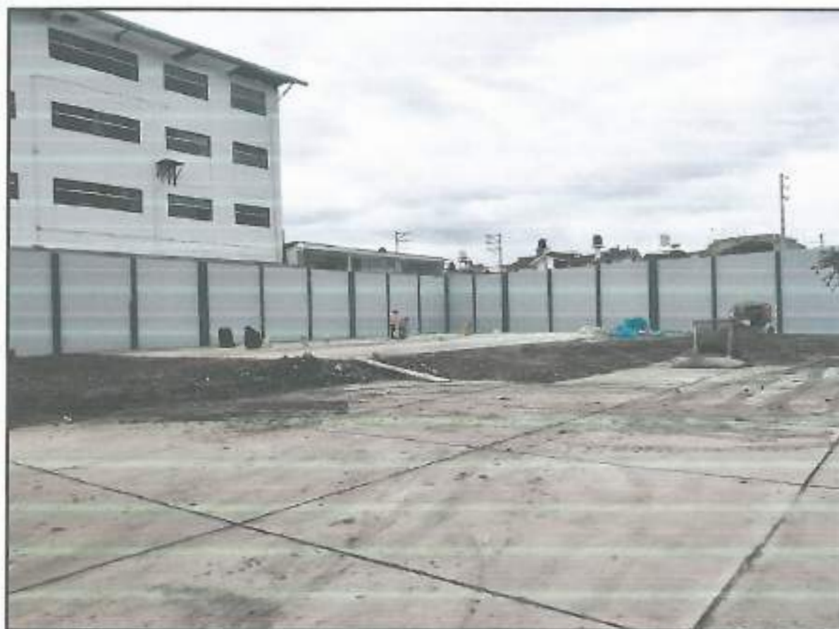
Fotografía N° 04: en la toma fotográfica se observa los acabados en el cerco, como el pintado.
