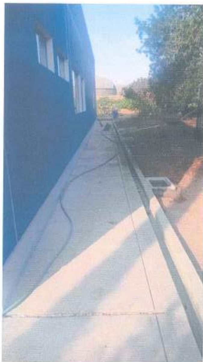
TOMA FOTOGRAFICA N°05: INSTALACION DE CAMARAS DE INSPECCION.
