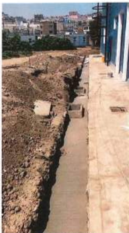
Fotografía N° 05 SOLADO C:H 1:10 E=0.10M
