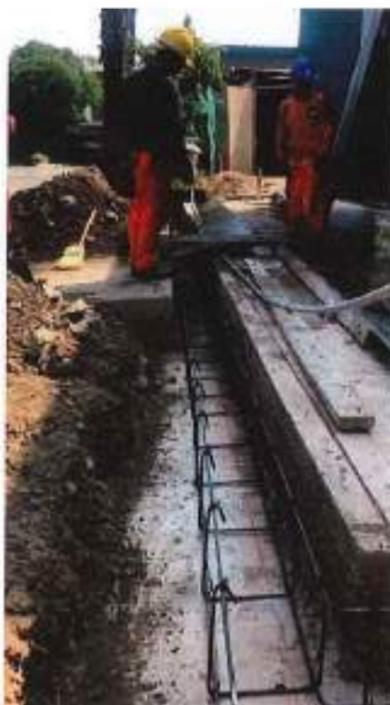
Fotografía N° 07 CANALETA ANTI HORMIGAS - ACERO FY = 4200 \text{ kg/cm}^2
