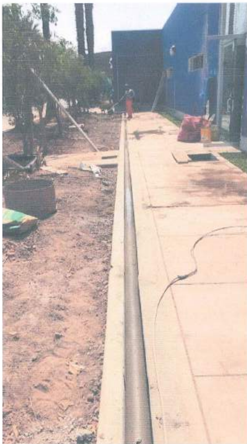
TOMA FOTOGRAFICA N°03: CANALETA ANTI HORMIGAS f'c = 210 \text{ kg/cm}^2
