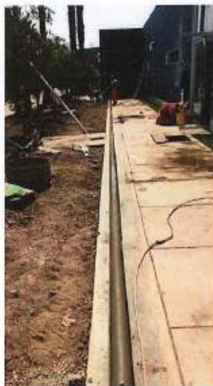
Fotografía N° 06 CANALETA ANTI HORMIGAS f_c = 210 \text{ kg/cm}^2
