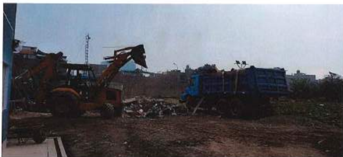
Fotografía N° 04 ELIMINACION DE MATERIAL EXCEDENTE CON MAQUINARIA A UNA DISTANCIA PROMEDIO 30KM
