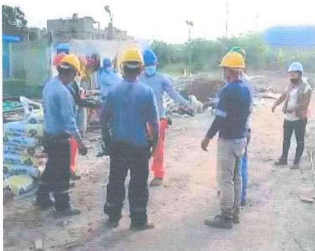
TOMA FOTOGRAFICA N°01: CHARLAS DE SEGURIDAD EN OBRA.
