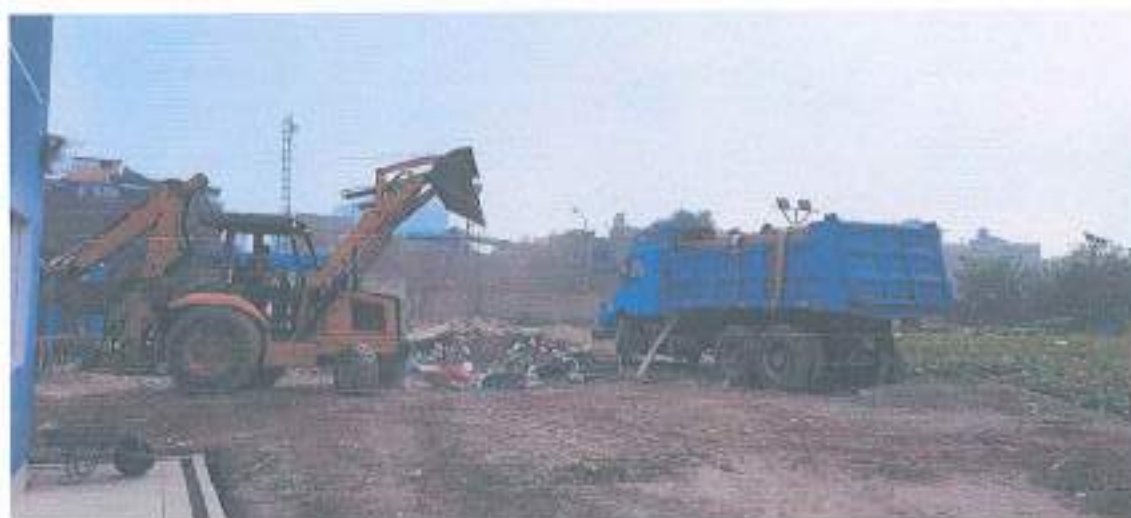
TOMA FOTOGRAFICA N°02: ELIMINACION DE MATERIAL EXCEDENTE.
