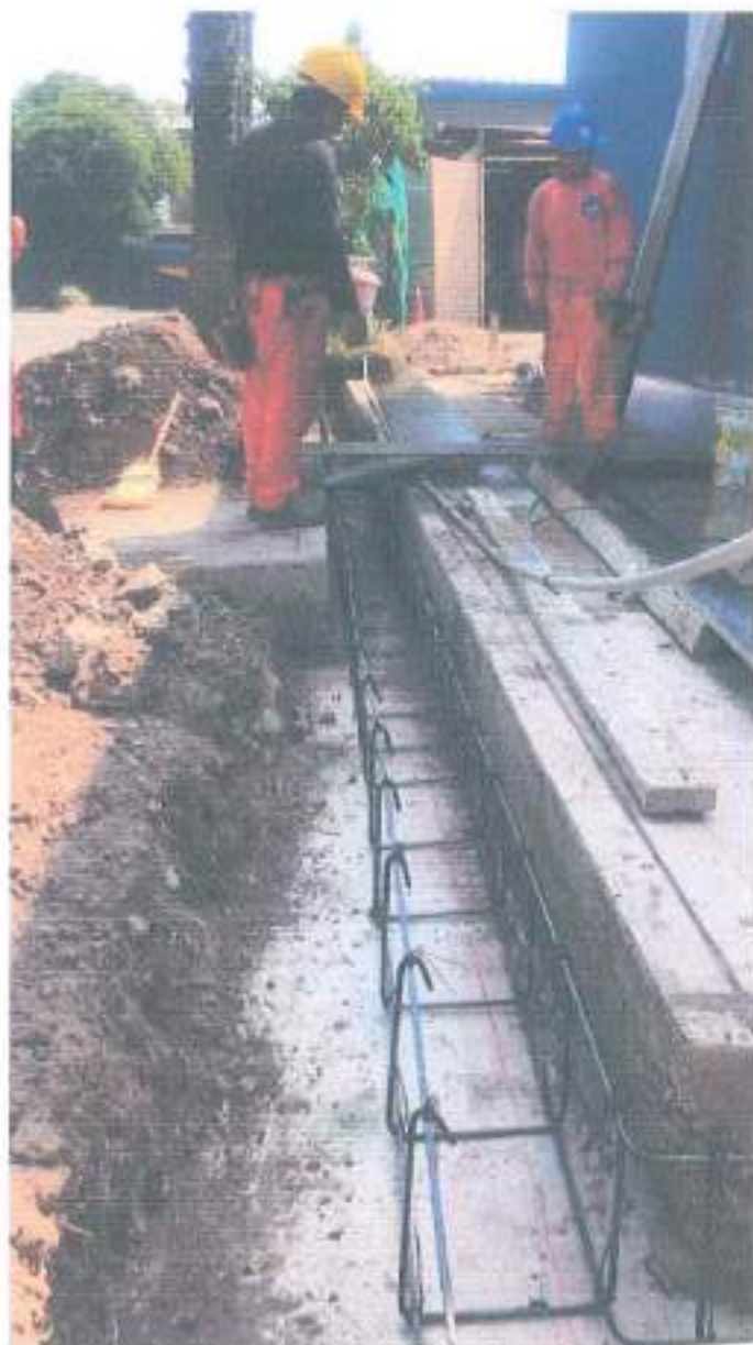
TOMA FOTOGRAFICA N°04: CANALETA ANTI HORMIGAS ACERO FY= 4200 kg/cm 2
