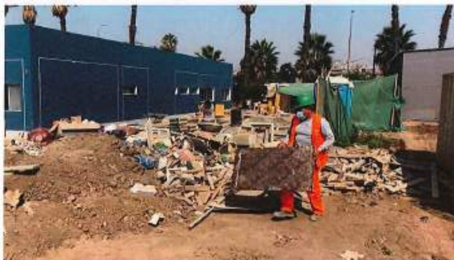
Fotografía N° 02 LIMPIEZA DEL TERRENO MANUAL
