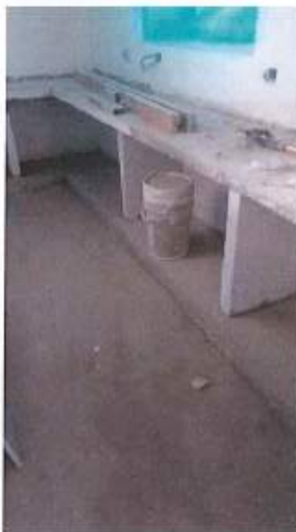
Fotografía N° 08 BASE DE MESAS DE CONCRETO - CONCRETO PC = 210 \text{ kg/cm}^2
