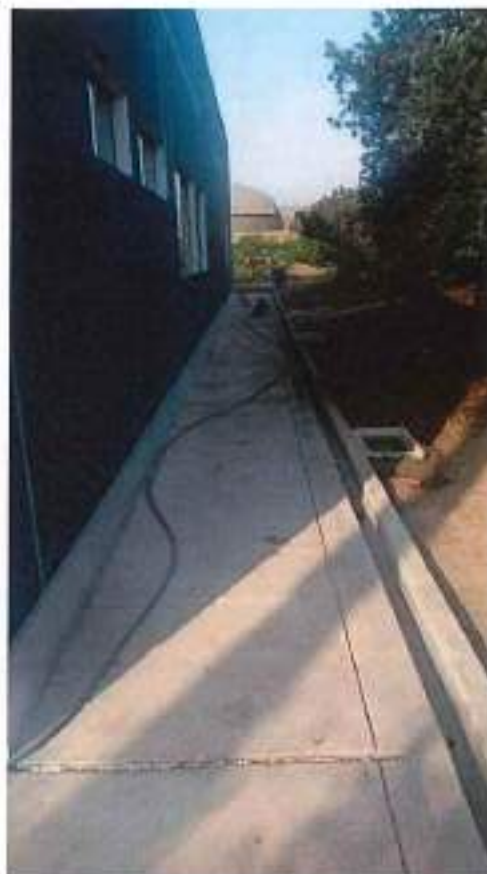
Fotografía N° 09 CAMARAS DE INSPECCION
