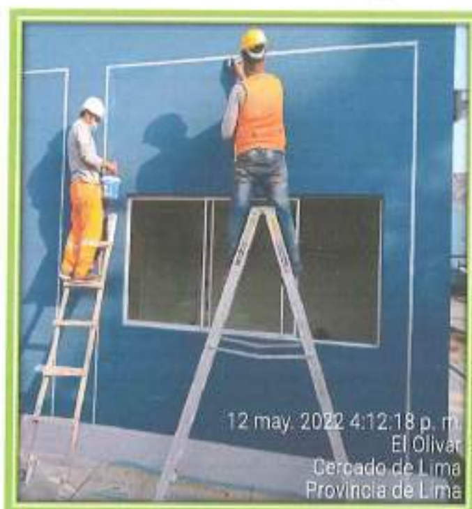
Foto N° 5. USO DE EPPS ADECUADOS.
