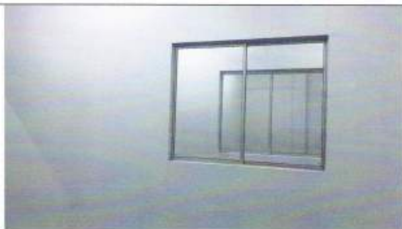
Fotografía N° 05 PINTURA EPOXICA EN MUROS INTERIORES DOS MANOS
