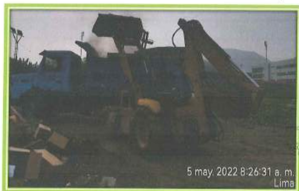
Foto N° 6. ELIMINACION DE MATERIAL PARTICULADO Y EXCEDENTE CON MAQUINARIAS
