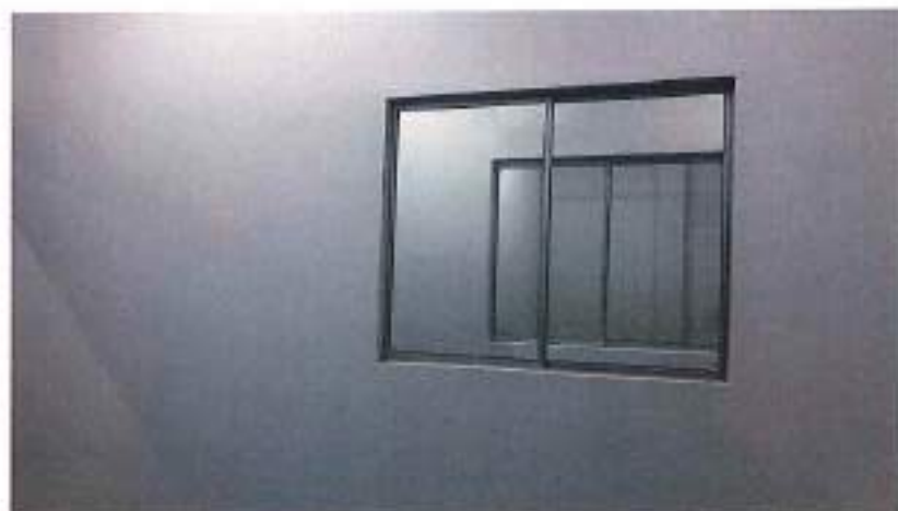
Fotografía N° 05 PINTURA EPOXICA EN MUROS INTERIORES DOS MANOS
