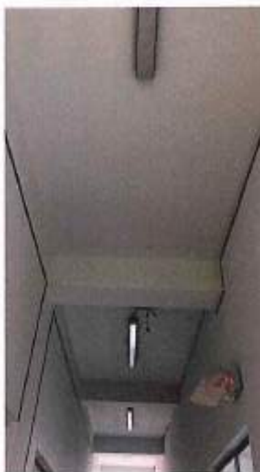
Fotografía N° 02 PINTURA OLEO EN CIELORASO Y VIGAS
