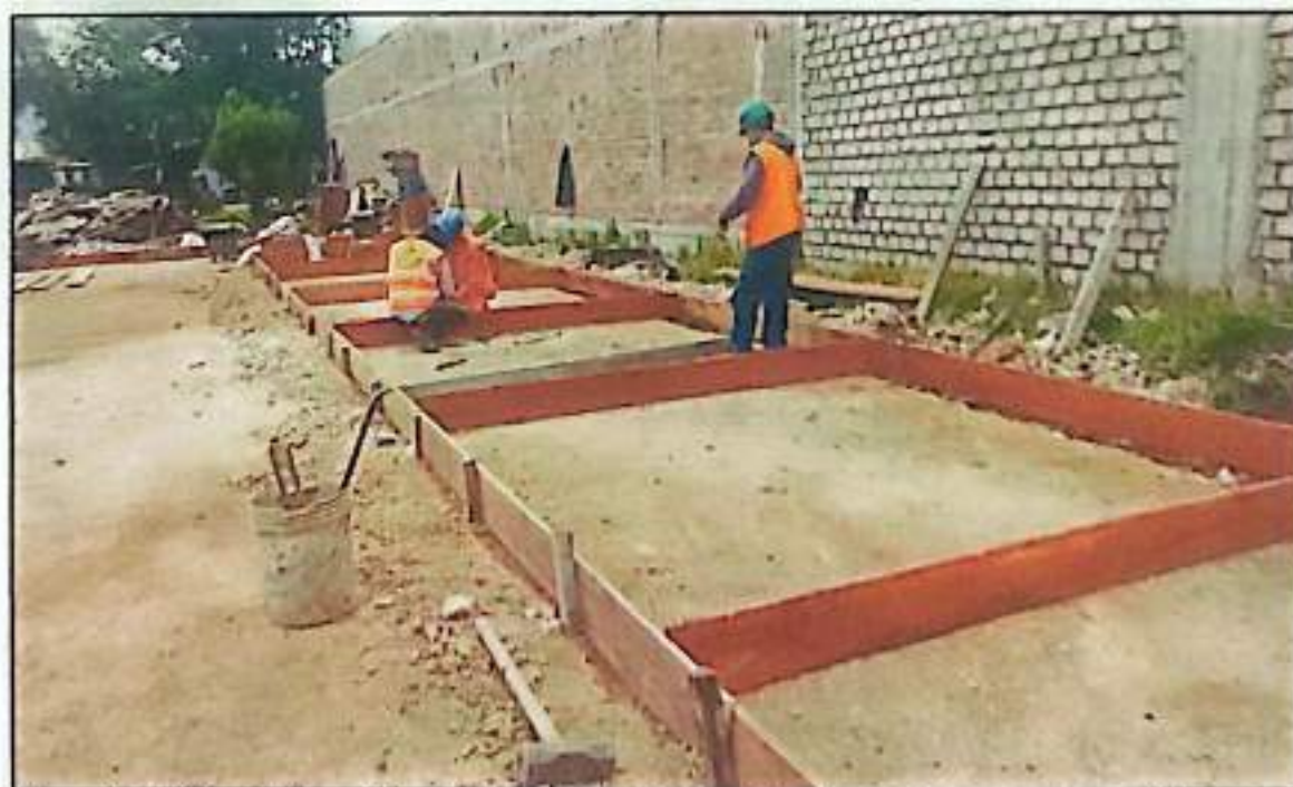
Fotografía N° 08: en la toma fotográfica se observan los trabajos de encofrado por paños en la losa deportiva.
