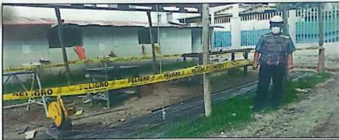
Fotografía N° 02: se aprecia al Gerente de Obra, supervisando las señalizaciones en obra.
