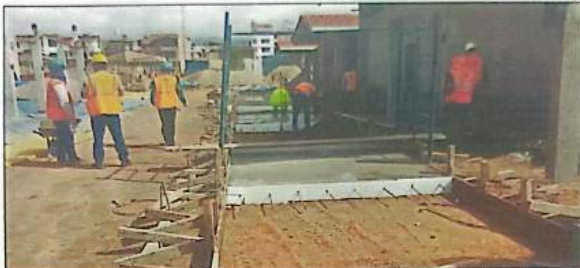
Fotografía N° 15: se observa el encofrado y el vaciado de concreto f'c = 175 \text{ kg/cm}^2 en la losa estacionamiento.
