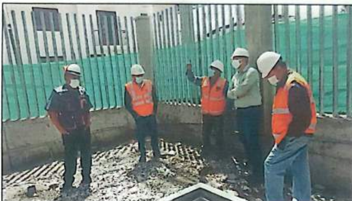
Fotografía N° 21: se observa al coordinador de Prodesa ing. Ever Becerra coronado, verificando el avance de la obra y realizando algunas coordinaciones.
