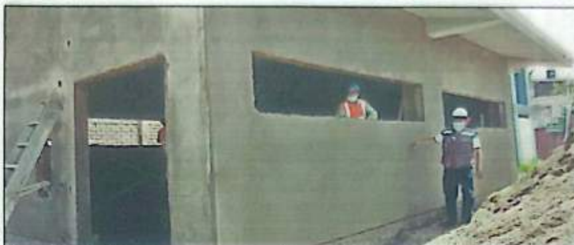
Fotografía N° 18: el Gerente verifica el terraje en derrames del módulo almacén de residuos tóxicos.
