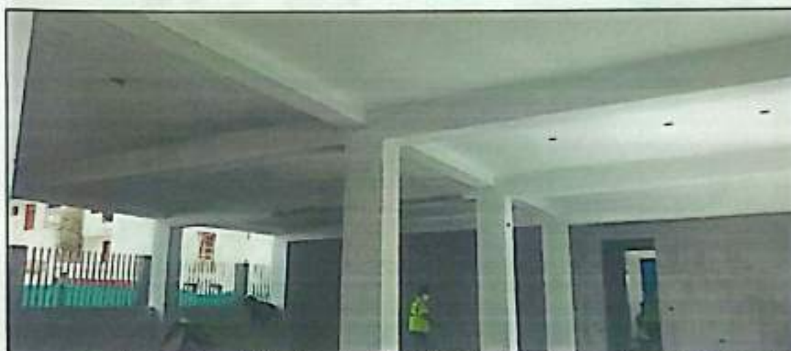
Fotografía N° 19: se verifica el lijado y la colocación del imprimante en muros y columnas interiores del módulo de oficina.
