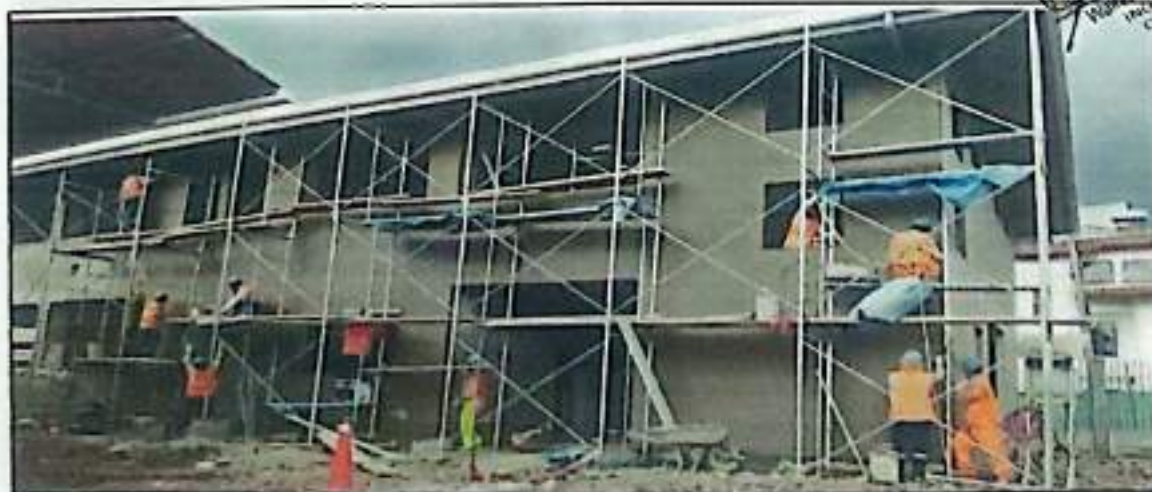
Fotografía N° 03: se observa los trabajos de terraje en los muros, columnas, vigas en el módulo de oficina.
