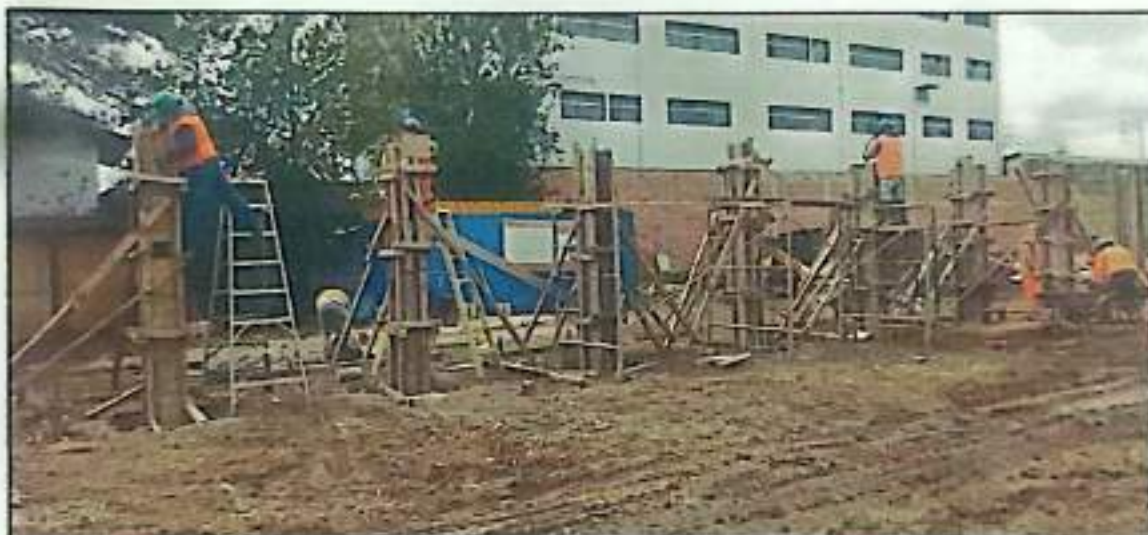
Fotografía N° 13: en esta imagen observamos el encofrado y el vaciado concreto f_c: 210 \text{ kg/cm}^2 en las columnas para el estacionamiento.
