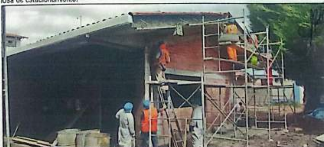
Fotografía N° 17: se observan los trabajos del terraje en el módulo de cocina / comedor.
