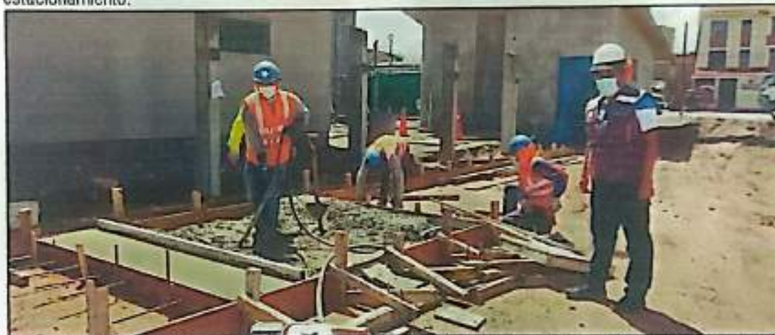
Fotografía N° 16: en la imagen se verifica al Gerente de obra supervisando el vibrado del vaciado en la losa de estacionamiento.
