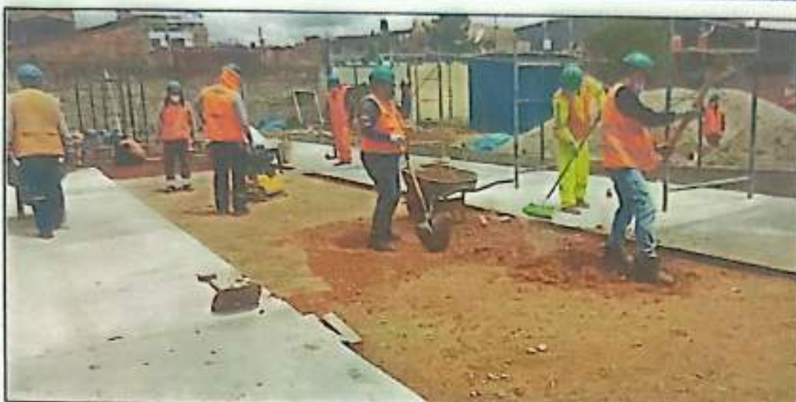
Fotografía N° 09: en la imagen apreciamos la compactación por paños para el vaciado de concreto en la losa deportiva.
