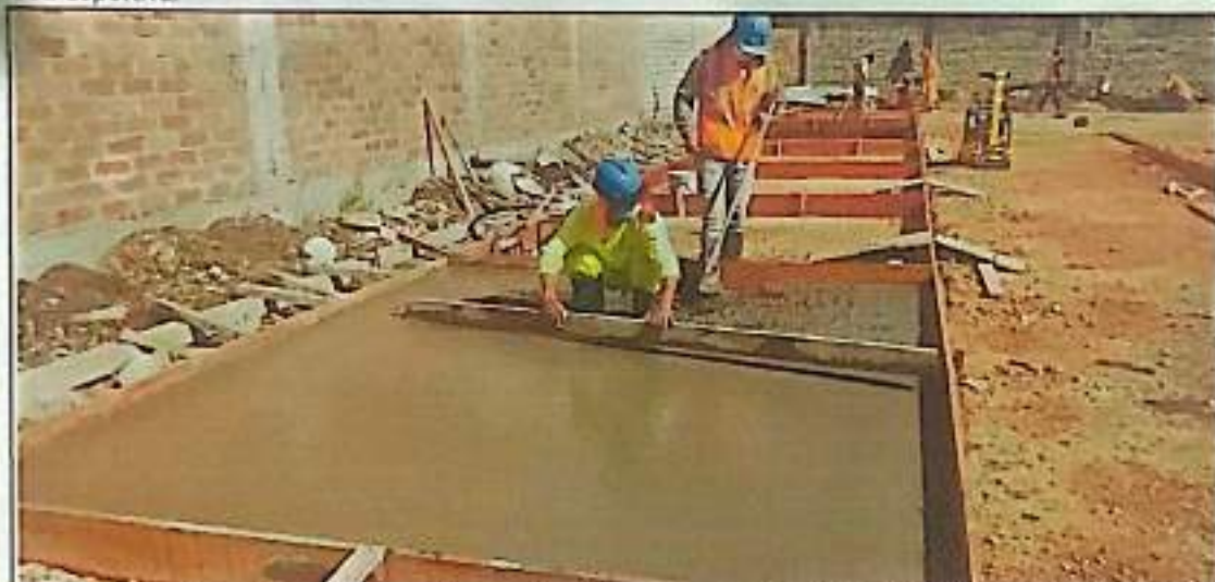
Fotografía N° 10: en la imagen apreciamos el vaciado concreto f'c=175 \text{ kg/cm}^2 de la losa deportiva
