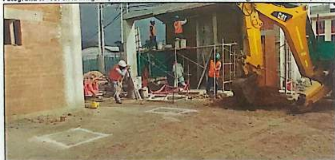
Fotografía N° 11: se verifica el trazo y replanteo para la excavación de las columnas del estacionamiento
