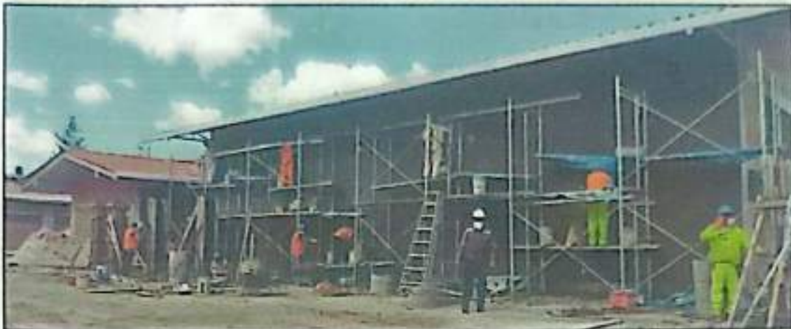
Fotografía N° 04: se observa al Gerente de obra supervisando los trabajos de terraje de muros, columnas, vigas exteriores en el modulo auditorio.
