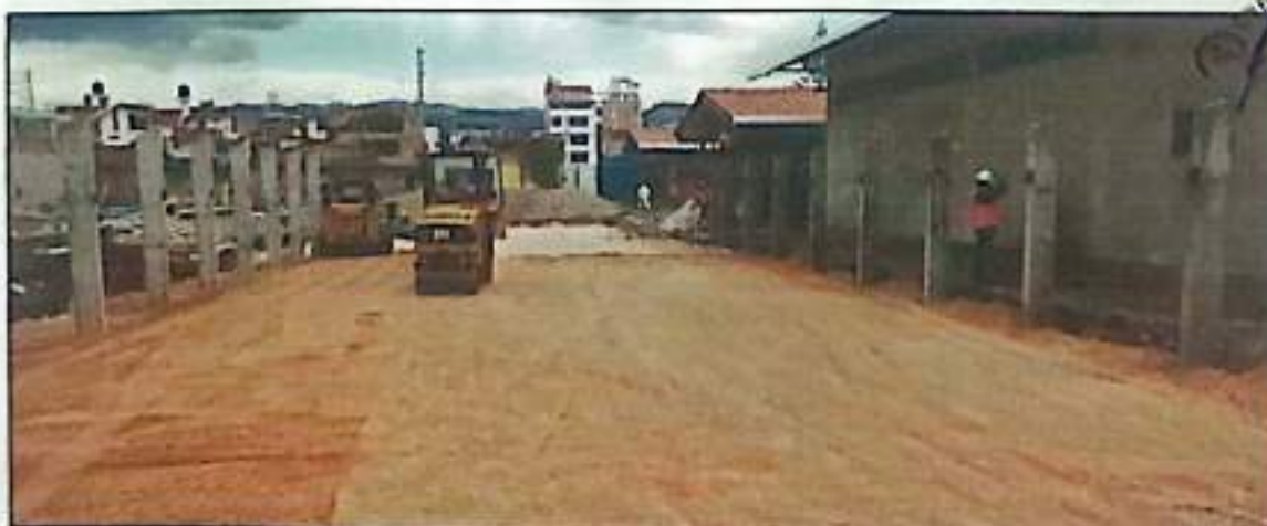
Fotografía N° 14: en esta imagen apreciamos la compactación de la losa para el estacionamiento.
