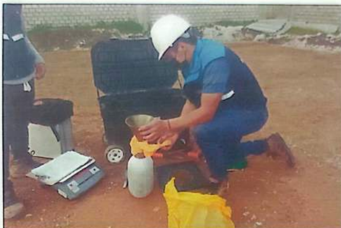
Fotografía N° 07: se observa a los especialistas realizando la densidad de campo para realizar el encofrado y luego proceder con el vaciado de la losa deportiva.
