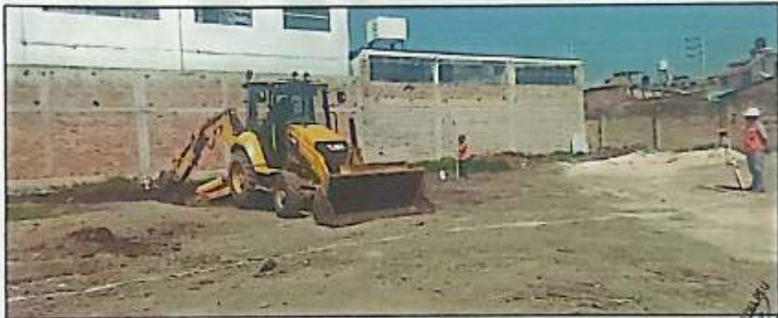
Fotografía N° 05: se verifica el trazo y replanteo de la losa deportiva, próximos para la excavación.
