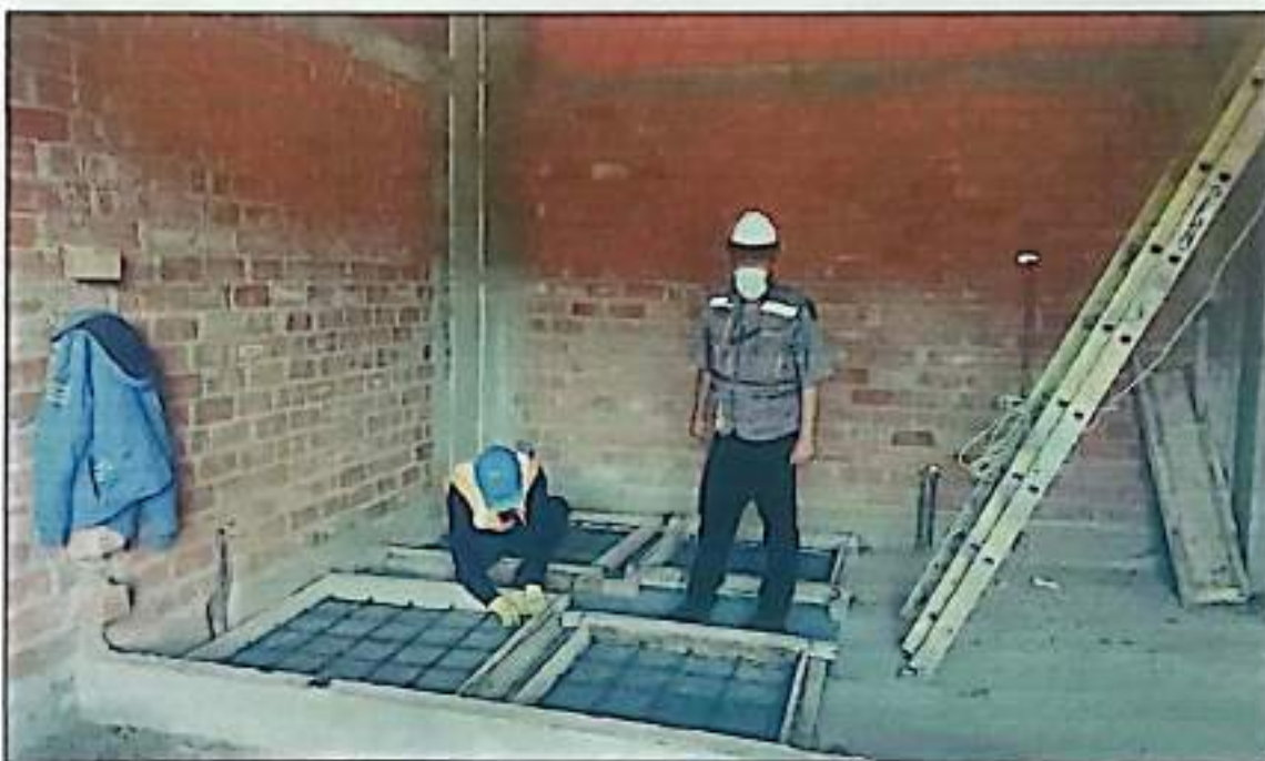
Fotografía N° 22: en la imagen se aprecia al Gerente de Obra verificando la construcción de las tapas de los busones.
