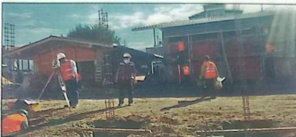
Fotografía N° 12: en la imagen se observa el izado de las columnas para el vaciado de las zapatas.
