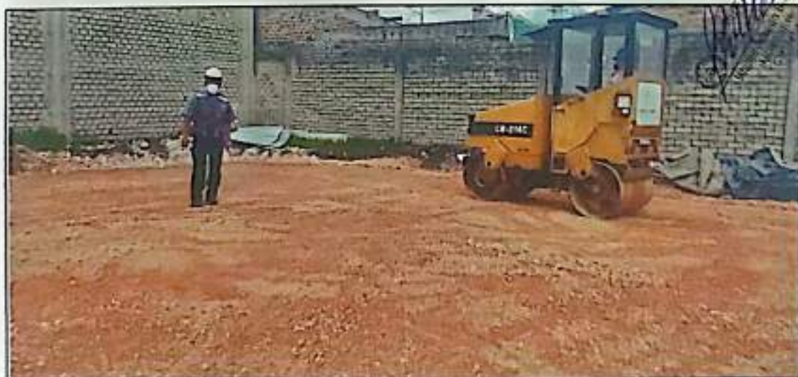
Fotografía N° 06: se observa al Gerente de obra chequeando la compactación capa de 15 cm de espesor de la losa deportiva.
