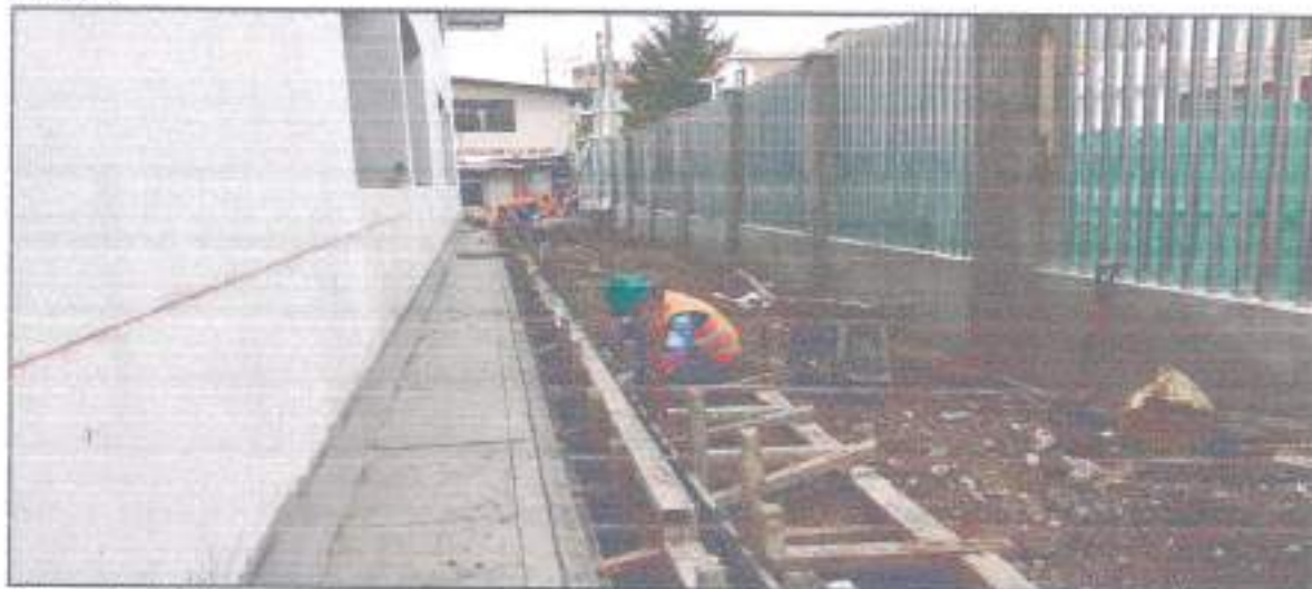
Fotografía N° 07: en esta imagen se aprecia al personal de obra realizando el vaciado de las canaletas para agua pluviales.
