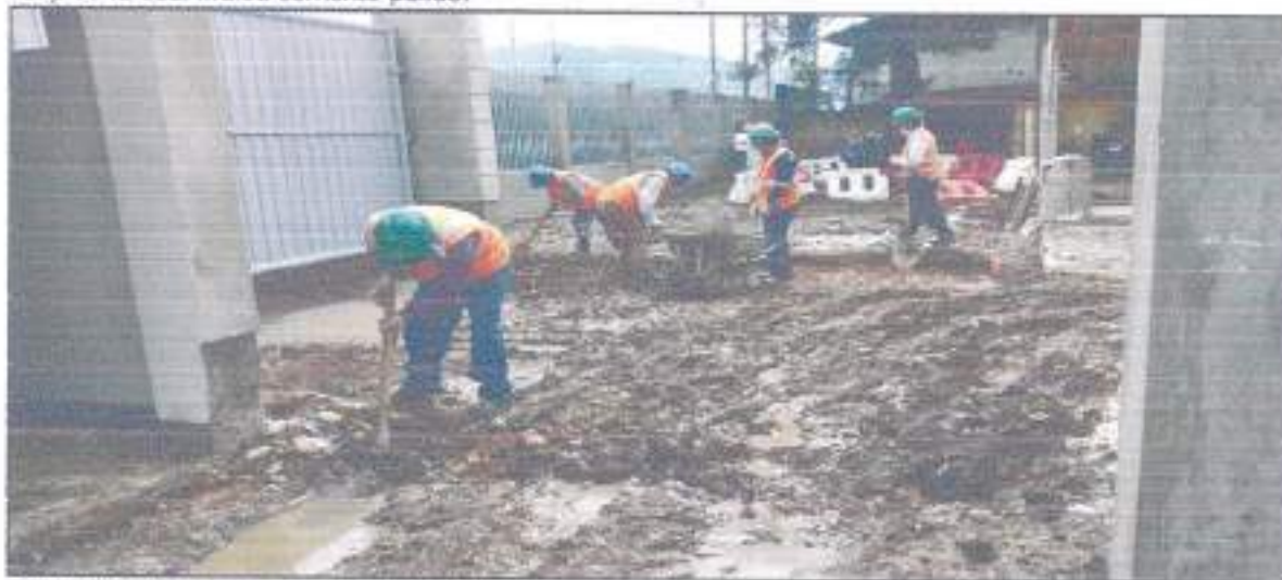
Fotografía N° 11: se aprecian los trabajos de excavación de la rampa del ingreso vehicular.
