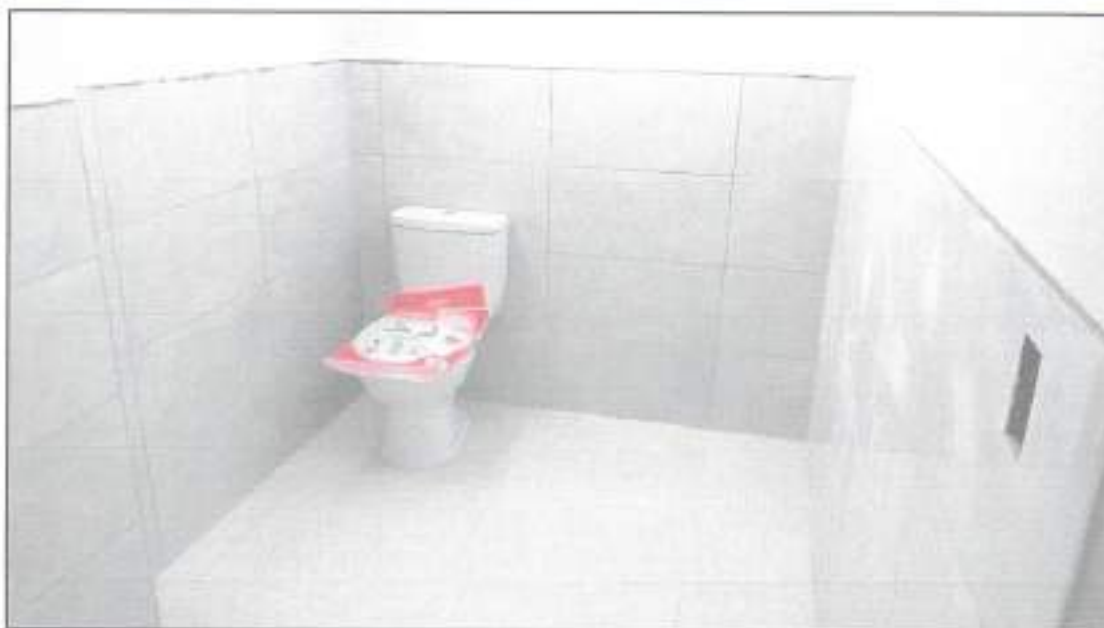
Fotografía N° 17: se aprecian la instalación de los inodoros en los servicios higiénicos, del módulo de oficina.
