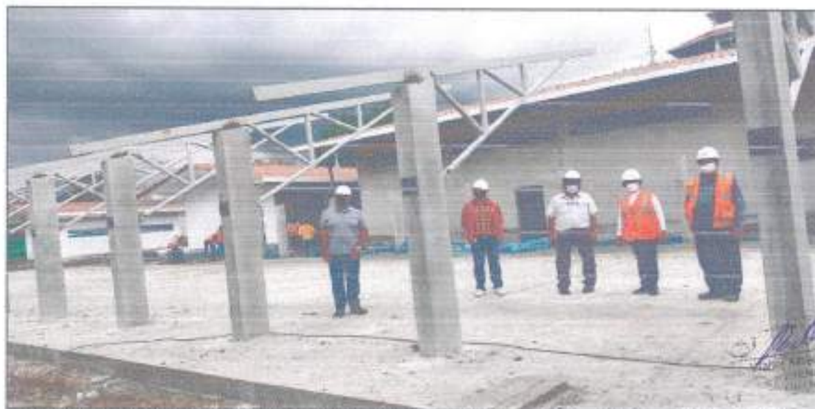
Fotografía N° 14: se tuvo la visita de los representantes de Prodesa, donde verificaron el avance de la obra.
