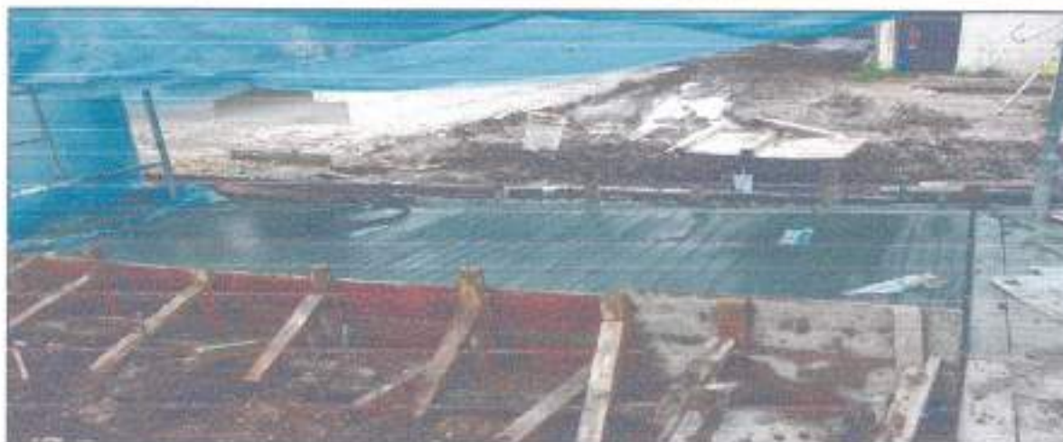
Fotografía N° 03: en esta imagen se aprecia el vaciado y bruñado de la rampa.
