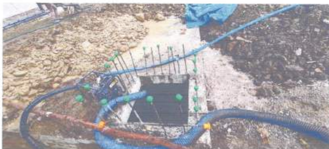
Foto 03: Entrada a cisterna, con motobomba para eliminar el agua y construcción de sumidero de cisterna.
