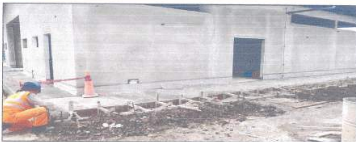
Fotografía N° 06: en esta imagen se aprecia la personal de obra, realizando trabajos de desenformado en veredas.
