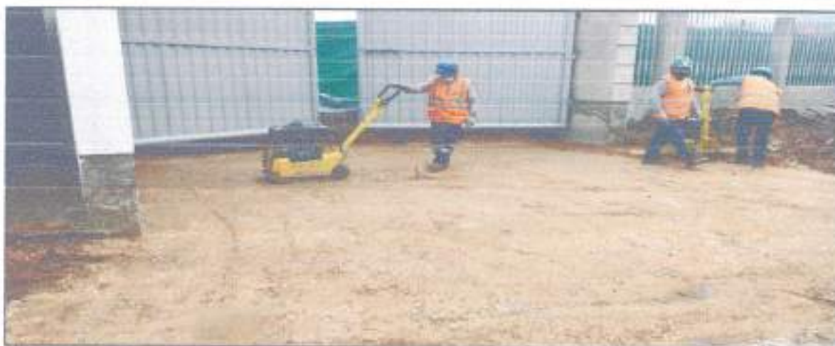
Fotografía N° 12: en la imagen se aprecian los trabajos de compactado afirmado, en el ingreso vehicular.
