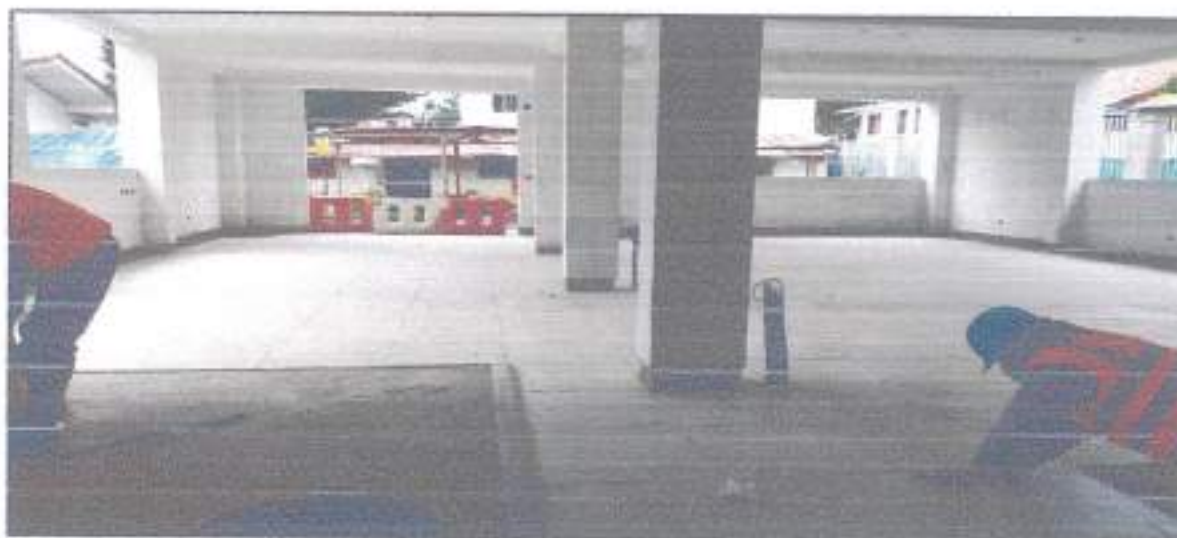
Fotografía N° 08: en la imagen se aprecian los trabajos de enchapado de porcelanato en los módulos de oficina, cocina comedor y auditorio.
