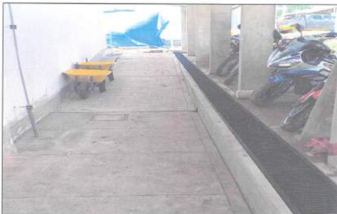
Fotografía N° 16: en esta imagen se aprecia la instalación de las rejillas en las canaletas del estacionamiento por el auditorio.
