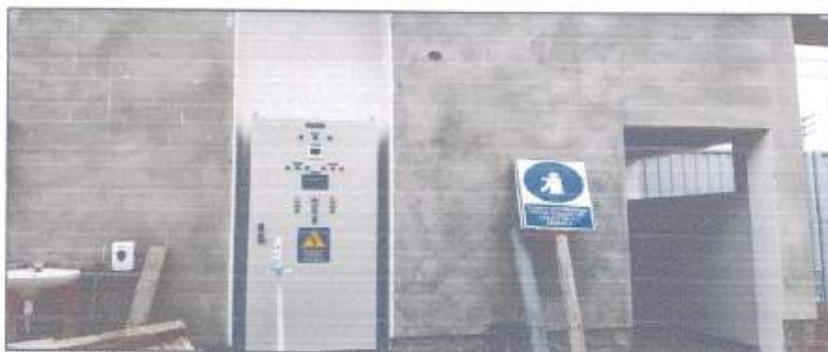
Fotografía N°09: se muestra la instalación del tablero general TDG, afueras del módulo vigilancia.
