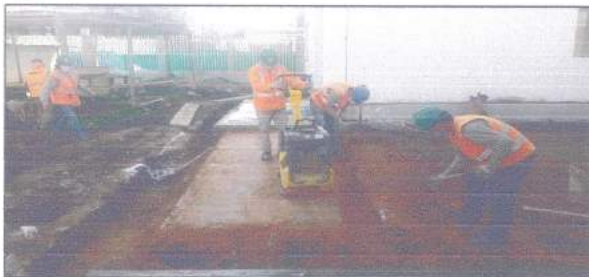
Fotografía N° 04: en esta imagen apreciamos los trabajos de compactación y nivelación para el vaciado de concreto en las veredas.
