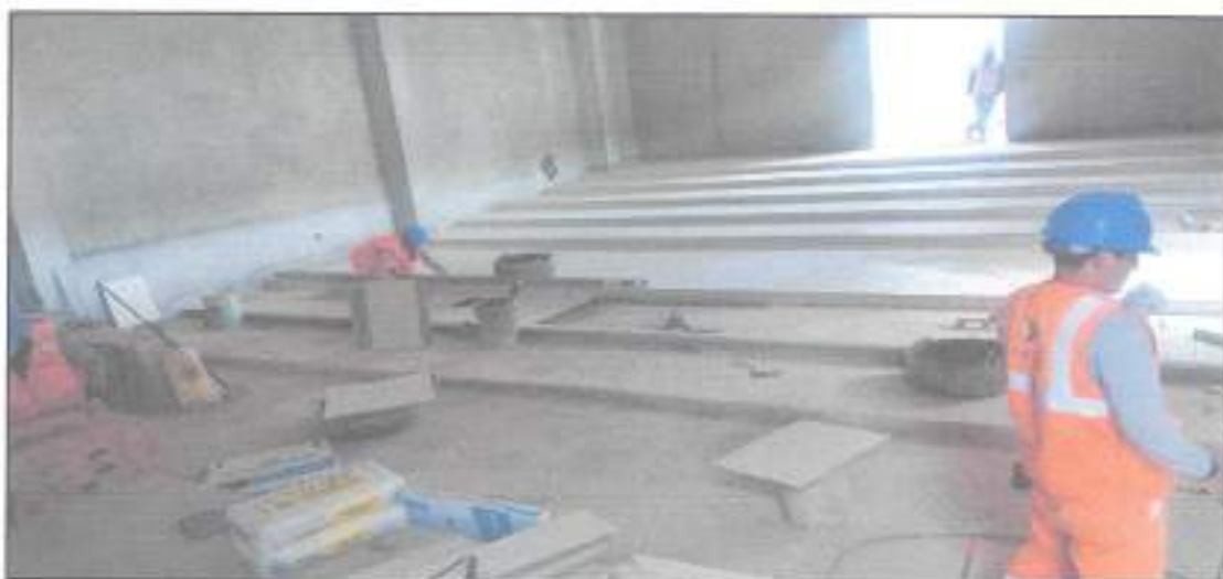
Fotografía N° 15: en la imagen se aprecia el enchapado de porcelanato rectificado concreto hueso 60 x 60, en el módulo auditorio.
