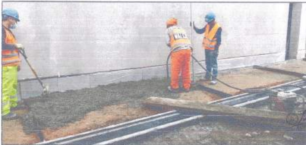
Fotografía N° 05: en esta fotografía se aprecia al personal de obra realizando trabajos del vaciado de concreto f_c: 175 \text{ kg/cm}^2 y el respectivo vibrado en veredas
