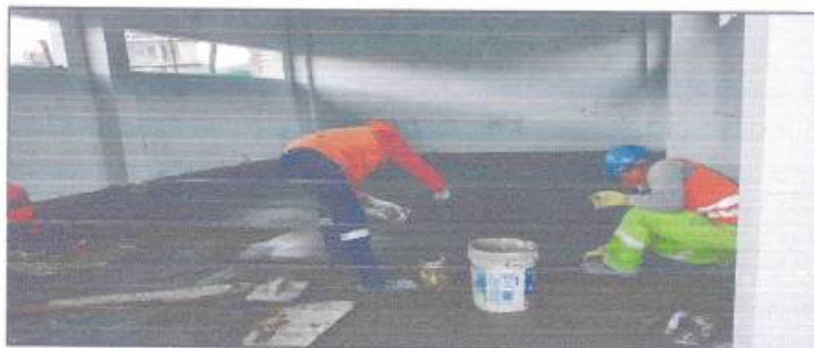
Fotografía N° 10: en la vista fotográfica se observa al personal de obra realizando trabajos de vaciado del piso la cual indica cemento pulido.
