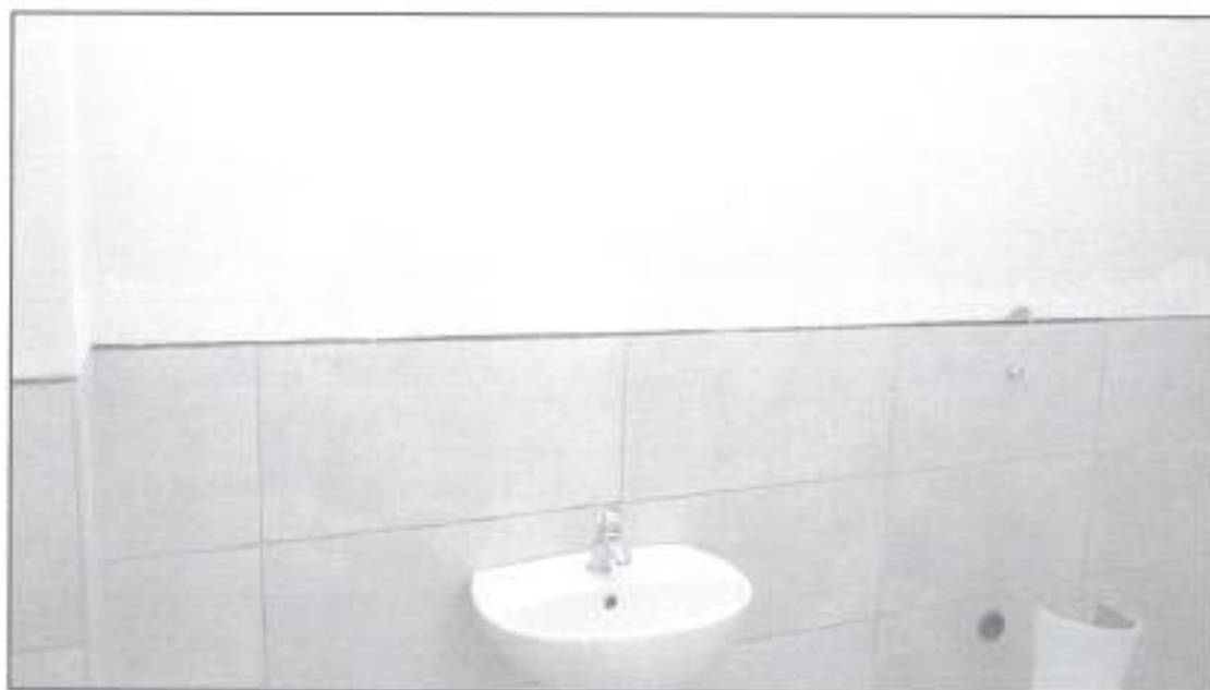
Fotografía N° 18: se aprecian la instalación de los lavaderos de mano y el urinario de los hombres.
