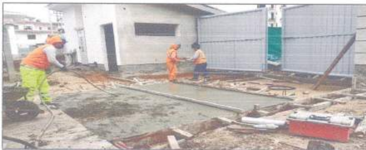
Fotografía N° 13: en la fotografía se aprecia el vaciado de concreto y el respectivo vibrado para evitar cangrejeras en la rampa de ingreso vehicular.
