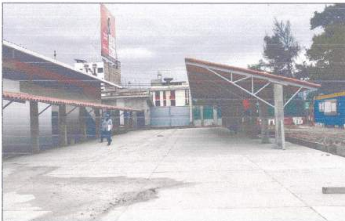
Fotografía N° 02: en esta imagen se aprecia la losa del estacionamiento y las coberturas de las estructuras metálicas.
