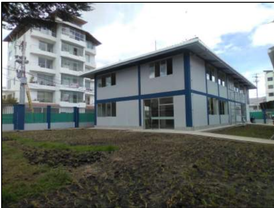
Fotografía N° 04: Se visualizan los acabados exteriores en el módulo de oficina.
