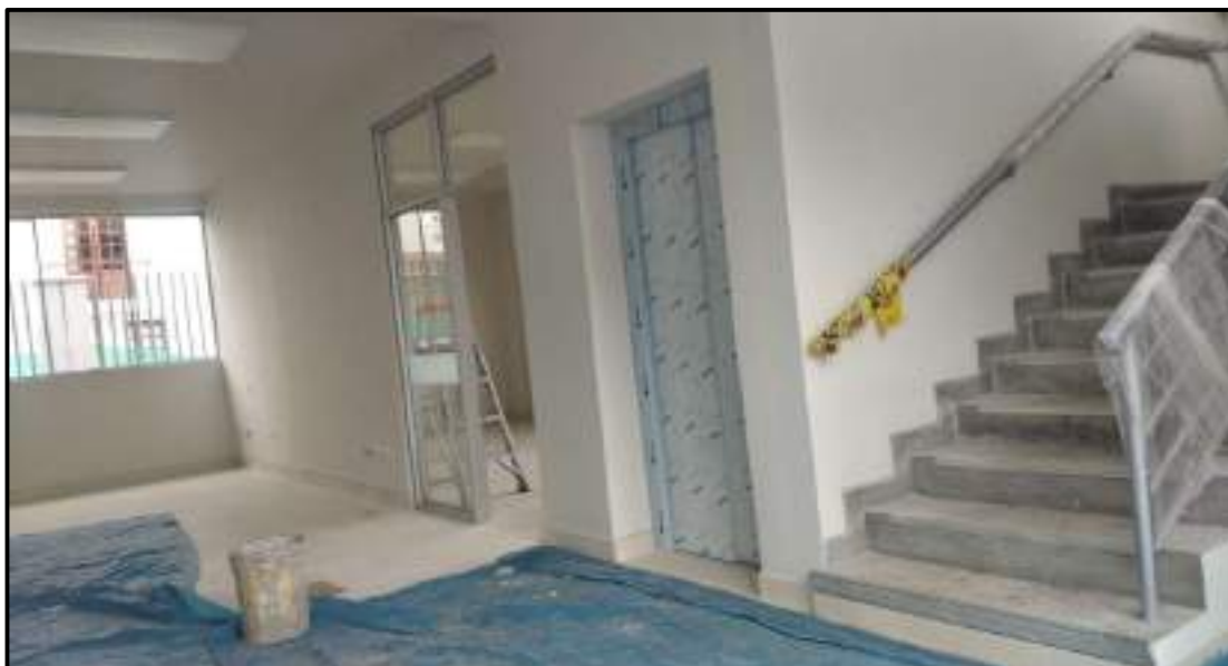
Fotografía N° 09: en esta imagen observamos el acabado en las escaleras y el ascensor.
