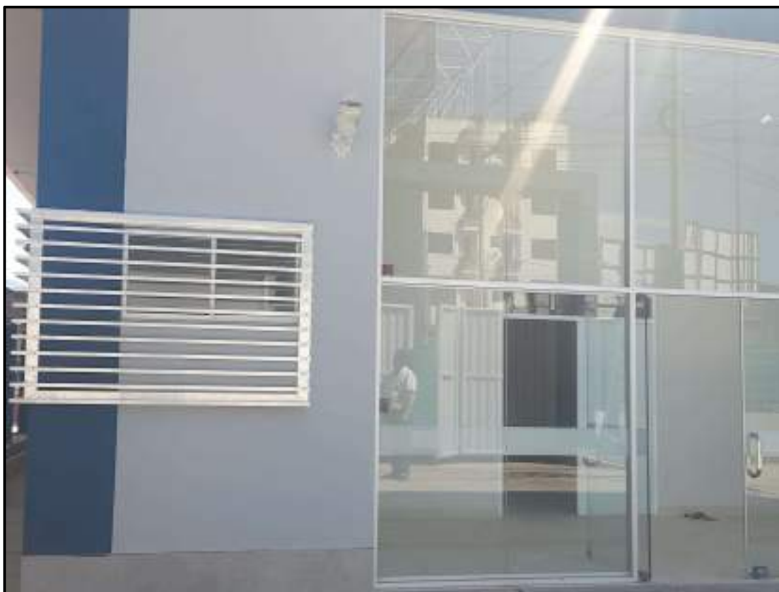
Fotografía N° 06: en esta imagen se observan las puertas, ventanas y acabado de pintura en el módulo de auditorio.
