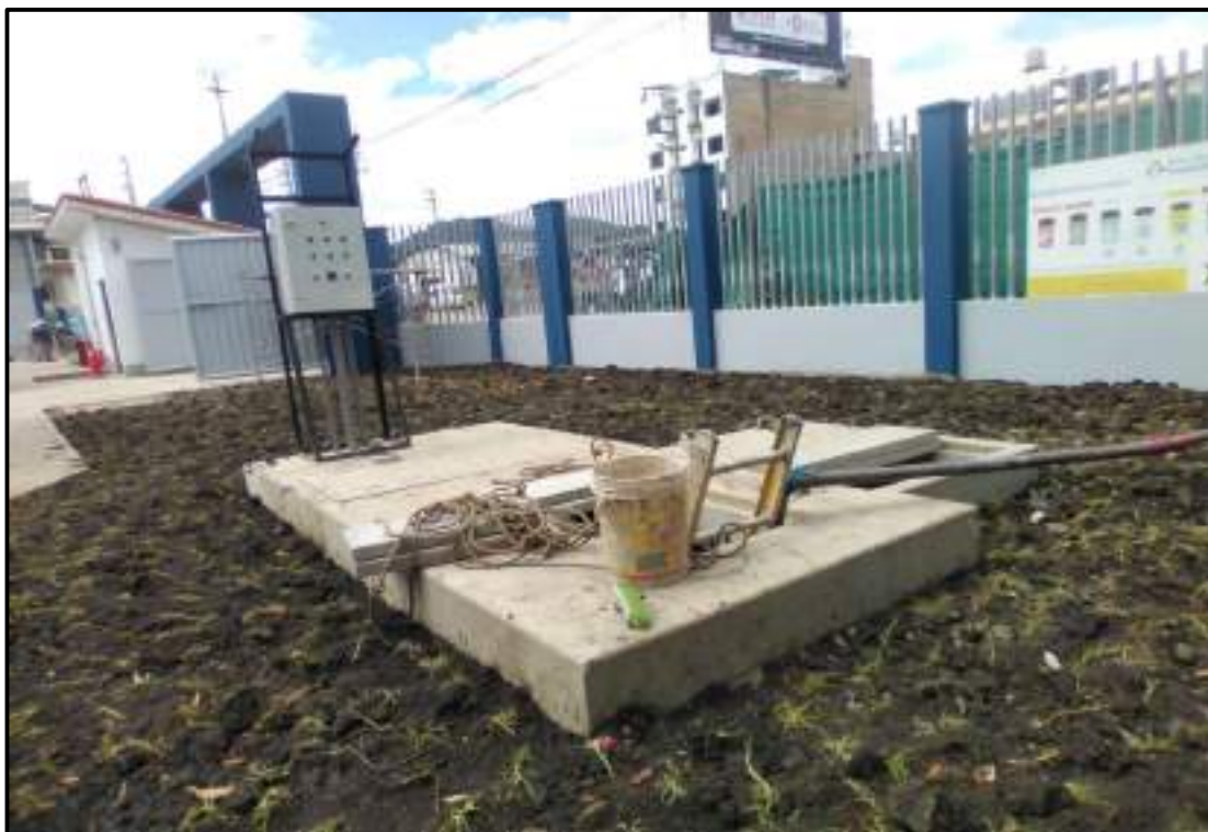
Fotografía N° 15: Se muestran trabajos acabados de la cámara de bombeo y la instalación del tablero eléctrico para bombas.
