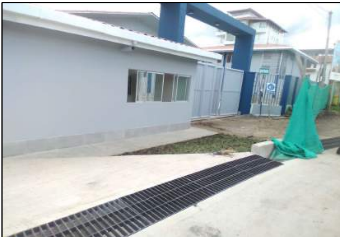
Fotografía N° 13: Se observan las rejillas en canaletas en el ingreso vehicular y acabados en pintura en el pórtico principal.
