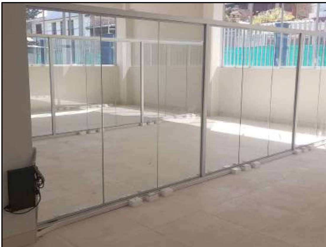
Fotografía N° 07: se visualiza el acabado de pintura, mamparas y tomacorrientes por el piso en el área administrativo - primer nivel de oficina
