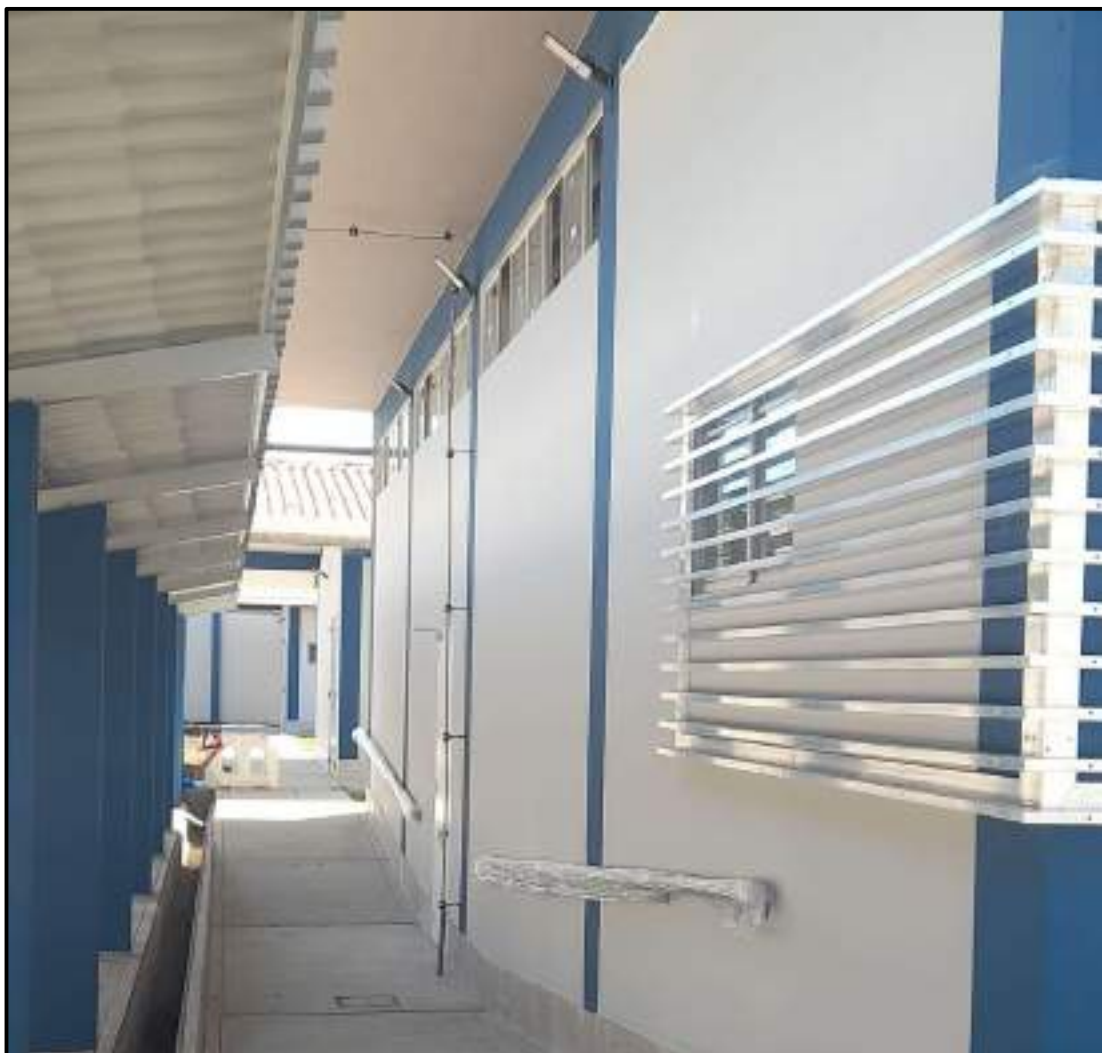
Fotografía N° 19: En la toma fotográfica se observa la instalación de pasamanos en el módulo auditorio y la pintura en el estacionamiento.
