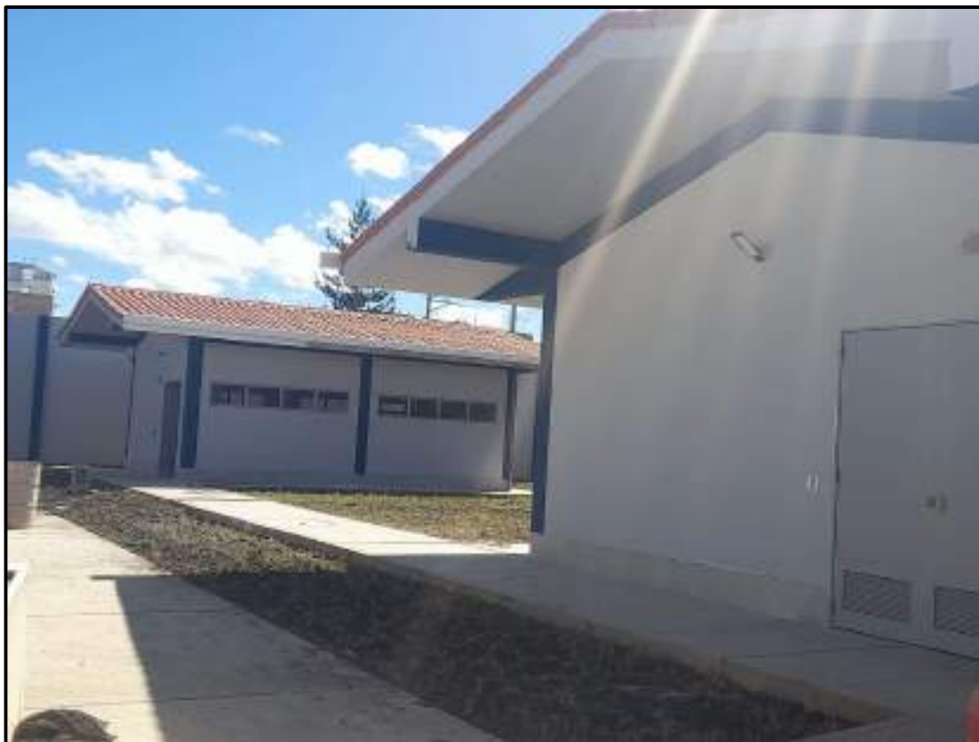
Fotografía N° 18: Se visualizan los acabados en pintura, puertas y ventanas en el módulo de cocina/ comedor y módulo de insumos tóxicos.
