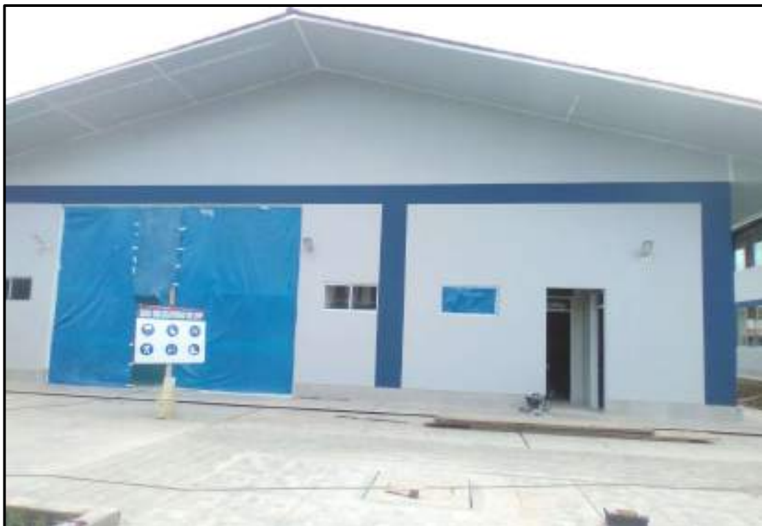
Fotografía N° 14: En esta imagen se visualiza los acabados de pintura en el módulo de auditorio.
