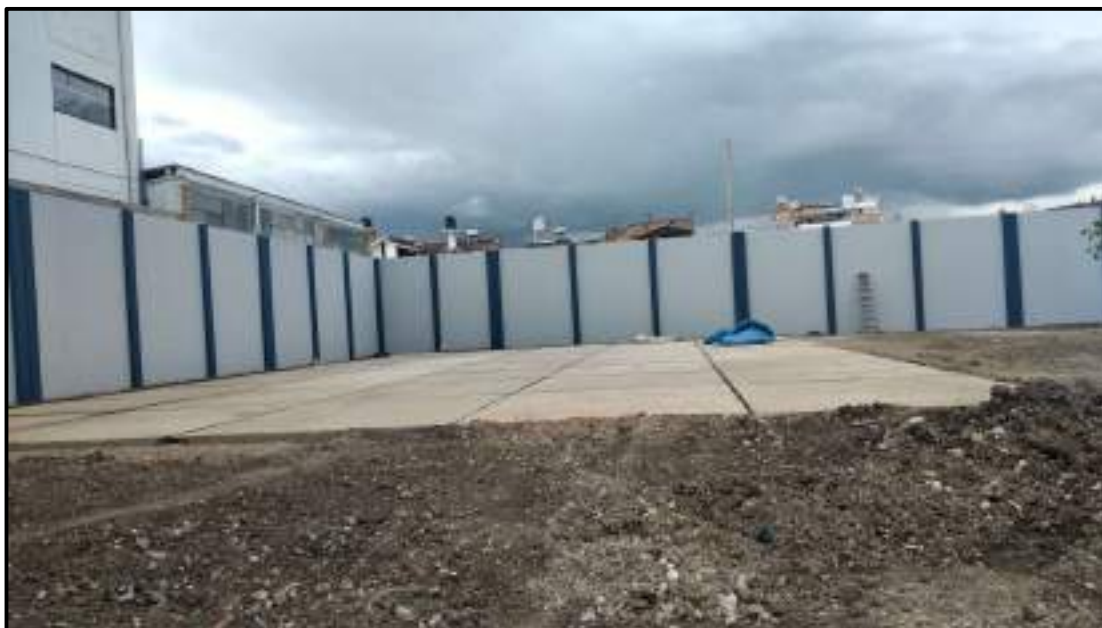
Fotografía N° 05: se observa el cerco perimétrico terminado al 100% y la losa deportiva.
