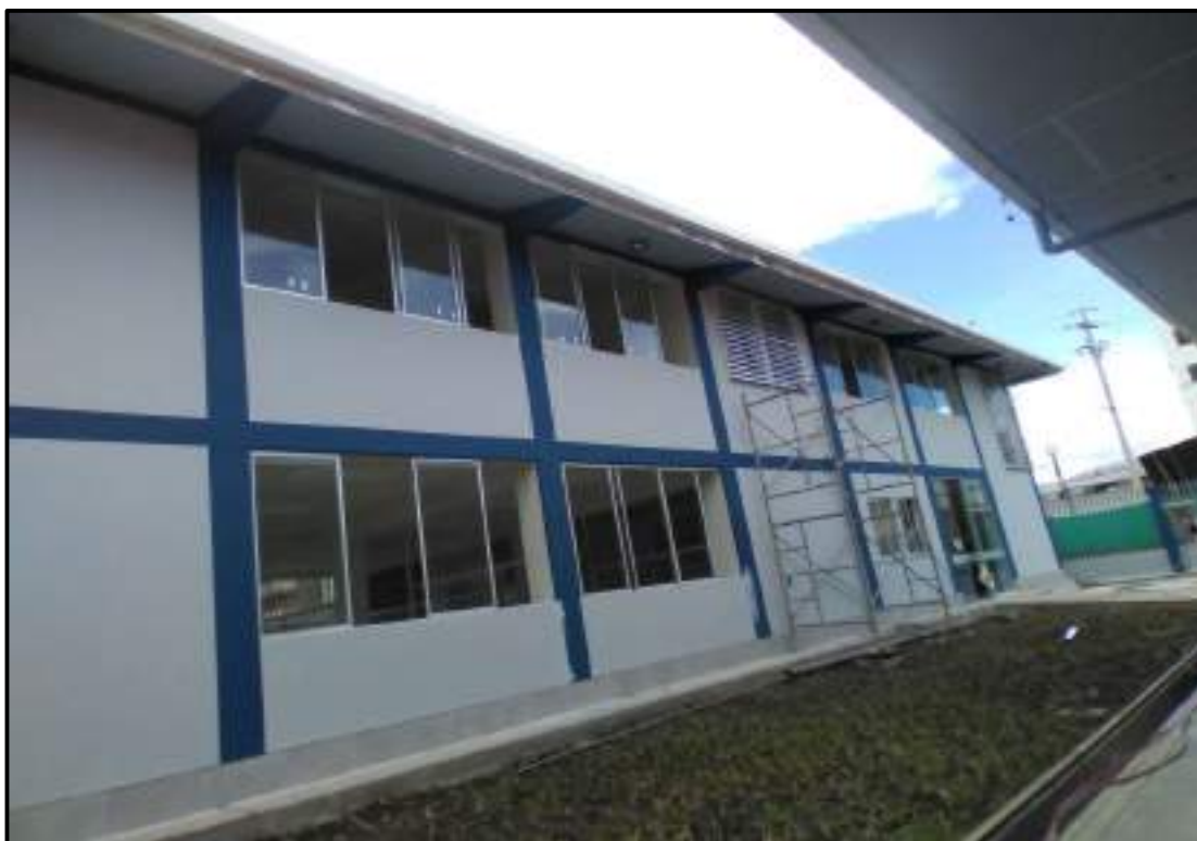
Fotografía N° 10: se visualiza la iluminación externa del módulo de oficina.
