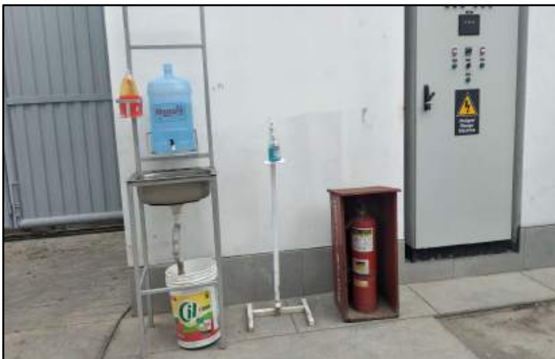
Fotografía N° 02: se observa en la fotografía los protocolos de lavado de mano, durante el proceso de ejecución de la obra,
