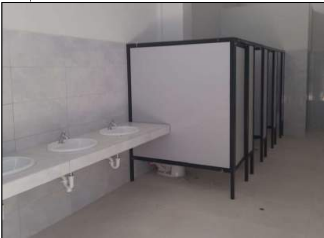
Fotografía N° 16: Se verifica la instalación de las divisiones con melamina en los servicios higiénicos del módulo de auditorio.
