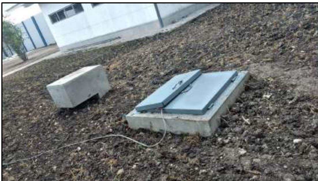
Fotografía N° 08: en esta imagen se observa los trabajos de acabados en la cisterna.
