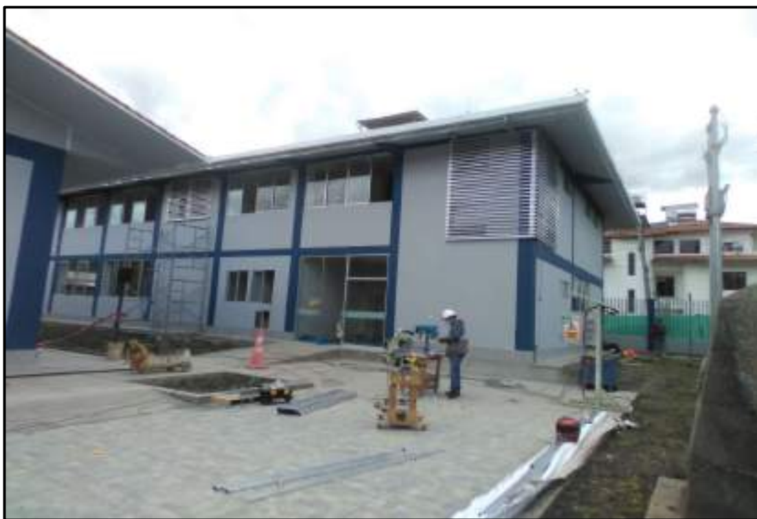
Fotografía N° 12: En esta imagen se visualizan los trabajos de acabados en pinturas e instalación de ventanas y puertas en el módulo de oficina.
