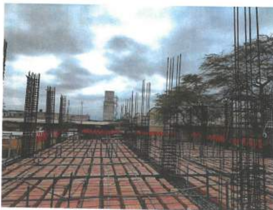
Bloque C antes de vaciado de concreto
