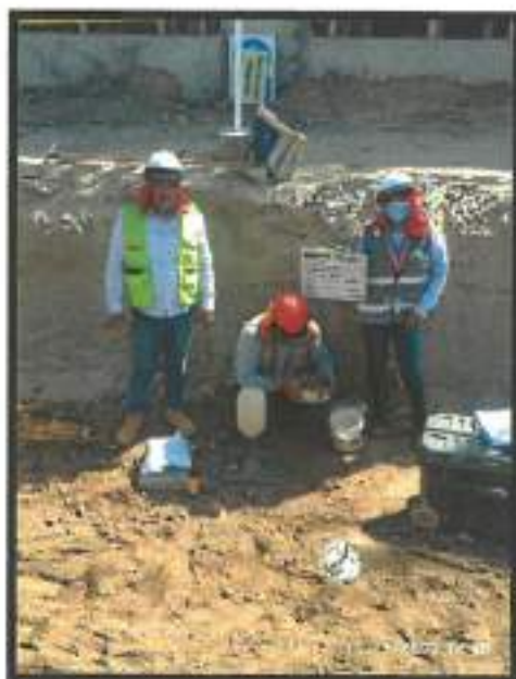
Verificación de ensayos de densidad de campo
