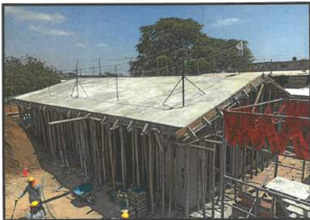
Avance del bloque E
