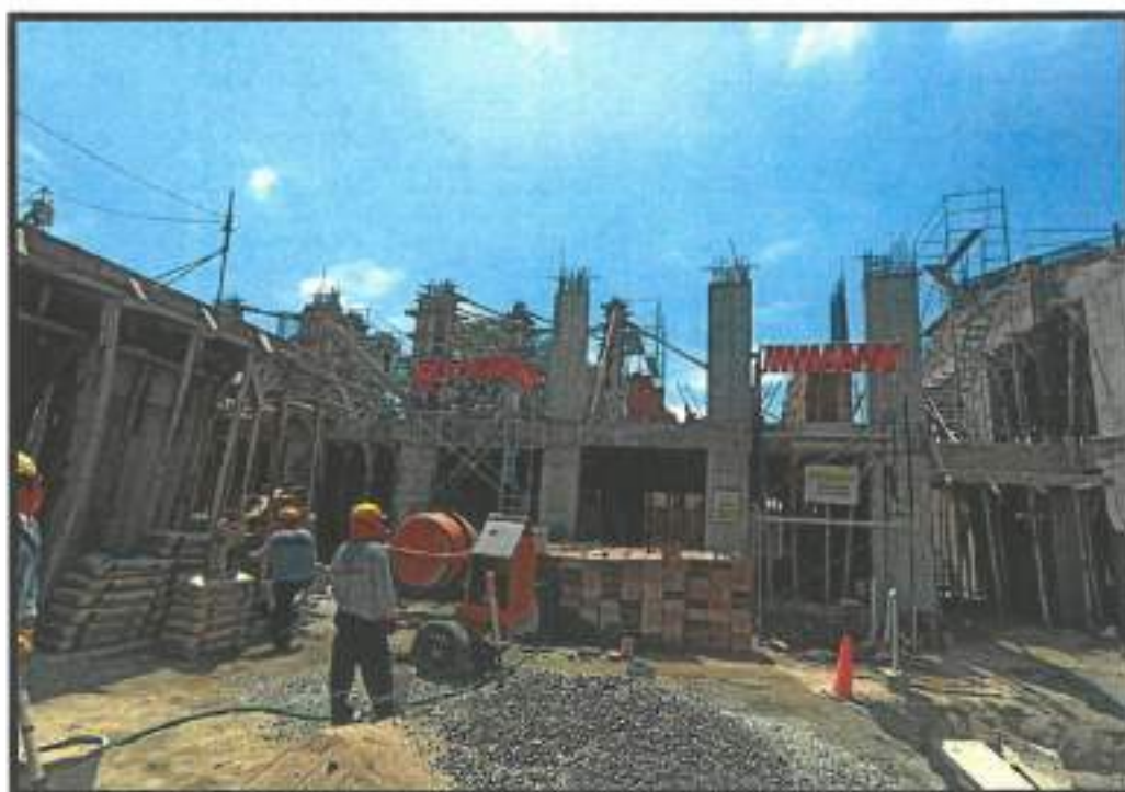
Avance del Bloque C
