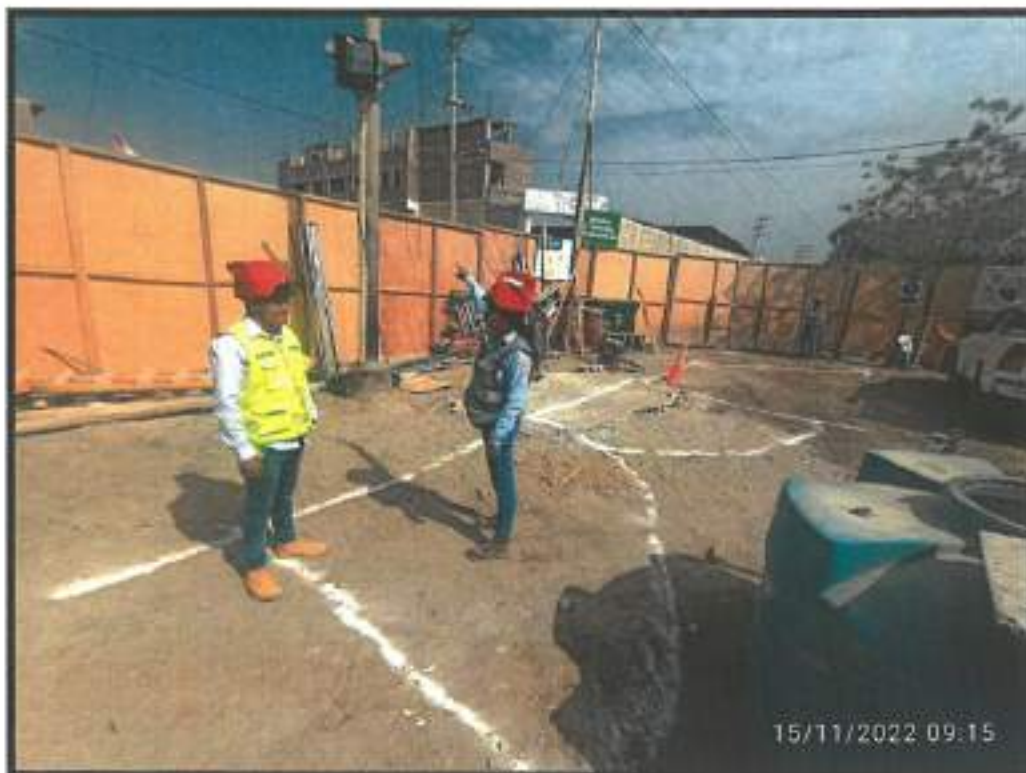
Verificación de trazado e interferencias
