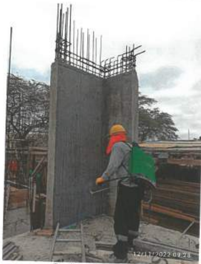
Curado de placa en bloque D
