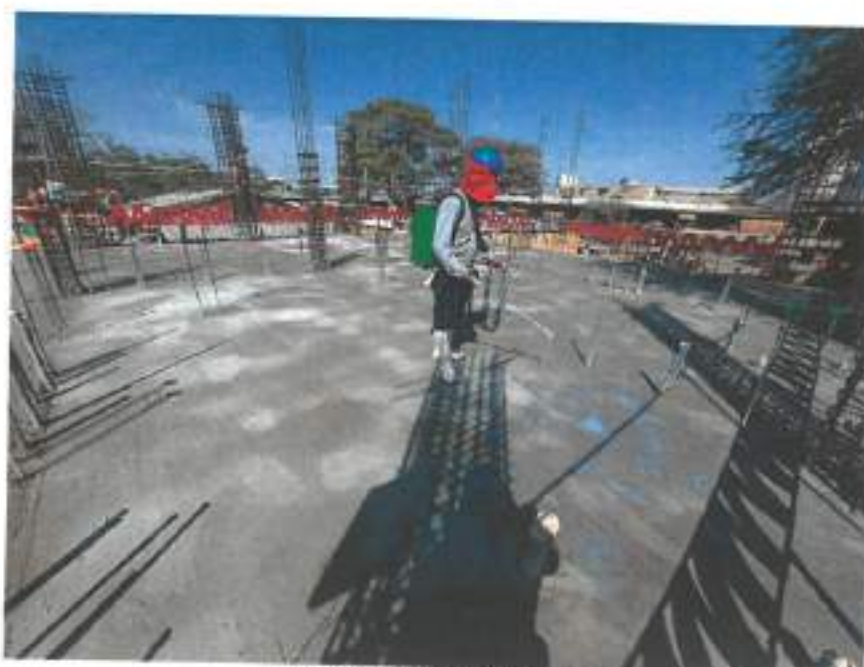
Curado de losa aligerada
