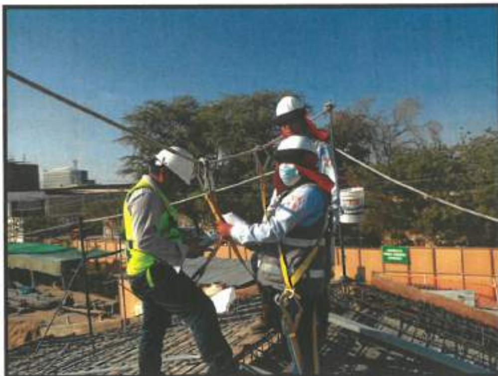
Verificación de instalaciones eléctricas pre vaciado
