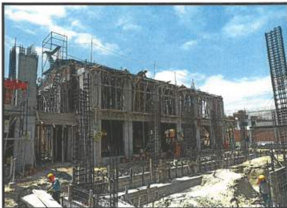
Avance de bloque D
