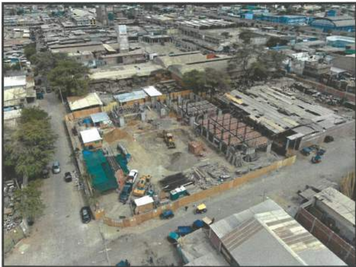
Vista Aérea de avance de obra
