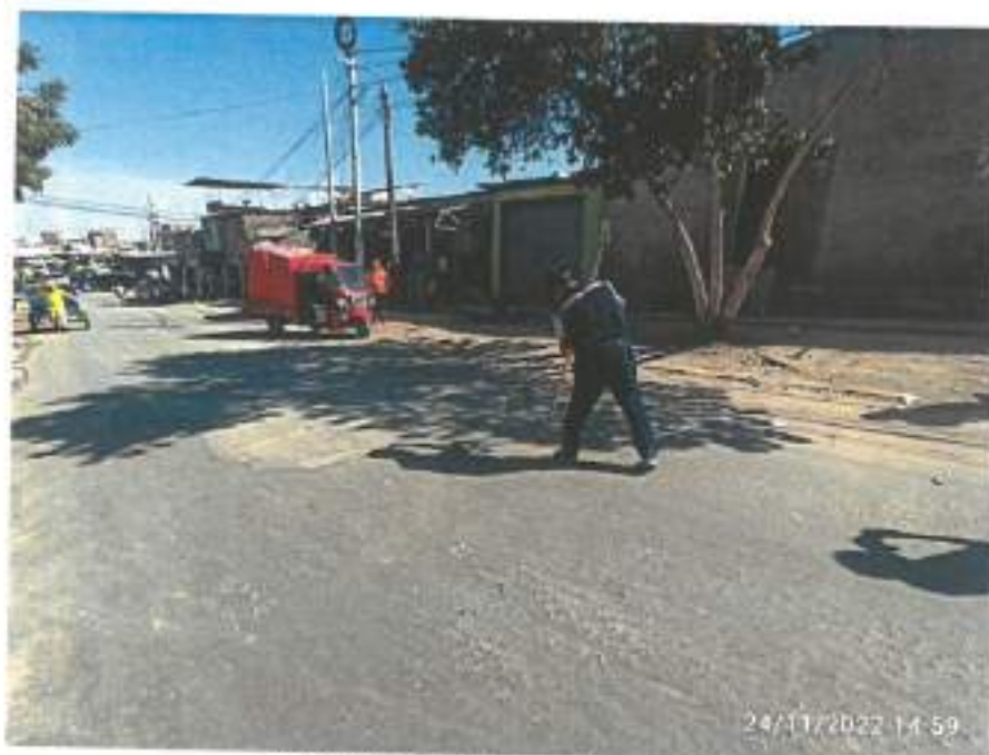
Avances en obra complementaria
