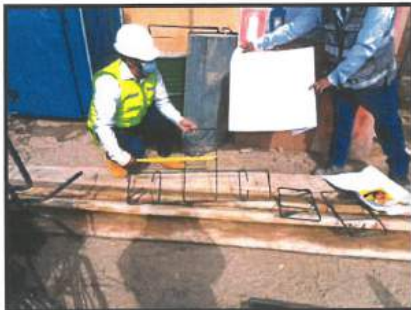
Verificación de dimensiones de estribos en columna
