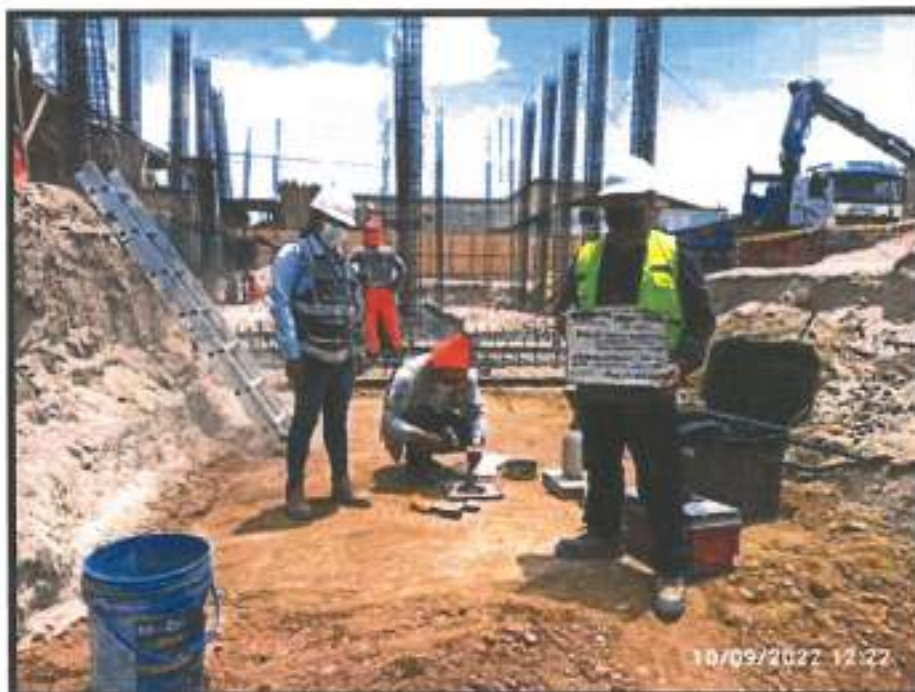
Verificación de ensayo de densidad de campo en bloque C
