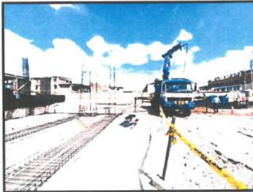
Colocación de columnas en bloque D
