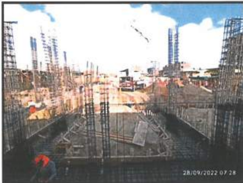
Vista posterior donde se observa los 3 bloques con su respectivo avance
