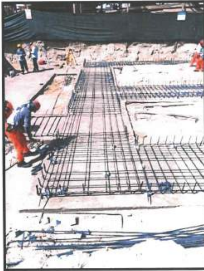
Colocación de acero en bloque D
