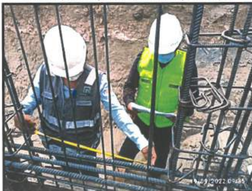
Verificación de distribución de aceros de refuerzo
