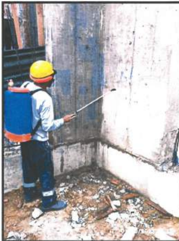
Curado de placa en bloque D
