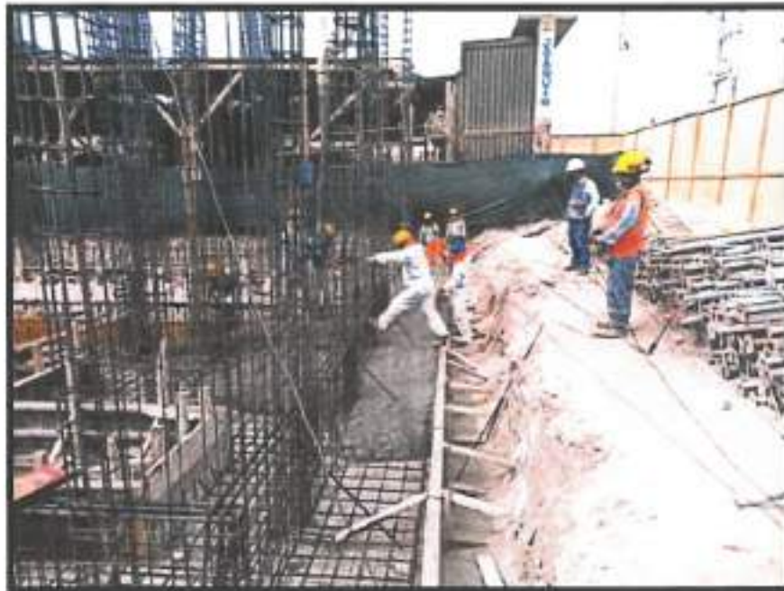
Vaciado de concreto en zapata de bloque D
