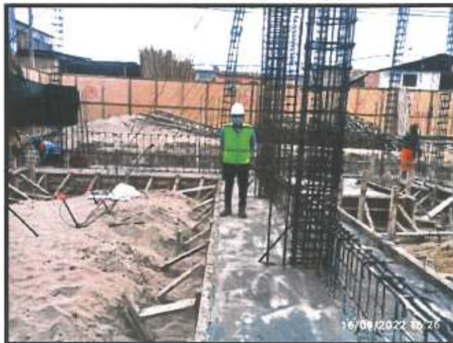
Verificación post vaciada de concreto en zapata
