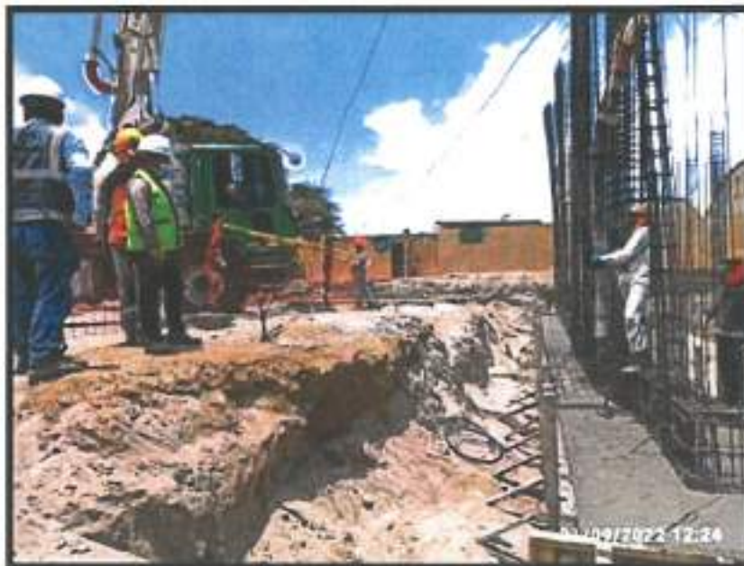
Verificación de vaciado de concreto
