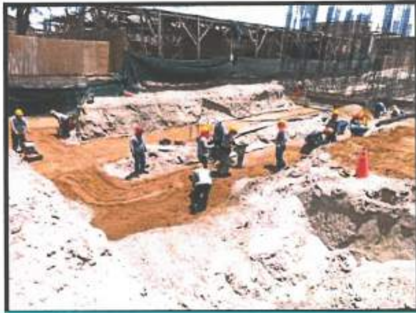
Colocación de afirmando para mejoramiento de la subrasante
