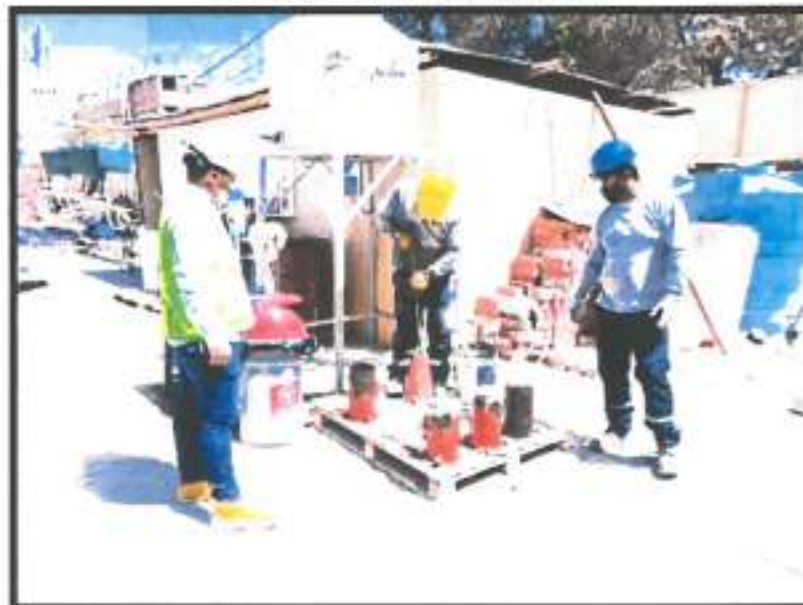
Verificación de slump de concreto pre mezclado
