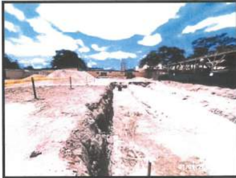
Excavación para cimiento en bloque D
