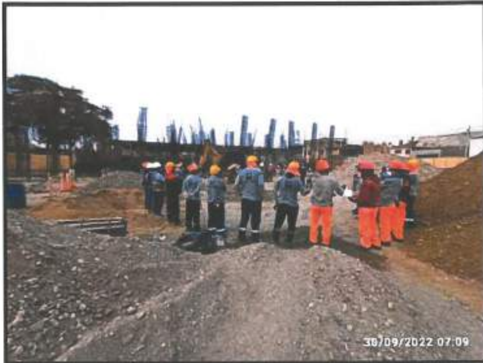
Charlas de seguridad previo al inicio de labores
