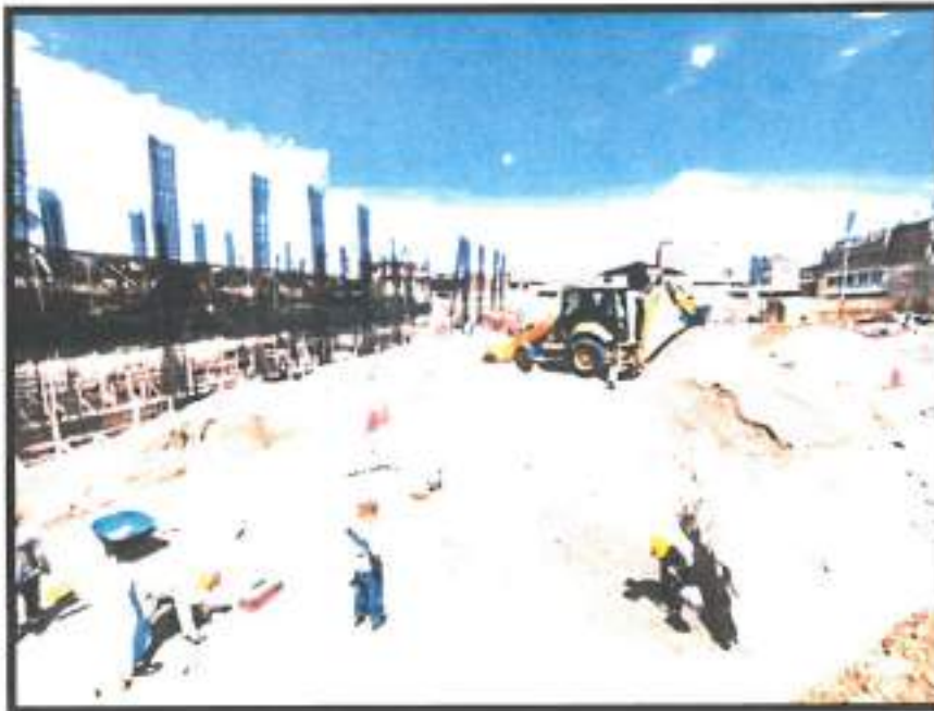
Excavación a nivel de mejoramiento en bloque E
