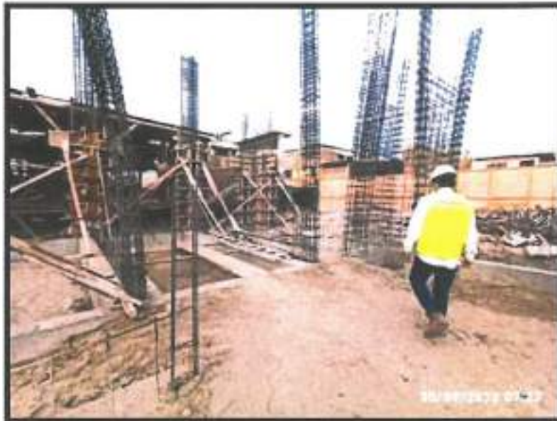
Verificación de encofrados
