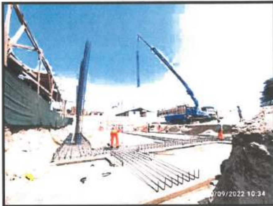
Colocación de columnas
