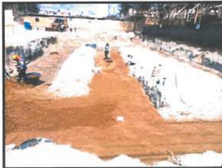
Colocación de afirmando para mejoramiento de la subrasante en bloque D
