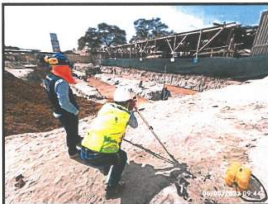
Verificación de nivel de primera capa de mejoramiento de subrasante
