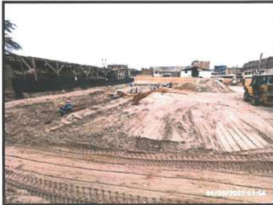
Excavaciones y colocación de mejoramiento de subrasante
