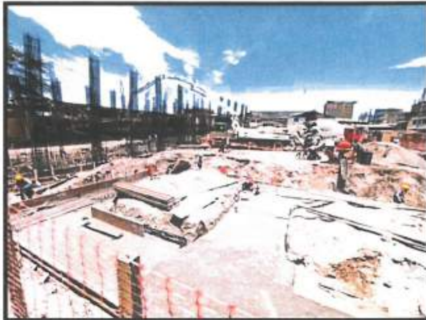
Vista de bloques C, D y E
