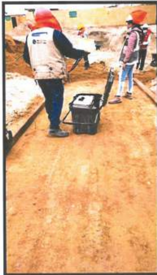
Ensayos de densidad de campo en bloque D
