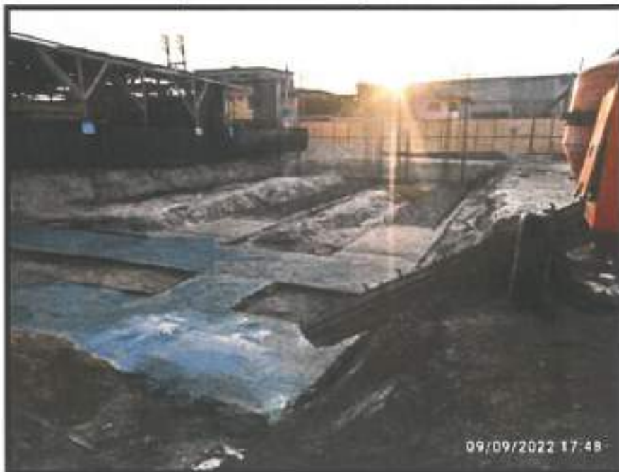
Colocación de solado en bloques C y D
