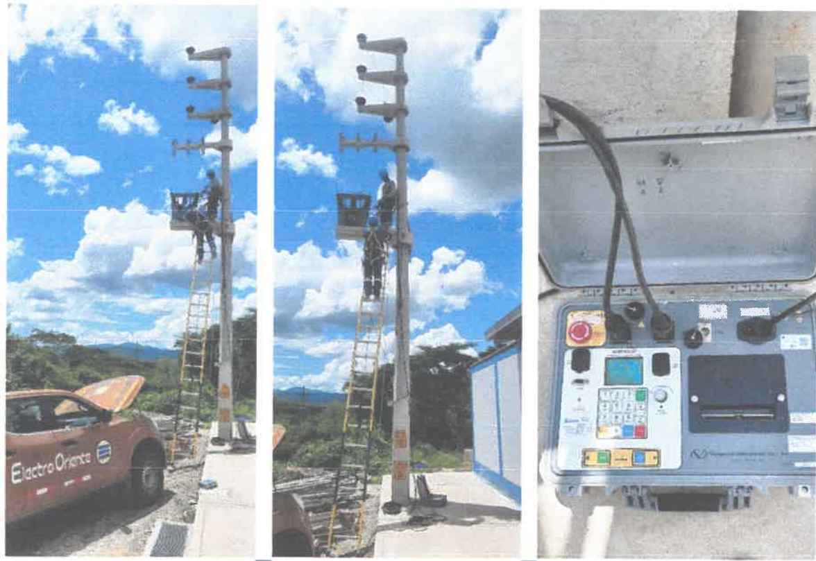
Foto N° 1 PRUEBAS EFECTUADAS POR LA CONCESIONARIA ELECTRO ORIENTE S.A. Constructora Inmobiliaria Río Huallaga S.A.C. RUC: 20450278051
