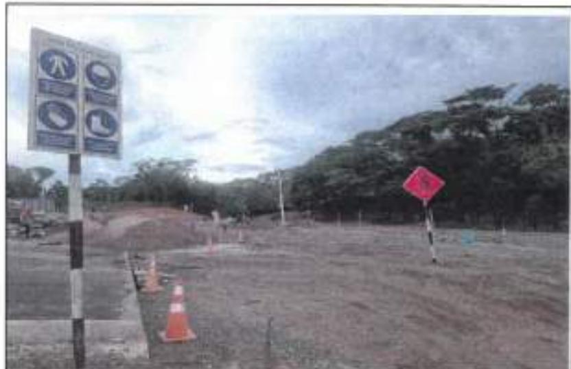
Foto N° 3: Se muestra la instalación de señalización de obligación en la zona de trabajo.
