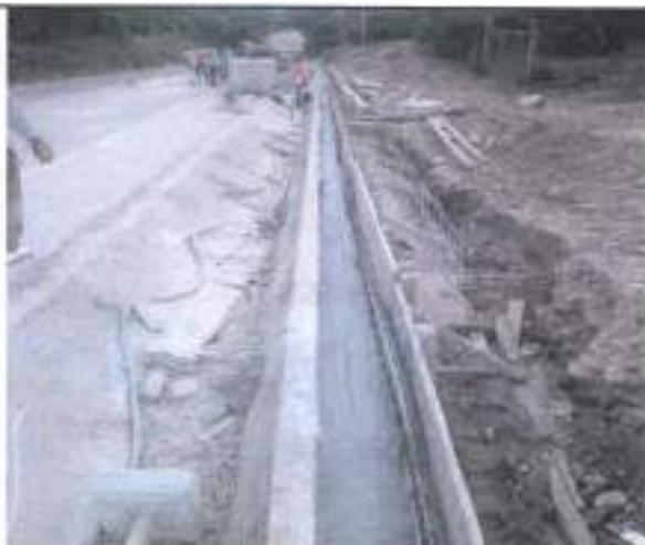
**FOTOGRAFIA 11:** VACIADO DE CONCRETÓ PRÉMEZCLADO DE F'c=210 KG/CM2 PARA DADO DE CIMENTACION PARA CUNETETA
