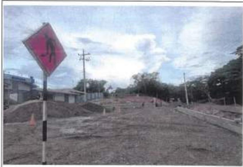
Foto N° 4: Se muestra la instalación de la señalización preventiva en la zona de trabajo.
