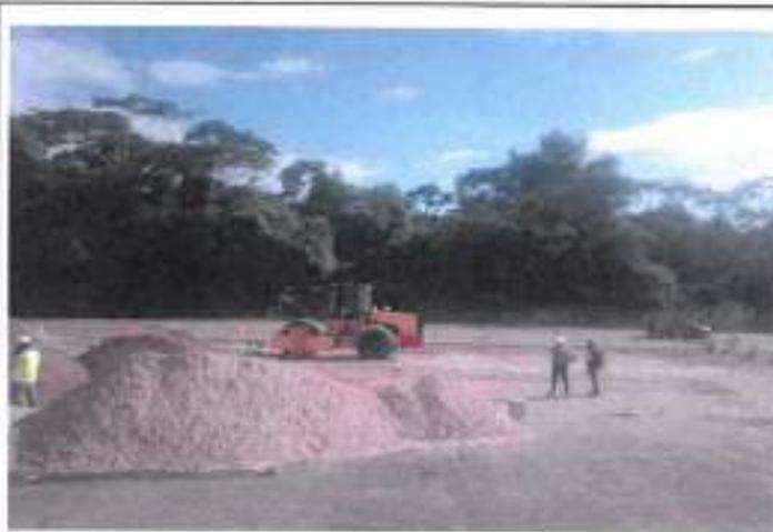
**FOTOGRAFIA 10:** COLOCACION DE LA SUB BASE GRANULAR E=0.30 M CON EQUIPO EN LA RAMPA DE INGRESO VEHICULAR.
