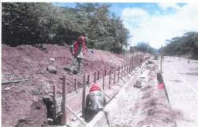
**FOTOGRAFIA 07:** ENCOFRADO NORMAL DEL SARDINEL REFORZADO.
