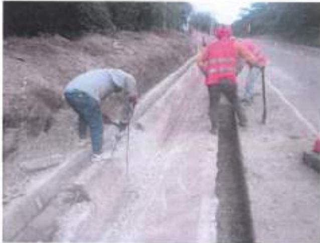
**FOTOGRAFIA 05:** DEMOLICIÓN PARCIAL DE CUNETAS EXISTENTES PARA LA CIMENTACIÓN DE DADOS
