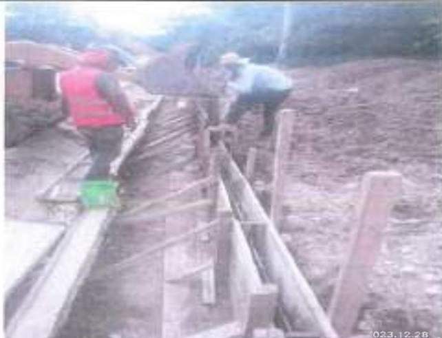
**FOTOGRAFÍA 09:** VACIADO DE CONCRETO PRÉMEZCLADO DE F'c=210 KG/CM2 EN SARDINELES REFORZADOS.
