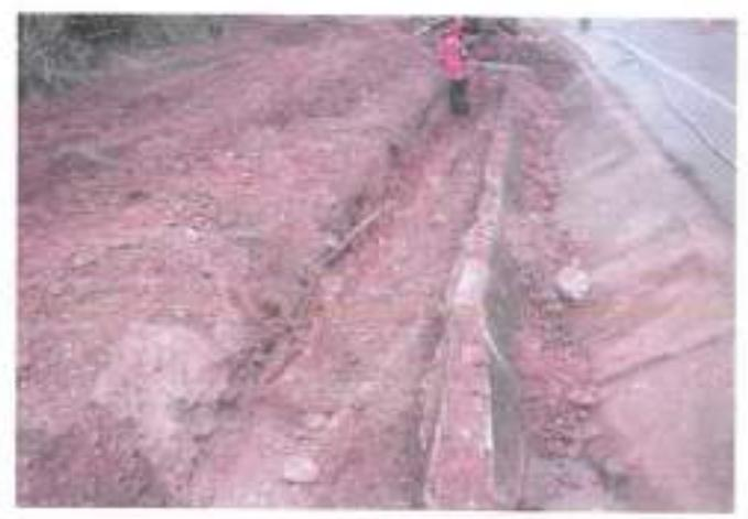
**FOTOGRAFIA 02:** EXCAVACIÓN MANUAL HASTA NIVEL DE CIMENTACIÓN PARA SARDINELES
