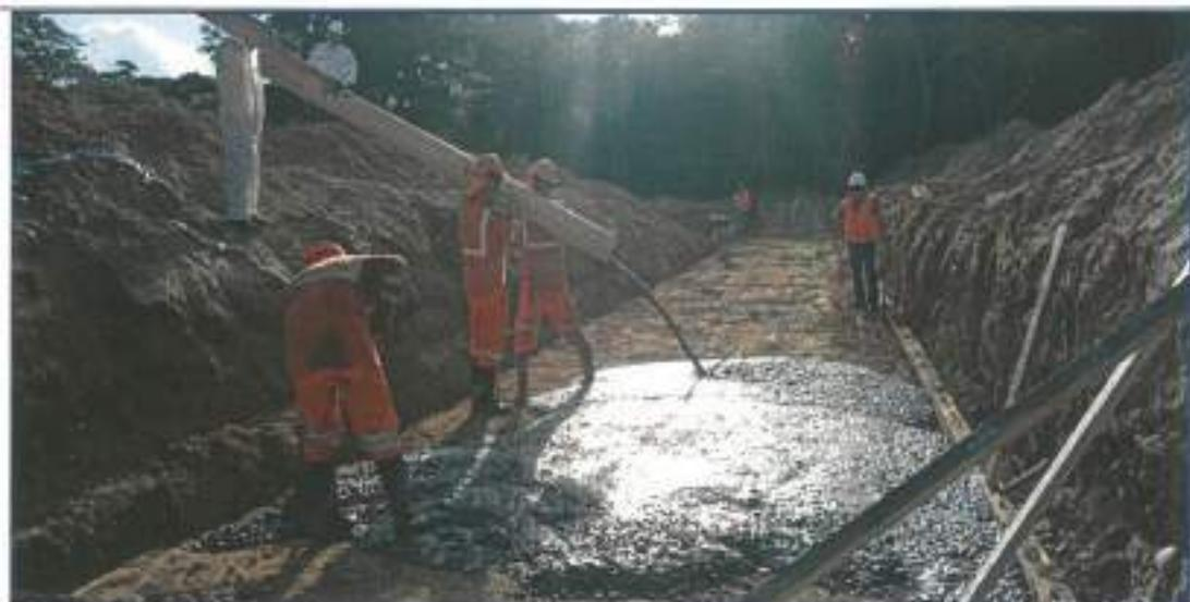
**Imagen N° 08:** Se verificaron los trabajos de vaciado de concreto para solado en el tramo 3-4.
