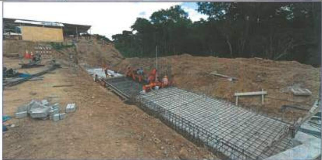
Imagen N° 18: Se verificaron los trabajos de acero de refuerzo para zapatas en el tramo 2-3, corte 8, 9 y 10.
