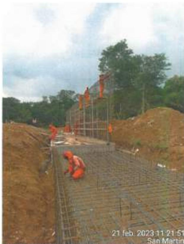
FOTOS: COLOCACION DE ACERO EN LA ZAPATA DEL TRAMO 3-4
