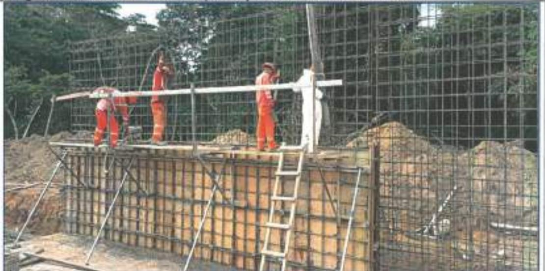
Imagen N° 13: Se verificaron los trabajos de encofrado previo vaciado de concreto  $f'c=210$  kg/cm<sup>2</sup> en muros de contención en el tramo 3-4, corte 11.
