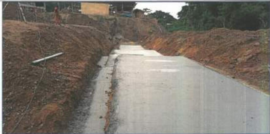
Imagen N° 17: Se verifico el vaciado de concreto para solado en el tramo 2-3, corte 8, 9 y 10.
