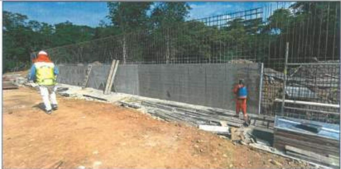
**Imagen N° 14:** Se verificaron los trabajos de curado de concreto  $f'c=210$  kg/cm<sup>2</sup> en muros de contención en el tramo 3-4, corte 11.
