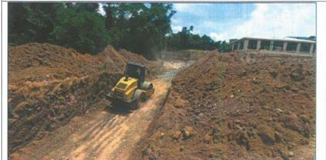
**Imagen N° 03:** Se verificaron los trabajos de compactación de material de préstamo en el tramo 3-4.
