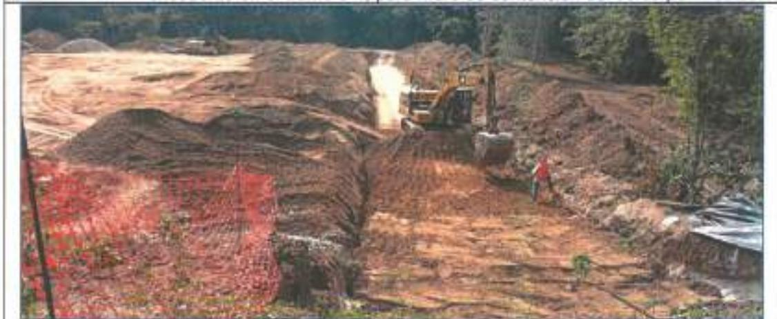
**Imagen N° 02:** Se verificaron los trabajos de relleno masivo con material de préstamo en el tramo 3-4.
