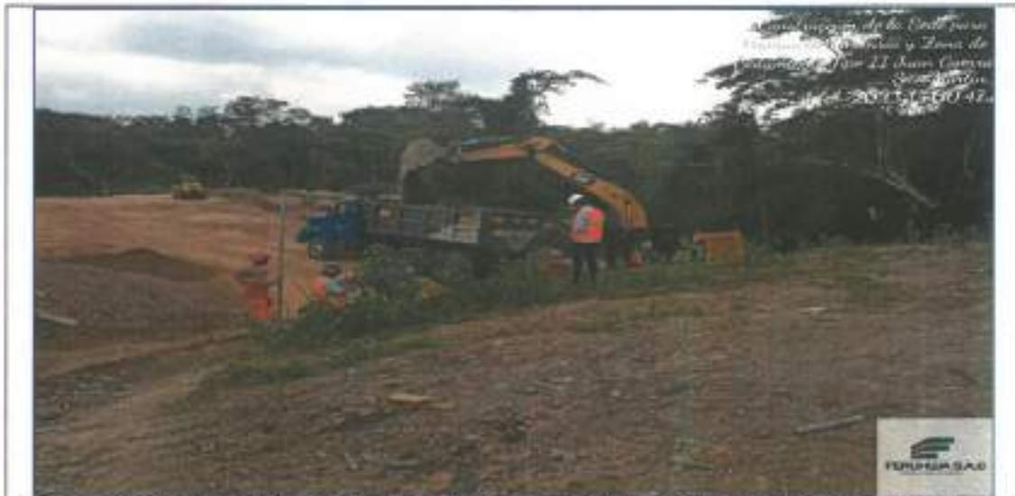
**Imagen N° 01:** Se verificaron los trabajos de excavación masiva y eliminación de material excedente en el tramo 3-4, para muro de contención del cerco perimétrico.
