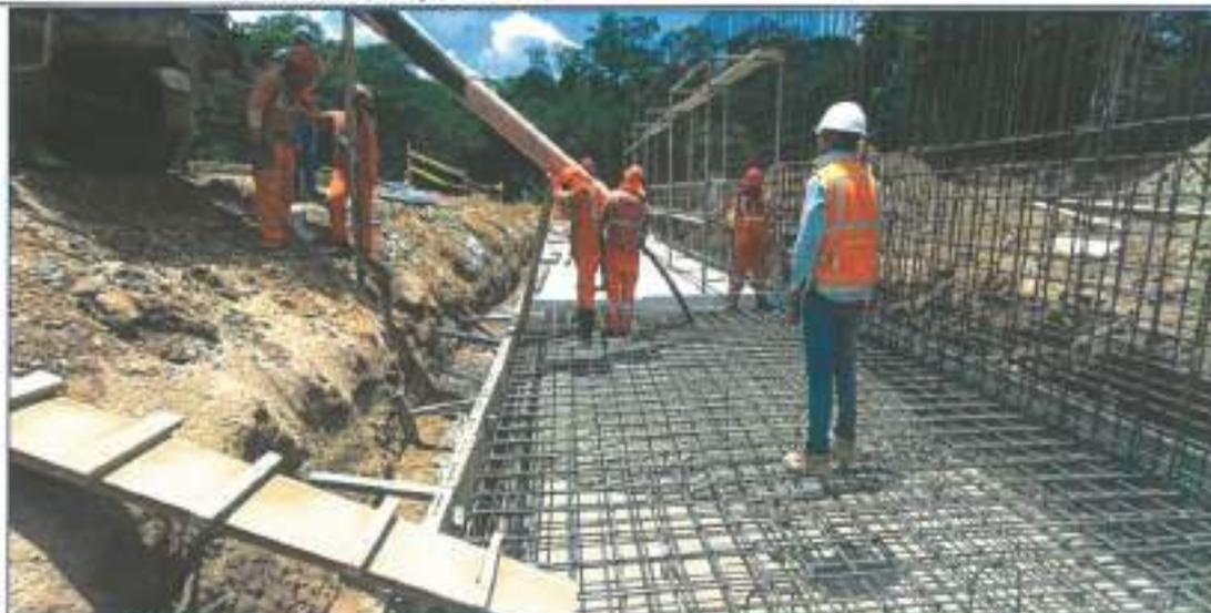
**Imagen N° 10:** Se verificaron los trabajos de vaciado de concreto  $f'c=210$  kg/cm<sup>2</sup> para zapata en el tramo 3-4, corte 11.
