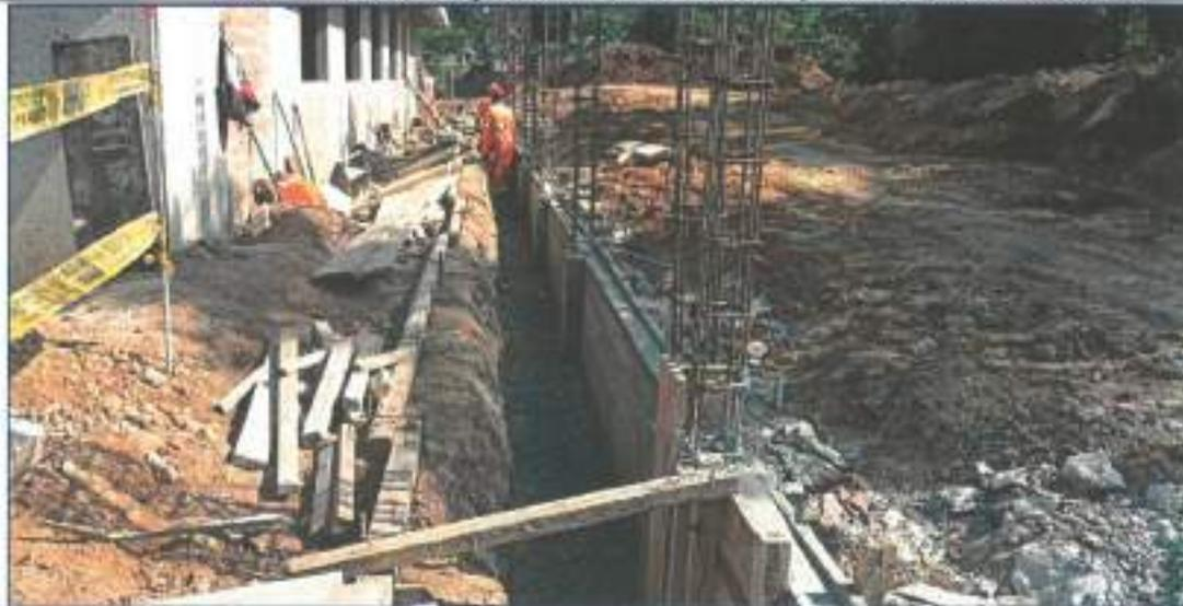
Imagen N° 07: Se verificaron los trabajos de concreto para sobrecimientos armado en el tramo 5-1.
