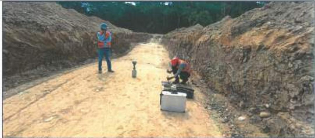
Imagen N° 04: Se verificaron los ensayos de densidad de campo en el tramo 3-4.
