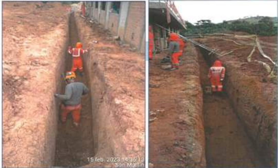
Imágenes N° 05 y 06: Se verificaron los trabajos de excavación manual, eliminación de material excedente y relleno con material de préstamo, en el tramo 5-1.
