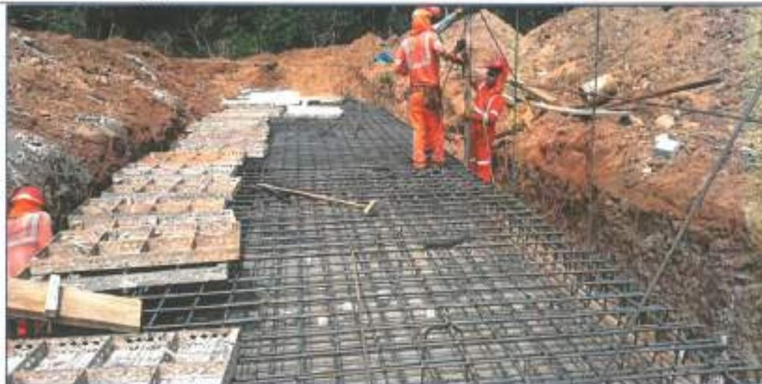
**Imagen N° 09:** Se verificaron los trabajos de armadura con acero de refuerzo para zapata en el tramo 3-4, corte 11.
