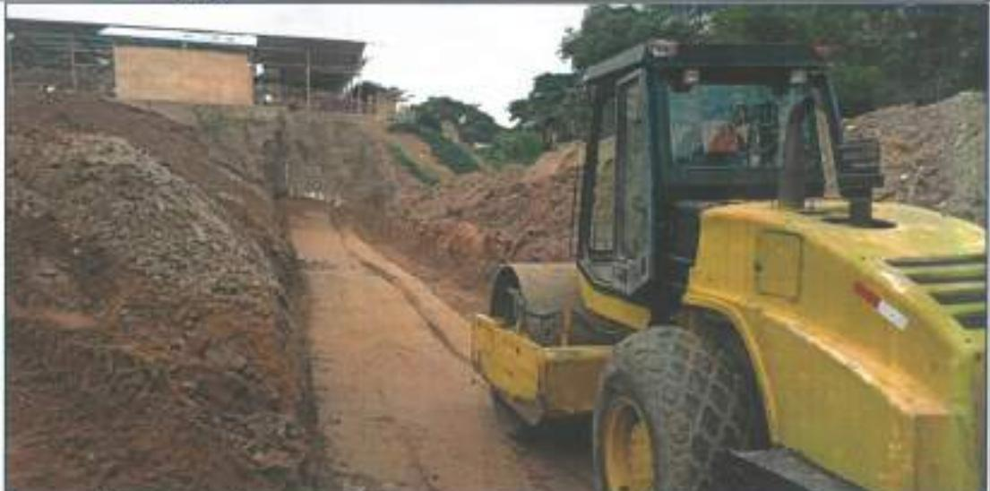
**Imagen N° 16:** Se verificaron los trabajos de relleno de material de préstamo y compactación de la misma en el tramo 2-3, corte 8, 9 y 10.
