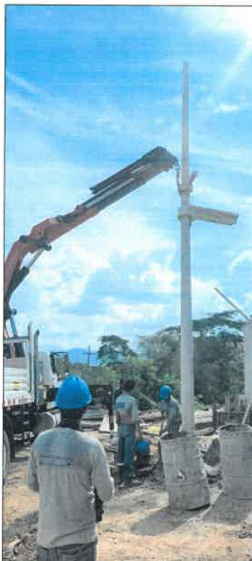
Foto N° 1 Trabajo de izado de poste de 13 m. para PMI
