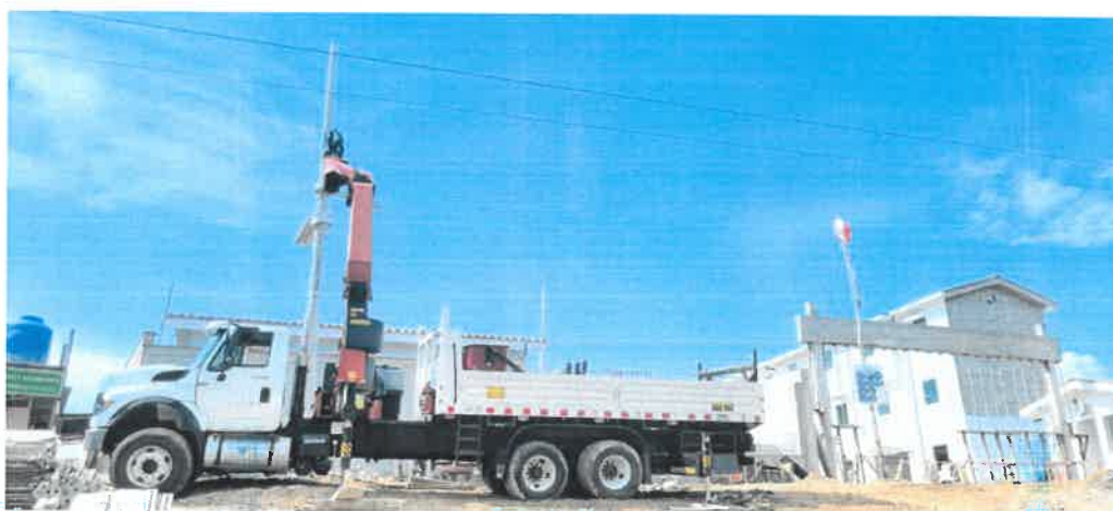
Foto N° 2 Trabajo de izado de Poste de media tensión con Grúa Hidráulica de 18 Tn.
