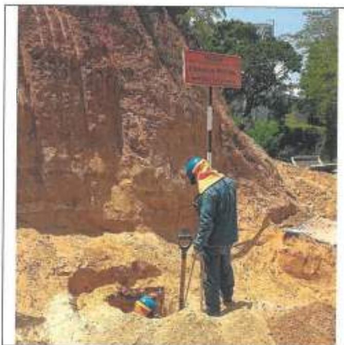
Foto N° 1: Se evidencia al personal operativo haciendo uso de su uniforme de trabajo en la actividad de excavación de pozo a tierra.
