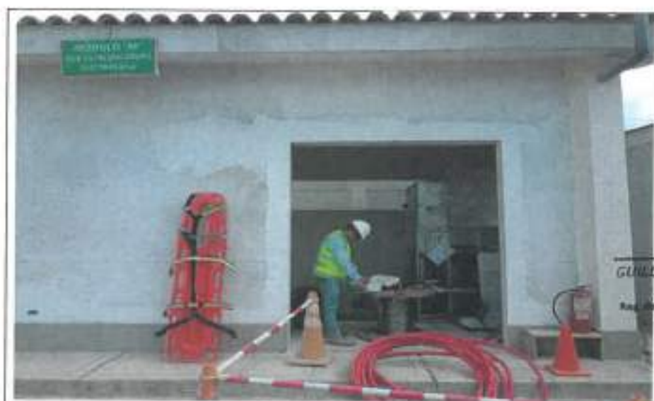
Foto N° 16: Se evidencia al especialista en SST realizando la inspección de botiquín de Primeros Auxilios en el módulo M.
