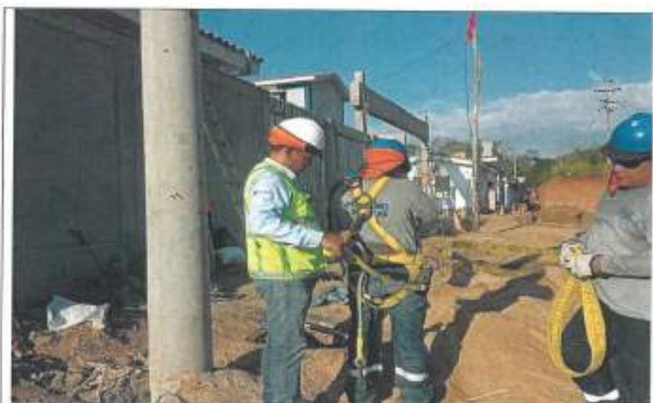
Foto N° 20: Se evidencia al especialista en SST realizando la inspección de arnés de seguridad, previo a la realización de trabajo en altura.
