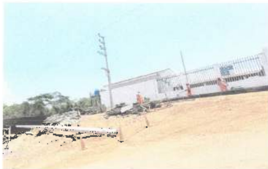
Foto N° 1 Trabajo de transporte de poste de 13 m y 15 m. Armado de estructuras de Derivación PMI SENASA e INIA
