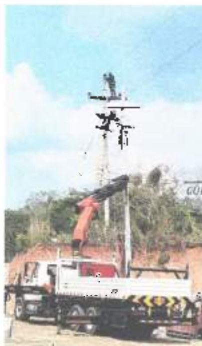
Foto N° 2 Trabajo de izada de Poste de 13 m y 15 m con Grúa Hidráulica de 10 Tn y 16 Tn respectivamente Las Estructuras fueron izadas debajo de la Línea Primaria Existente con Corte de Energía programado 24/09/23
