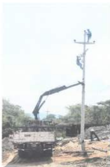
Foto N° 2 Trabajo de izada de Poste de 13 m y 15 m con Grúa Hidráulica de 10 Tn y 16 Tn respectivamente Las Estructuras fueron izadas debajo de la Línea Primaria Existente con Corte de Energía programado 24/09/23
