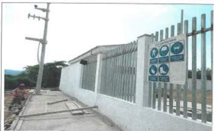
Foto N° 10: Se evidencia la instalación de la señal de obligación. Uso obligatorio de EPPs
