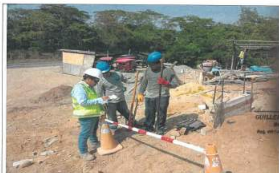
Foto N° 19: Se evidencia a la cuadrilla de instalación de media tensión.
