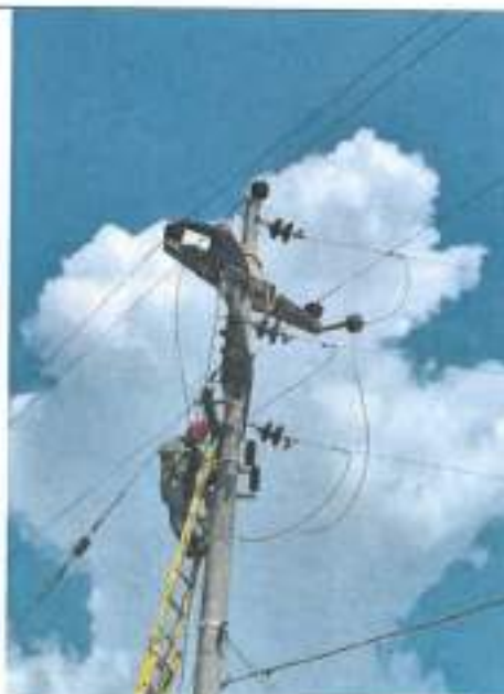
Foto N° 7: Se evidencia el uso de escalera entenable y amos de seguridad en la actividad de reconexión de línea eléctrica de media tensión.
