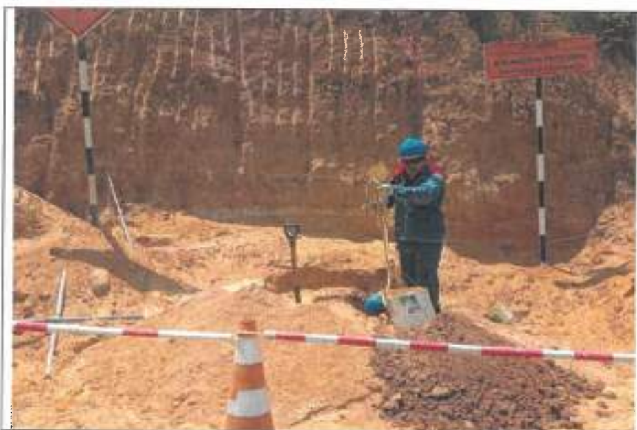
Foto N° 3: Se evidencia al personal operativo, haciendo uso de su EPPs, realizando la actividad de excavación de pozo a tierra
