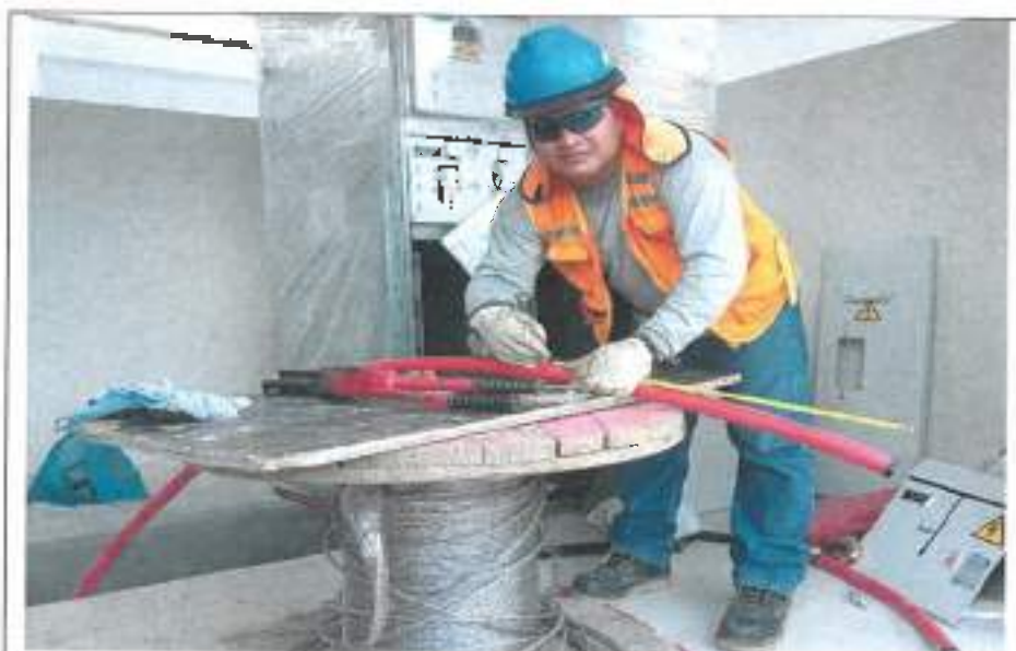
Foto N° 4: Se evidencia al personal operativo, haciendo uso de su EPPs, realizando la actividad de medición de cable seco para la instalación en celda de salida y protección tipo T.
