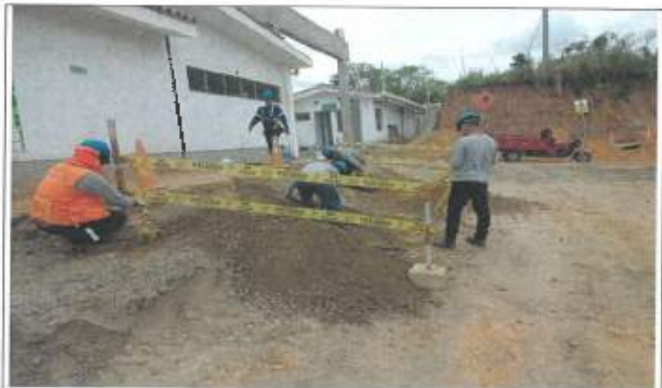
Foto N° 5: Se evidencia la instalación de conos, cinta peligro, listones de madera con base de concreto como delimitadores de la zona de excavación de pozo a tierra.
