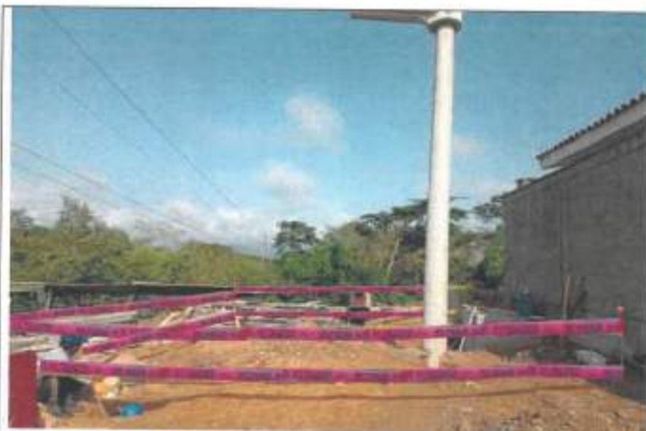
Foto N° 5: Se evidencia la instalación de cinta peligro en la delimitación de la zona de excavación de pozos a tierra.
