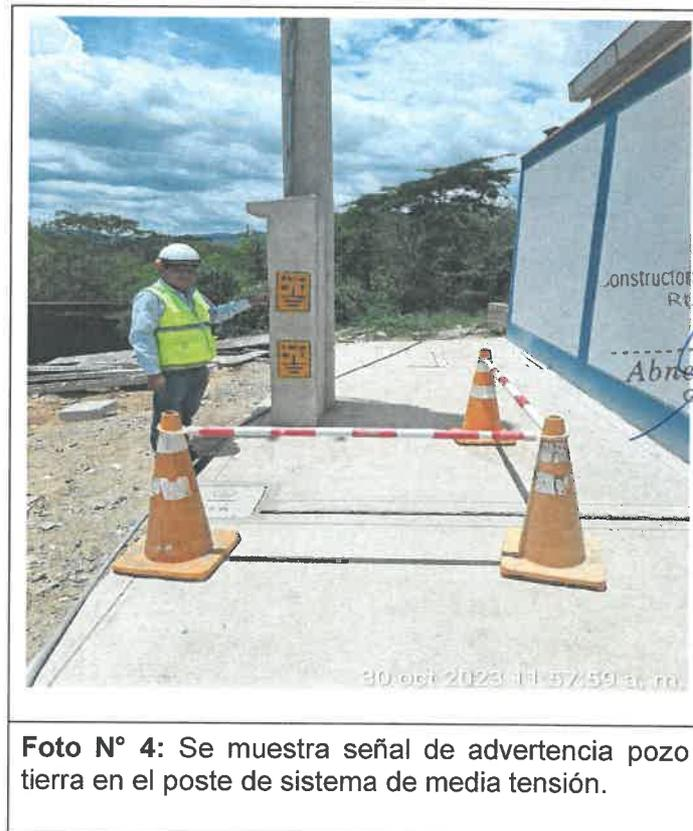
Foto N° 4: Se muestra señal de advertencia pozo tierra en el poste de sistema de media tensión.
