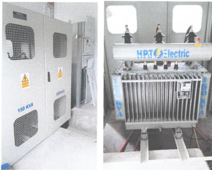
Foto N° 3 SUMINISTRO E INSTALACIÓN DE CELDAS Y TRANSFORMADOR DE 150 KVA
