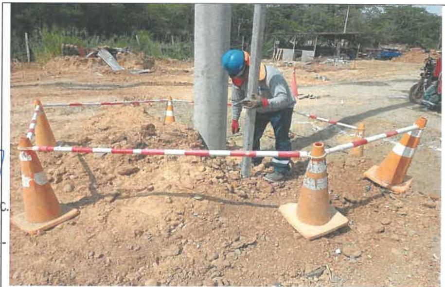
**Foto N° 3:** Se muestra delimitación con conos y barras en instalación de canaleta guarda cable en poste de media tensión.
