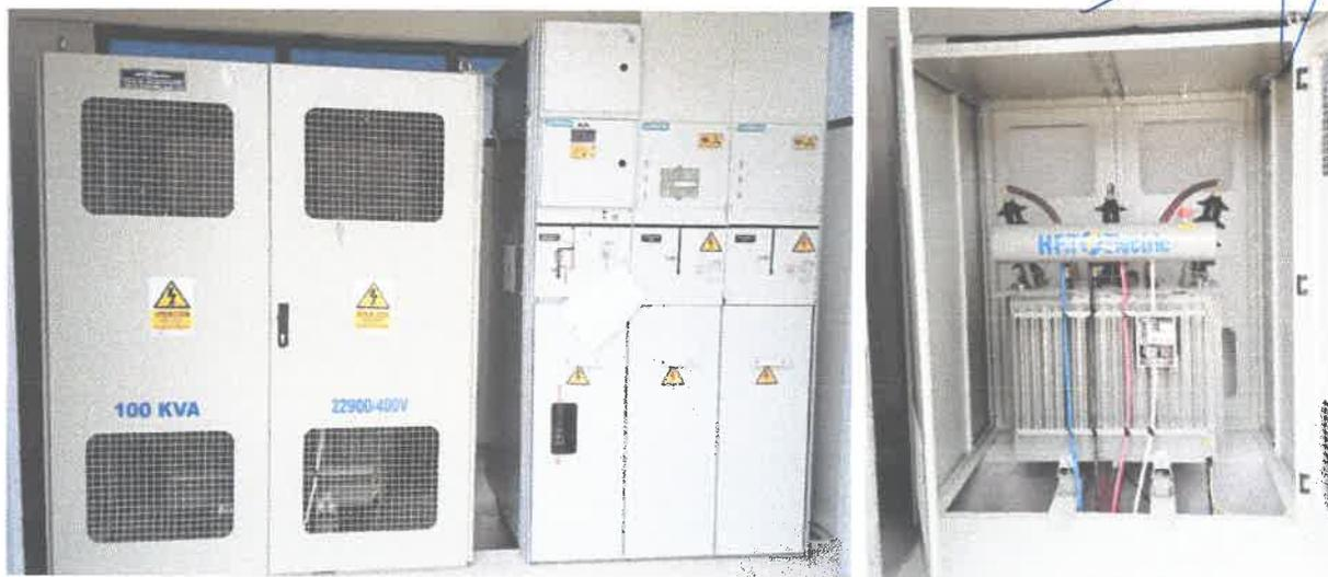
Foto N° 2 SUMINISTRO E INSTALACIÓN DE CELDAS Y TRANSFORMADOR DE 100 KVA
