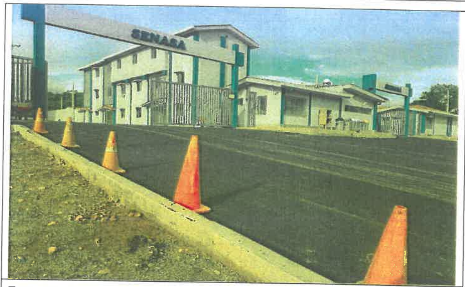
Foto N° 3: Se evidencia la instalación de conos de seguridad, para delimitación de la zona de trabajo.
