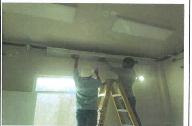
FOTOGRAFÍA 04: INSTALACION DE BANDEJAS DE SOPORTE DE TUBERÍAS DE COBRE REGRIFERATIVO PARA EL MÓDULO "K" EN LA SEDE DE VIGILANCIA Y MÓDULO "F" SEGUNDO Y TERCER PISO, EN ZONA DE TRATAMIENTO.
