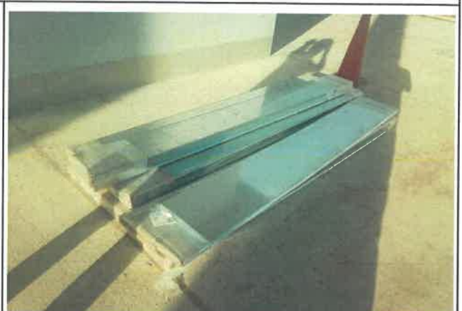
FOTOGRAFÍA 02: BANDEJAS DE SOPORTE DE TUBERÍAS DE COBRE REGRIFERATIVO PARA EL MÓDULO "K" EN LA SEDE DE VIGILANCIA Y MÓDULO "F" SEGUNDO Y TERCER PISO, EN ZONA DE TRATAMIENTO.
