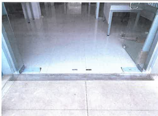
FOTOGRAFÍA 01: CONFORMACIÓN DE LAS BASE DE LAS CANALETAS PLUVIALES DE LOS INGRESOS DE LAS PUERTAS PRINCIPALES, ACABADO TIPO "MEDIA CAÑA".
