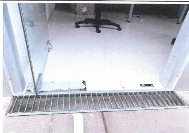
FOTOGRAFÍA 02: SUMINISTRO Y COLOCACIÓN DE REJILLAS METÁLICAS PARA LAS CANALETAS PLUVIALES DE LOS INGRESOS DE LAS PUERTAS PRINCIPALES DE LA SEDE DE VIGILANCIA.
