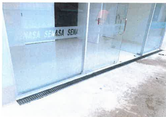
FOTOGRAFÍA 03: SUMINISTRO Y COLOCACIÓN DE REJILLAS METÁLICAS PARA LAS CANALETAS PLUVIALES DE LOS INGRESOS DE LAS PUERTAS PRINCIPALES DE LA SEDE DE VIGILANCIA.
