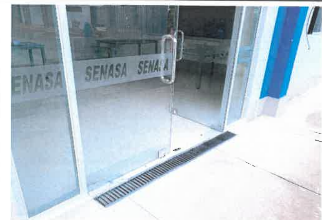
FOTOGRAFÍA 04: SUMINISTRO Y COLOCACIÓN DE REJILLAS METÁLICAS PARA LAS CANALETAS PLUVIALES DE LOS INGRESOS DE LAS PUERTAS PRINCIPALES DE LA ZONA DE TRATAMIENTO.
