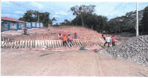
**FOTOGRAFÍA 07:** ENCOFRADO DEL SARDINEL REFORZADO, MARGEN DERECHA DE LA RAMPA DE INGRESO VEHICULAR.
