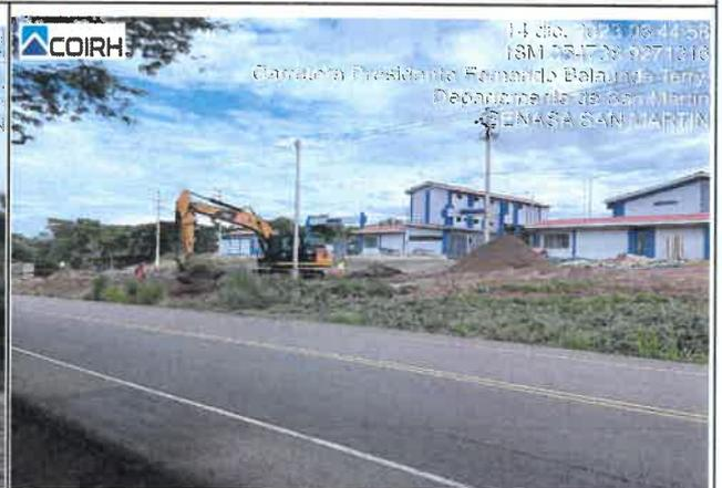
**FOTOGRAFÍA 02:** ELIMINACIÓN DE ARBOLES Y ARBUSTOS PARA LA CONSTRUCCIÓN DE LA RAMPA DE INGRESO VEHICULAR.
