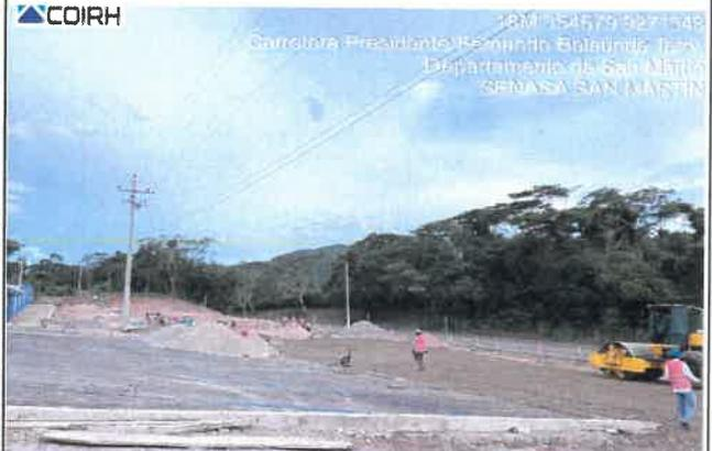
**FOTOGRAFÍA 06:** COLOCACION DE LA SUB BASE GRANULAR E=0.30 M CON EQUIPO EN LA RAMPA DE INGRESO VEHICULAR.
