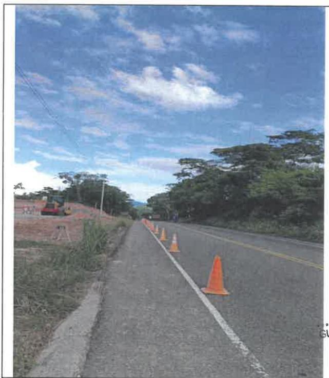
**Foto N° 3:** Se muestra la instalación de conos de seguridad, para delimitación de la zona de trabajo.
