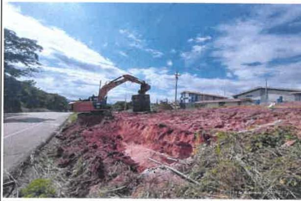
**FOTOGRAFÍA 05:** EXCAVACIÓN MASIVA CON EXCAVADORA.
