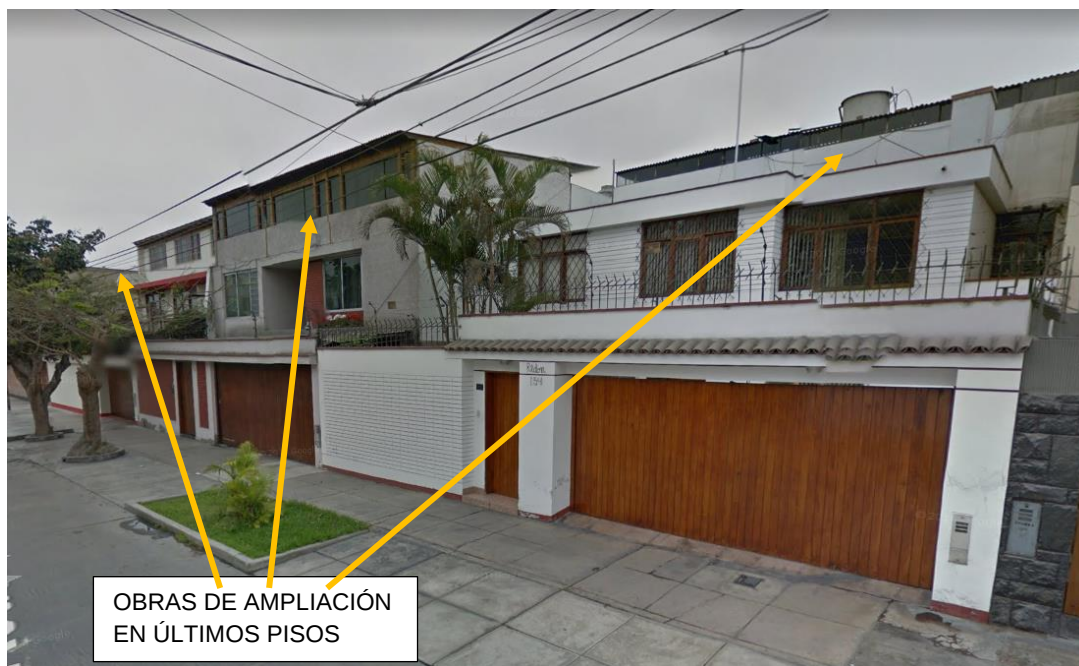
Imagen No. 3.21 Obras de ampliación en últimos pisos
