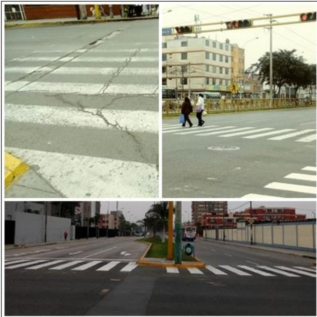
**Imagen Nº 4.21 – Estado de Conservación de la Superficie de Rodadura, Señalización horizontal y vertical de la Av. Canadá alt. Av. Del Aire**
