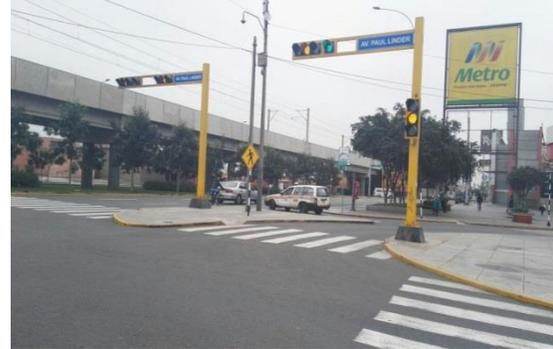
**Imagen N° 4.118 – Semáforo estructura cuadrada tipo pórtico: Av. Aviación / Av. Paul Linder**
