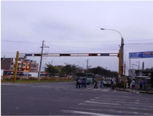
**Imagen N° 4.12 – Semáforo estructura cuadrada tipo pórtico: Av. Aviación / Av. Canadá**
