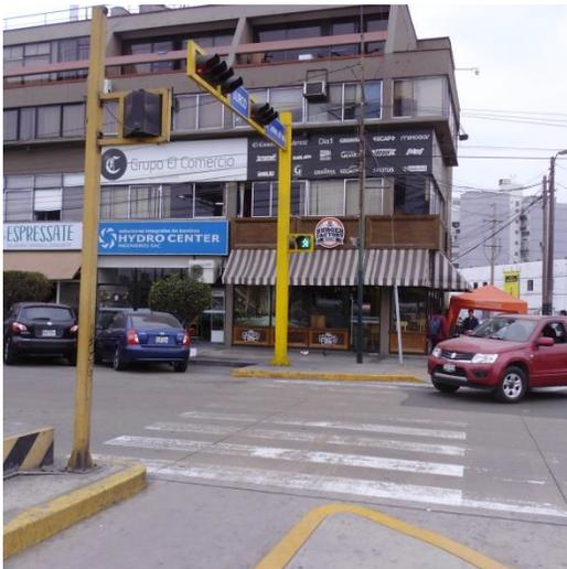
**Imagen N° 4.49 – Semáforo estructura cuadrada tipo pórtico: Av. Angamos / Av. San Luis**
