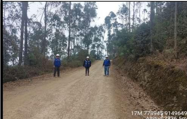
MANTENIMIENTO PERIÓDICO DE LA CARRETERA RUTA LI-111, TRAMO: HUARANCHAL - LUCMA
