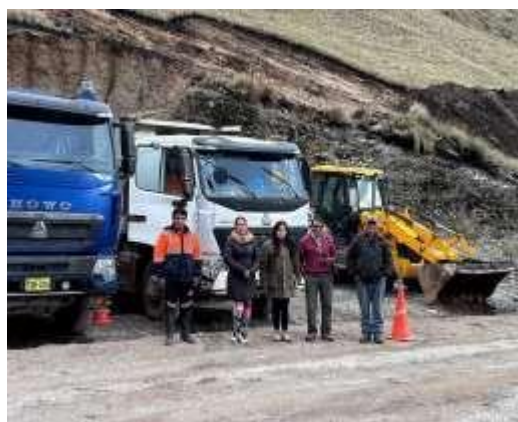
Consejera Regional por la provincia de Bolívar, Nancy Rosario Puitiza Gariza fiscalizando la Obra: Puente Calemar – Acra Naranjillo
