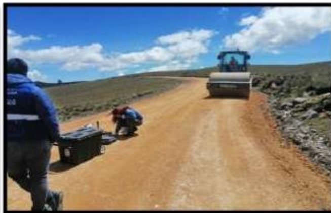
MANTENIMIENTO PERIÓDICO DE LA CARRETERA RUTA LI-115, TRAMO: EMP. PE-3N (QUESQUENDA) - COÑACHUGO - TRES RÍOS - DV. CULICANDA - ALTO DE TAMBORAS - PAMPA EL CÓNDOR
