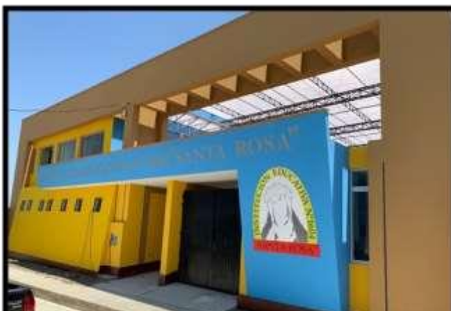
MEJORAMIENTO DEL SERVICIO DE EDUCACION DEL NIVEL INICIAL DE LA I.E. N° 1604 DEL CENTRO POBLADO SANTA ROSA, DISTRITO DE PUEBLO NUEVO, PROVINCIA DE CHEPEN - REGION LA LIBERTAD
