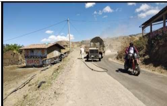
MANTENIMIENTO PERIÓDICO DE LA CARRETERA RUTA N° LI-120, TRAMO: JULCAN - LAS PLAYAS - CAPILLAS - SAN ANTONIO DE IPASHGON - SICCHAL - EMP. LI-121 (DV. JULCÁN)
