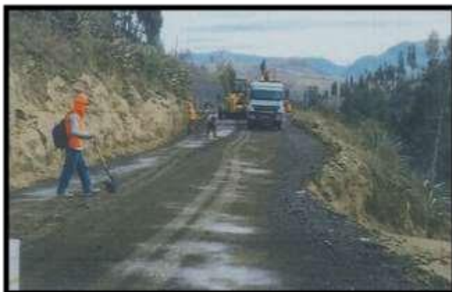
MANTENIMIENTO PERIÓDICO DE LA CARRETERA RUTA LI-114, TRAMO: OTUZCO - PTE. CARATA - DV. CHARAT - SAHUACHIQUE - USQUIL - EMP. LI-111 (COYUCHUGO)
