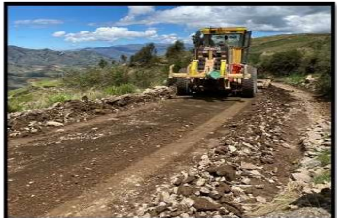
CONTRATACIÓN DEL SERVICIO: "MANTENIMIENTO PERIODICO DE LA CARRETERA DEPARTAMENTAL RUTA LI-119, TRAMO: EMP. PE-1N (PTE. HILDEMEISTER) - SAN IDELFONSO - EL INGENIO - TOMABAL -JUYACUL - CARABAMBA - MULLAMANDAY - MACHE - EMP. LI-120 (CHINCHANGO) (KM: 88+111)".
