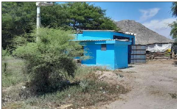
Imagen N° 114: Vista externa del Pozo 01 – Localidad Zaña
