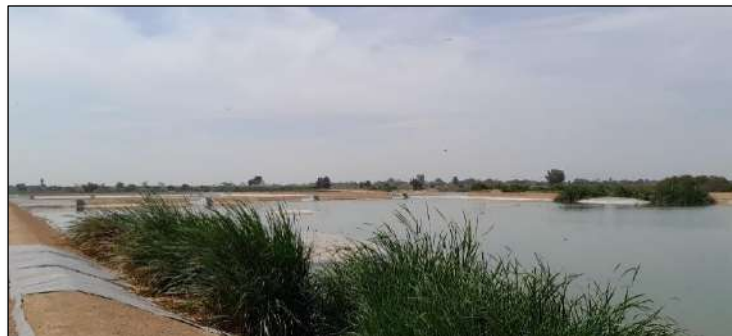
Imagen N° 154: Planta de tratamiento de aguas residuales – Localidad Ferreñafe
