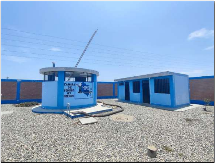
Imagen N° 49: Vista externa de la EBAR N°01-Localidad Mochumí
