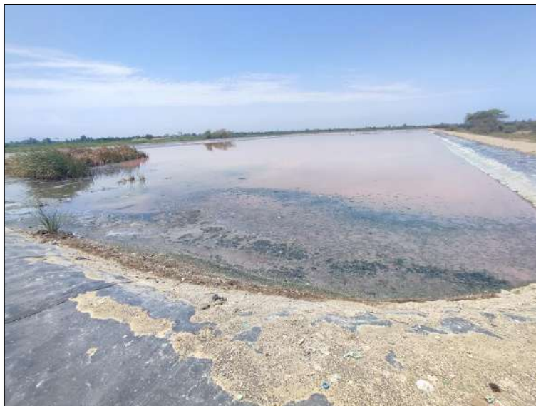
Imagen N° 88: Vista de la PTAR N° 2 – Localidad Túcume
