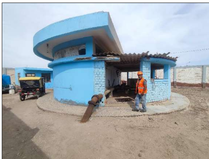
Imagen N° 134: Vista externa EBAR 01 – Localidad Santa Rosa
