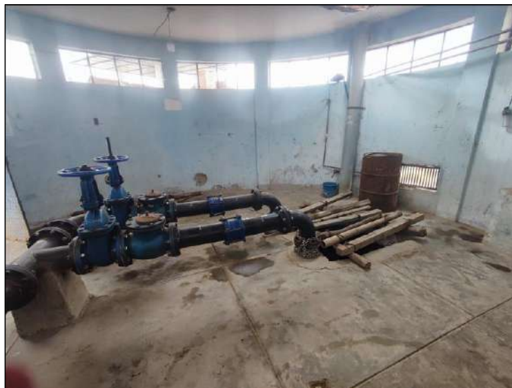
Imagen N° 34: Vista interna de la EBAR N°01-Localidad Íllimo
