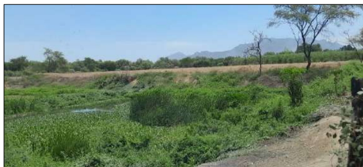
Imagen N° 170: Planta de tratamiento de aguas residuales – Localidad Batangrande
