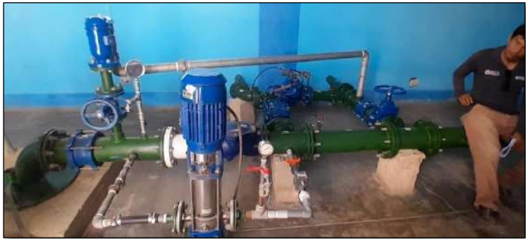
Imagen N° 150: Vista interna del Pozo 05 – Localidad Ferreñafe
