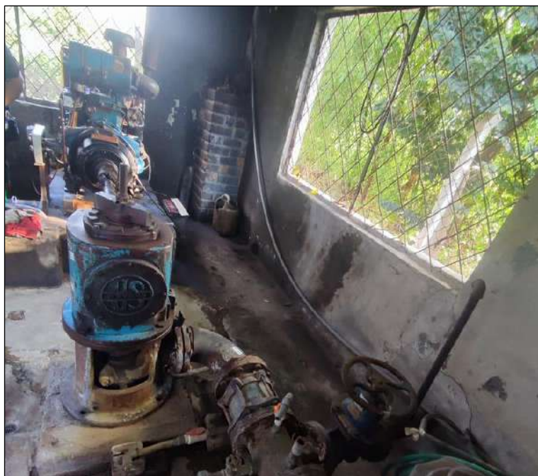
Imagen N° 77: Vista interna del pozo N° 1 -Localidad Salas
