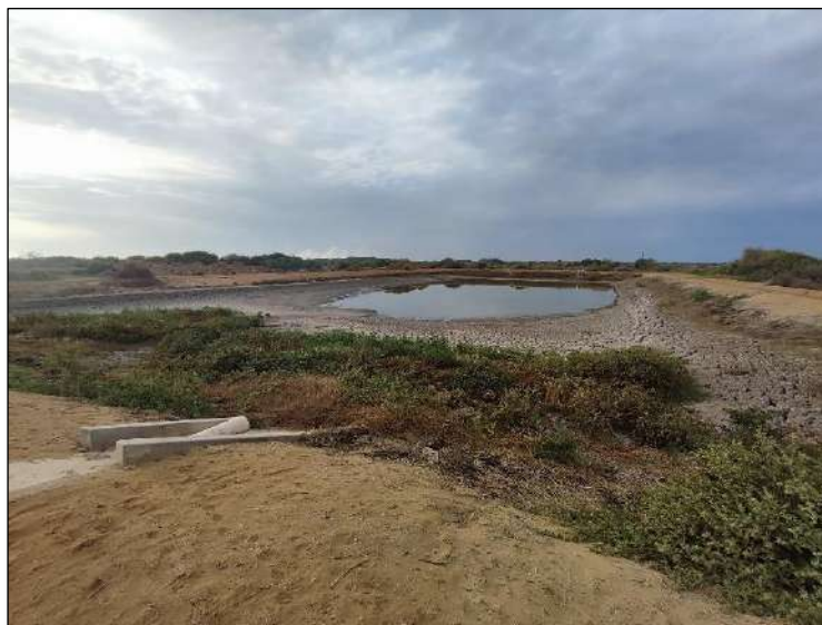
Imagen N° 94: Planta de tratamiento de aguas residuales – Ciudad Eten
