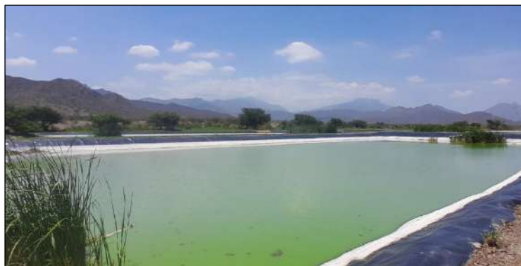
Imagen N° 129: Planta de tratamiento de aguas residuales – Localidad Nueva Arica
