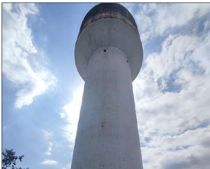
Imagen N° 54: Vista del R-1-Localidad Motupe
