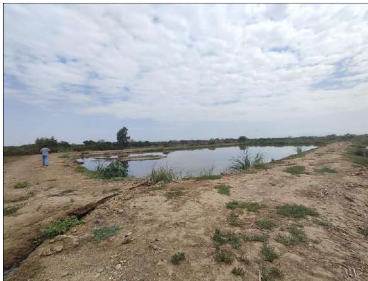
Imagen N° 35: Vista de la PTAR N°01- Localidad Íllimo
