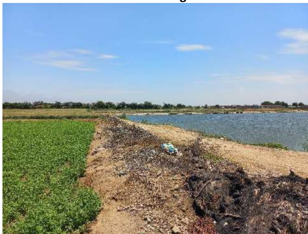
Imagen N° 11: Planta de Tratamiento de aguas residuales-Localidad Pimentel
