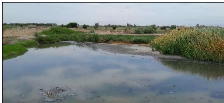
Imagen N° 160: Planta de tratamiento de aguas residuales – localidad Picsi
