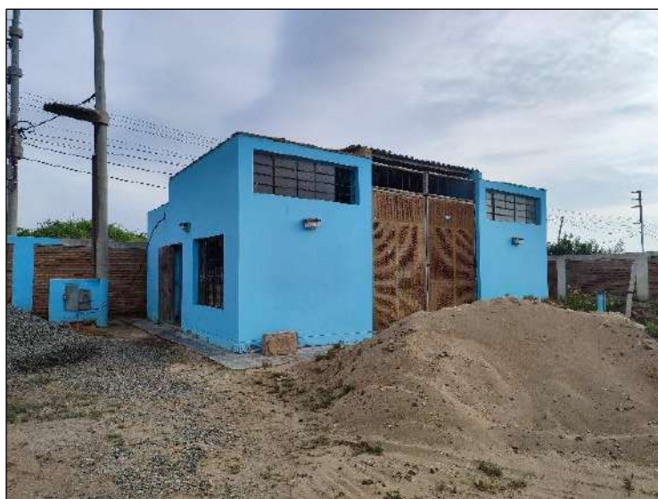
Imagen N° 131: Vista externa del Pozo 01 – Localidad Santa Rosa
