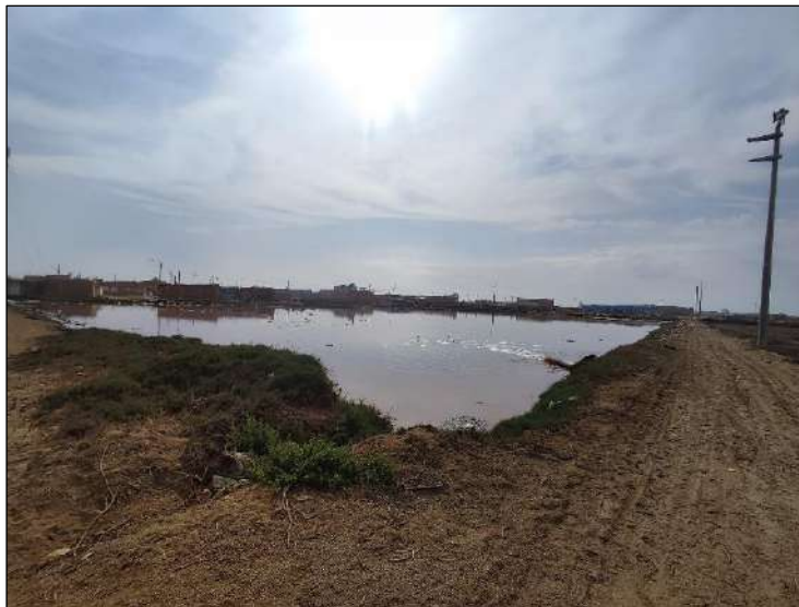
Imagen N° 135: Planta de tratamiento de aguas residuales – Localidad Santa Rosa
