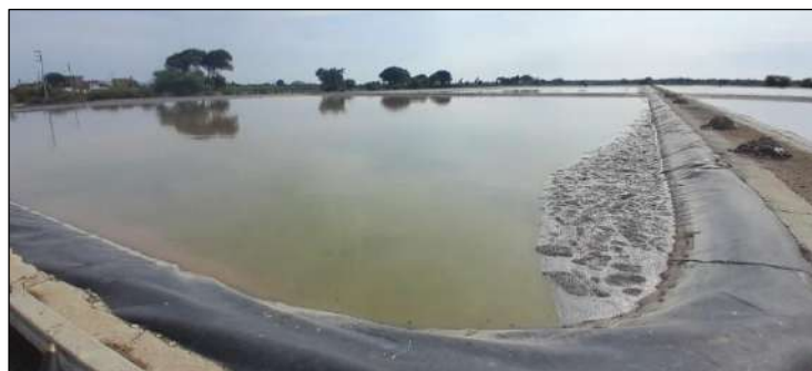
Imagen N° 144: Planta de tratamiento de aguas residuales – Localidad Reque
