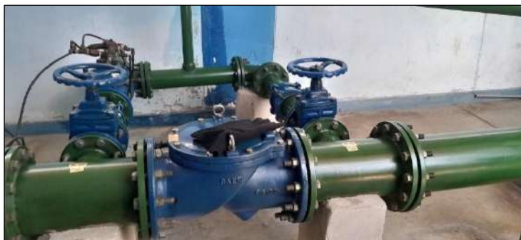
Imagen N° 146: Vista interna Pozo 01 – Localidad Ferreñafe
