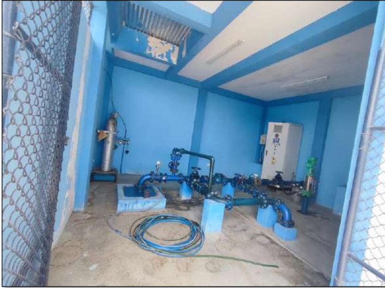
Imagen N° 46: Vista interna del pozo N° 4-Localidad Mochumí
