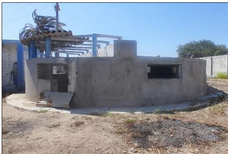
Imagen N° 118: Vista del EBAR 01 – Localidad Zaña
