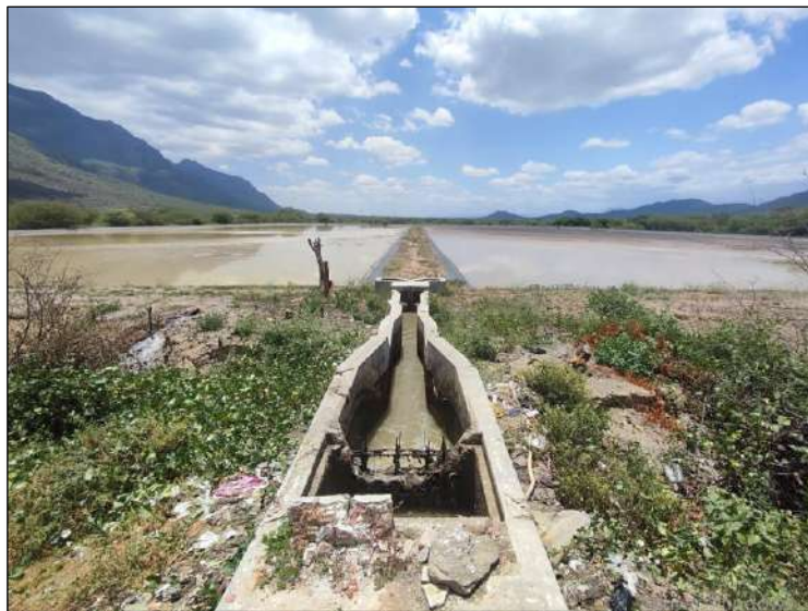
Imagen N° 65: Vista de la PTAR N° 1 – Localidad Olmos
