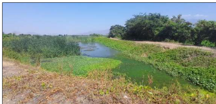
Imagen N° 124: Planta de tratamiento de aguas residuales – Oyotún
