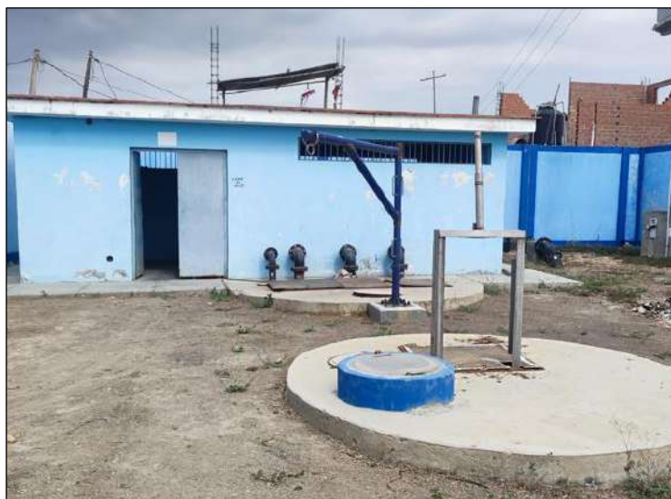
Imagen N° 41: Vista externa de la EBAR N°02-Localidad Jayanca
