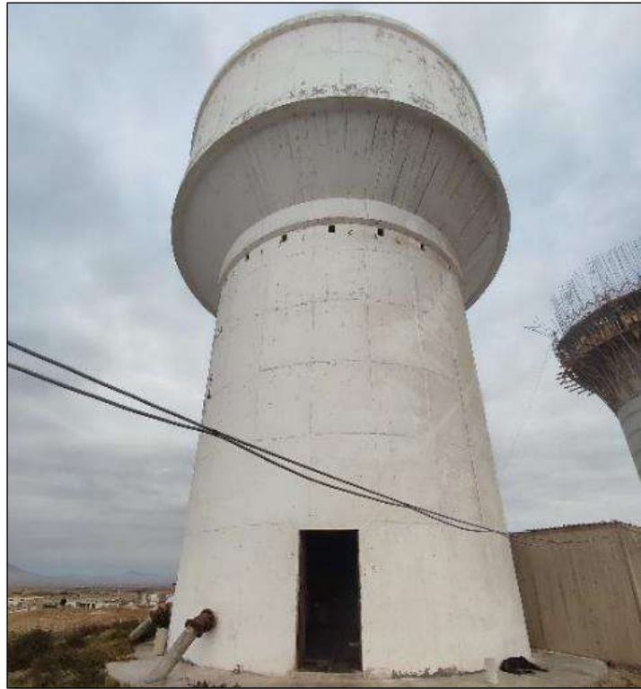
Imagen N° 97: Vista del reservorio R-01 – Localidad Puerto Eten
