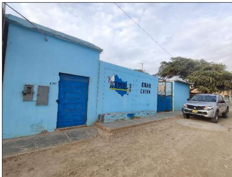
Imagen N° 93: Vista externa de la EBAR 01 – Ciudad Eten
