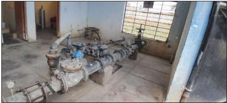
Imagen N° 156: Vista interna del Pozo 02 – Localidad Picsi
