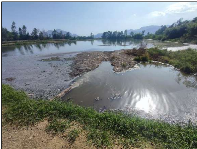
Imagen N° 58: Vista de la PTAR N° 1 – Localidad Motupe
