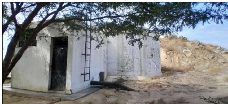
Imagen N° 163: Vista externa Reservorio R-01 – Localidad Pósope Alto
