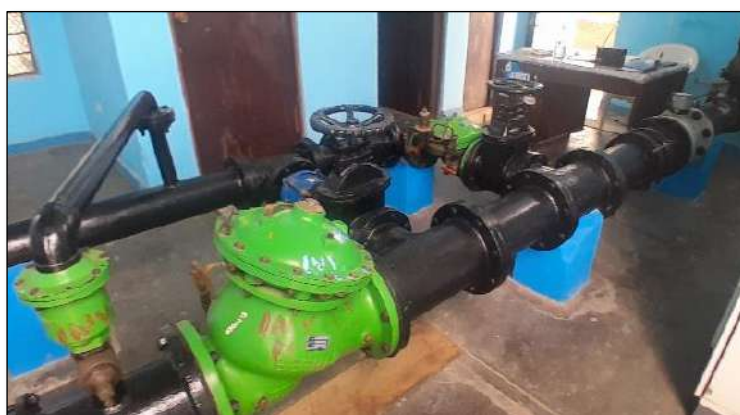
Imagen N° 102: Vista interna Pozo 03 – Localidad Monsefú
