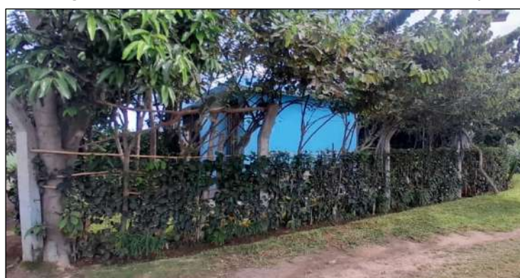
Imagen N° 138: Vista externa Pozo 03 – Localidad Reque
