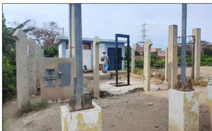
Imagen N° 142: Vista externa del EBAR 02 (Villa El Sol) – Localidad Reque
