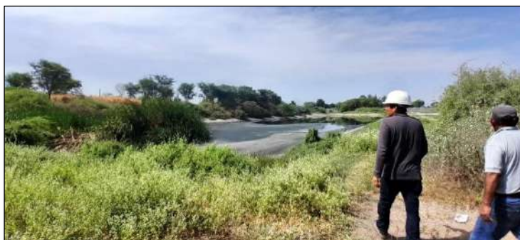
Imagen N° 165: Planta de tratamiento de aguas residuales – Localidad Pósope Alto
