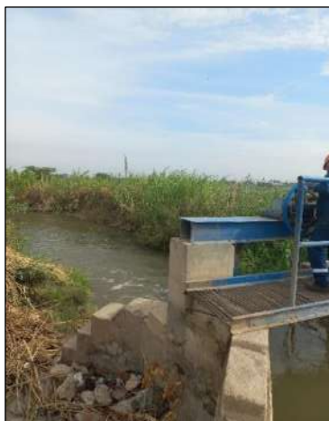
Imagen N° 3: Bocatoma “Bola de Oro” - Localidad Chiclayo
