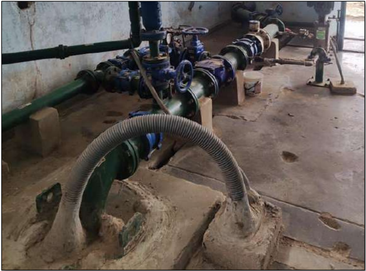
Imagen N° 30: Vista interna del pozo N° 2-Localidad Íllimo
