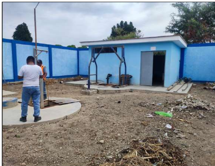
Imagen N° 42: Vista externa de la EBAR N°03-Localidad Jayanca
