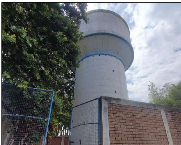
Imagen N° 55: Vista del R-2-Localidad Motupe
