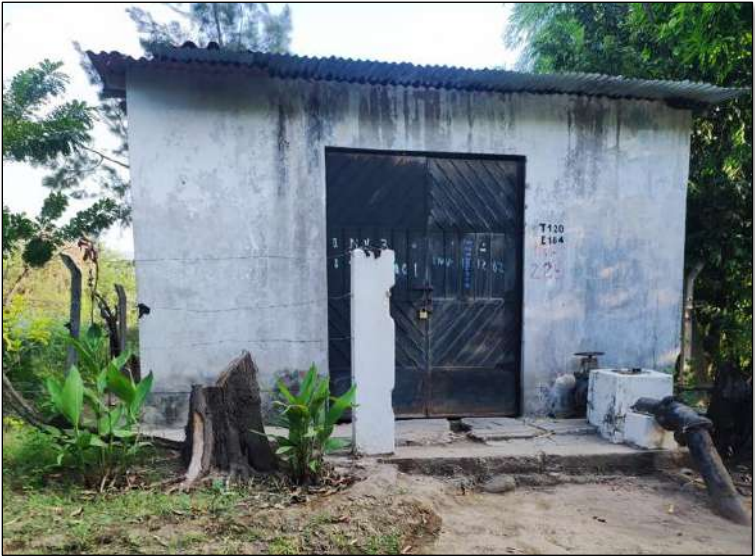
Imagen N° 76: Vista externa del pozo N° 1-Localidad Salas
