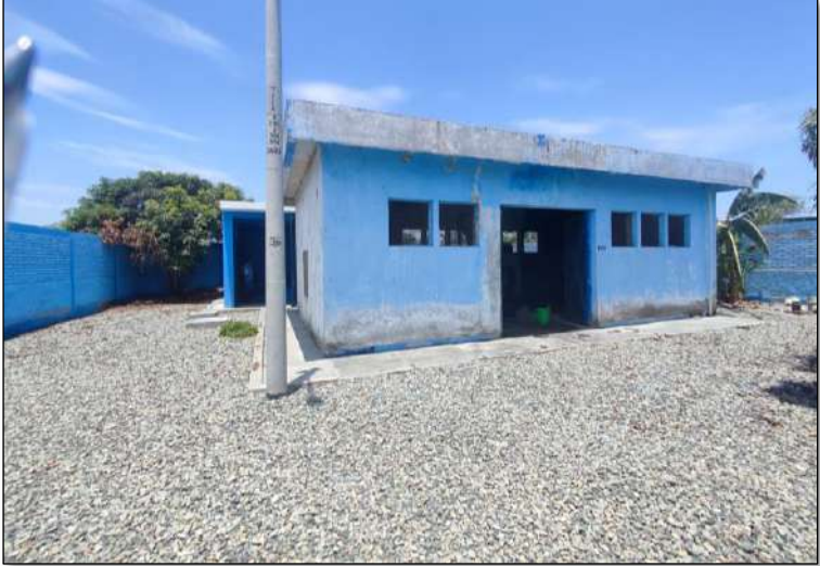
Imagen N° 45: Vista externa del pozo N° 4-Localidad Mochumí
