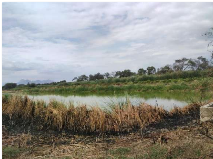
Imagen N° 43: Vista de la PTAR N°01-Localidad Jayanca
