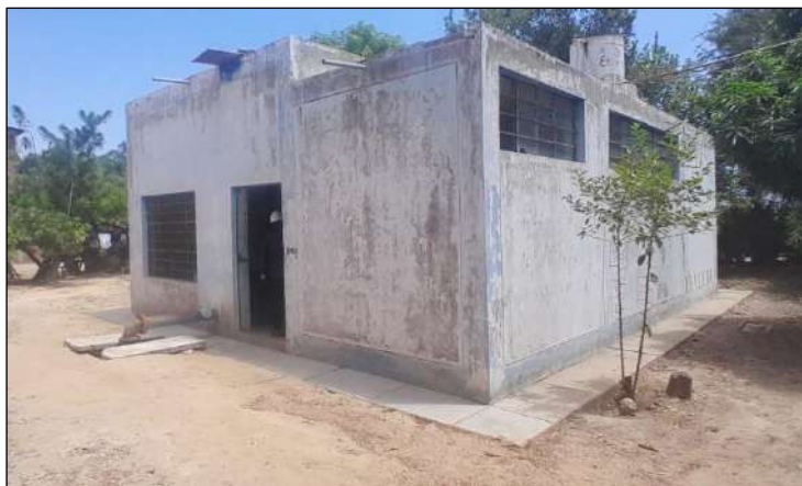
Imagen N° 167: Vista externa del Pozo 02 – Localidad Batangrande
