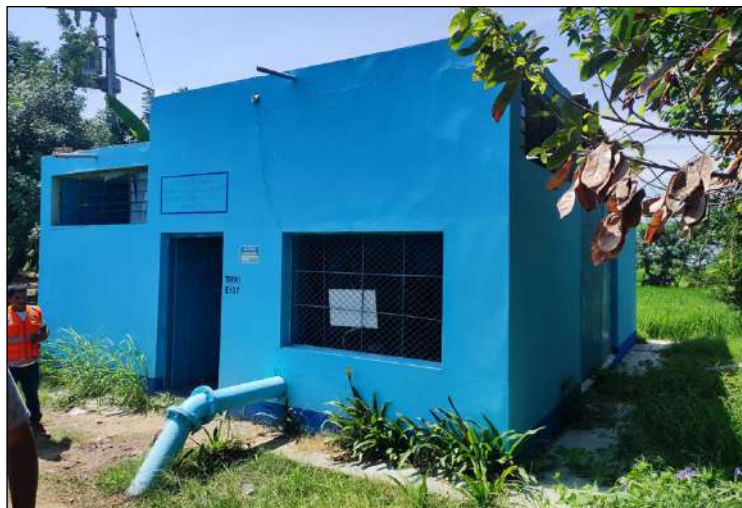
Imagen N° 82: Vista externa del pozo N° 2-Localidad Túcume
