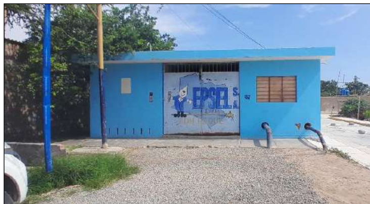
Imagen N° 137: Vista externa Pozo 02 – Localidad Reque
