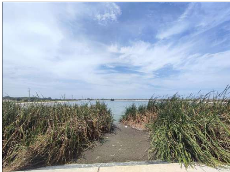
Imagen N° 27: Vista de la PTAR N°02 – Localidad de Lambayeque
