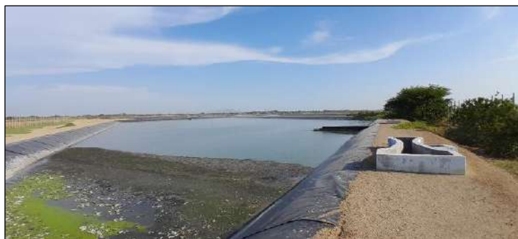
Imagen N° 112: Planta de tratamiento de aguas residuales – Localidad Mocupe
