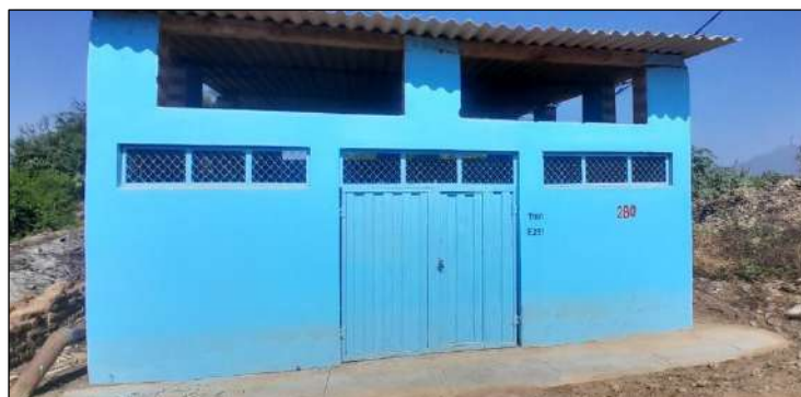
Imagen N° 123: Vista del EBAR 01 – Localidad Oytún
