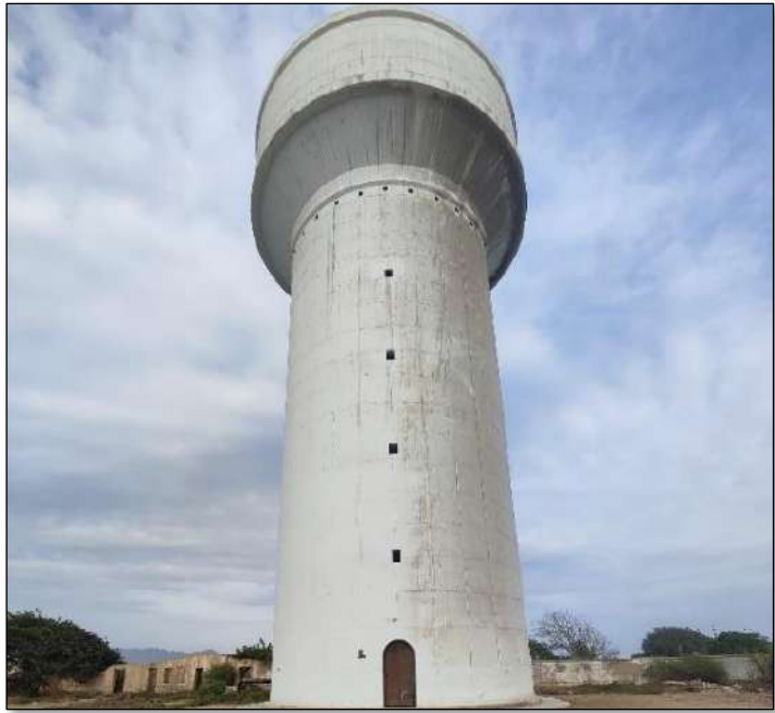
Imagen N° 91: Vista del reservorio R-02 – Localidad Ciudad Eten
