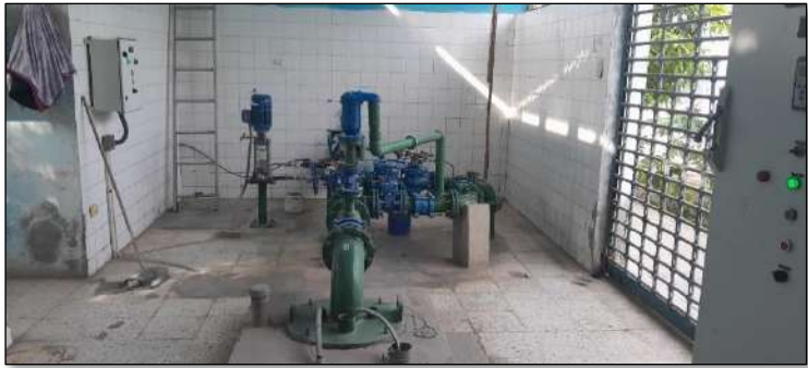
Imagen N° 149: Vista interna del Pozo 04 – Localidad Ferreñafe
