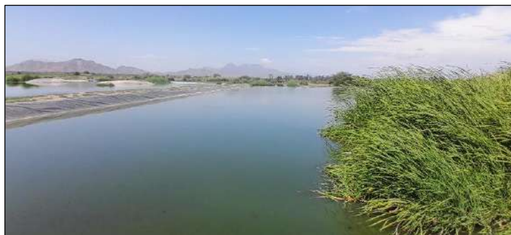
Imagen N° 119: Planta de tratamiento de aguas residuales – Localidad Zaña
