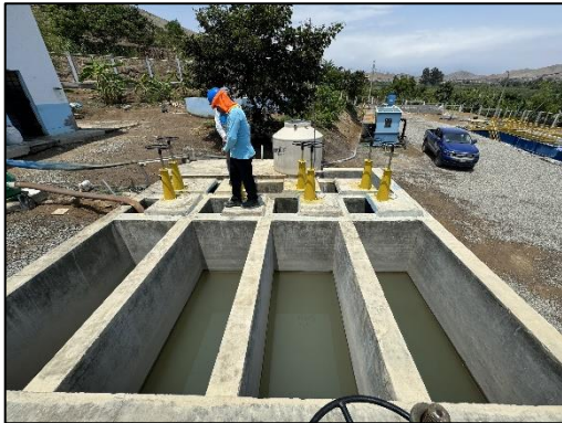
PTAP Túnel Grande – convencional
