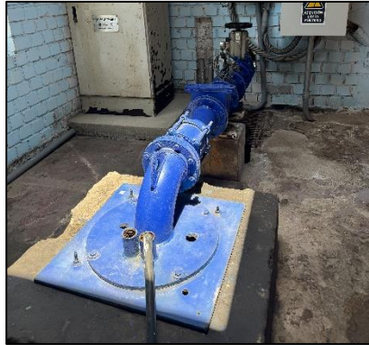
Imagen N° 17: Pozo de captación - San Antonio
