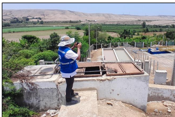
Captación Túnel Grande
