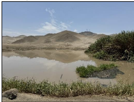
Imagen N° 33: PTAR - Cerro Azul
