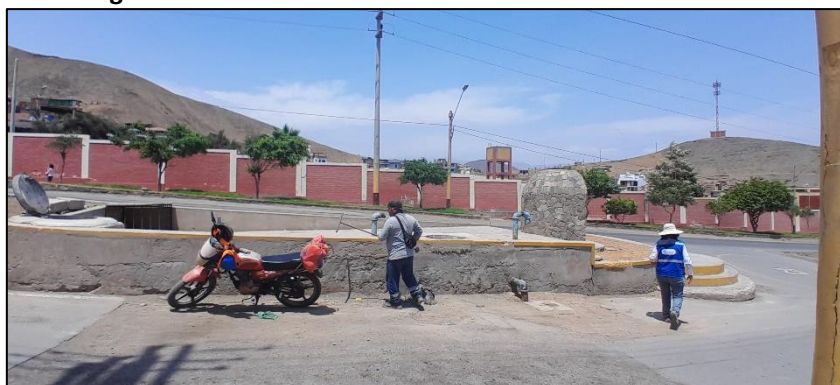
Imagen N° 19: Estación de Bombeo Villa Paraíso – San Antonio
