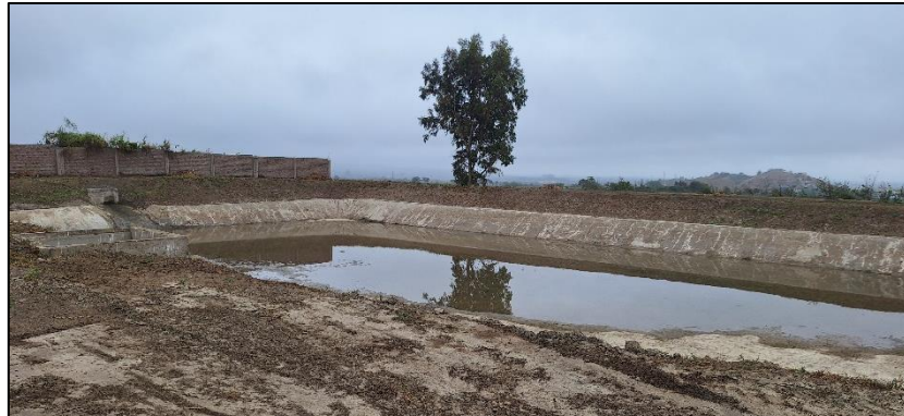
Imagen N° 7: Unidad de presedimentador - Imperial
