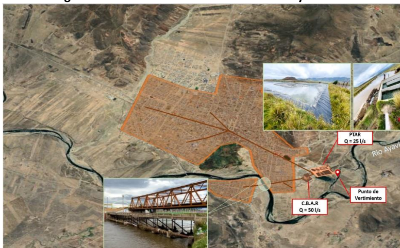
Imagen N° 20: Sistema de Alcantarillado de Ayaviri
