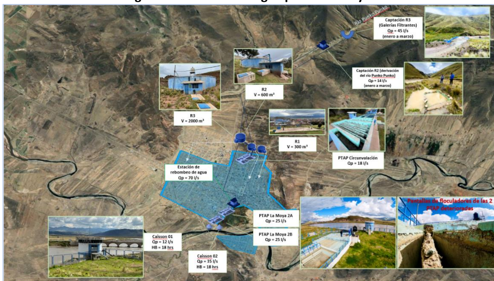
Imagen N° 9: Sistema de agua potable de Ayaviri
