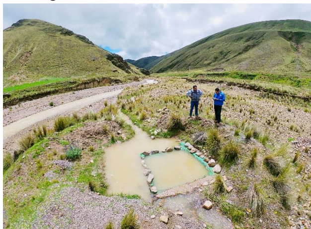
Imagen N° 15: Galería filtrante Punco Punco 2
