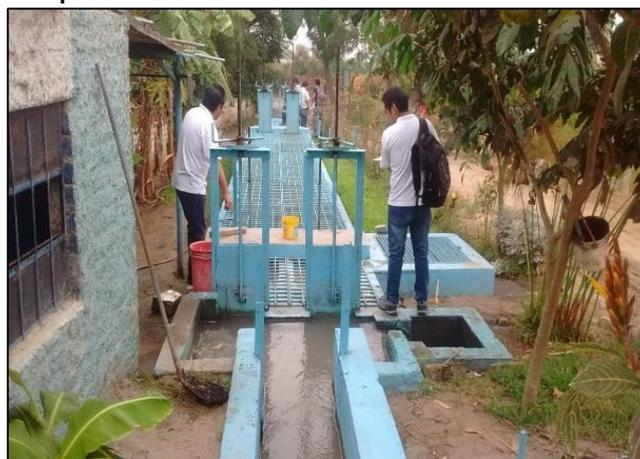
Captación con sobrecarga hidráulica
