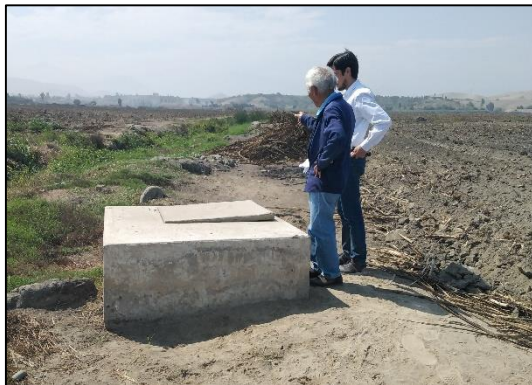
Imagen N° 59: Galería Filtrante Santa Rosa
