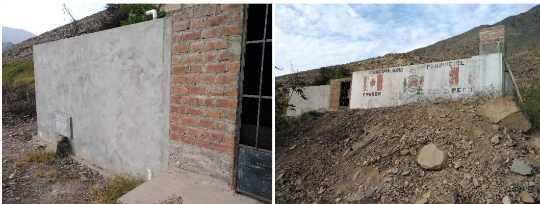
Imagen N° 77: Reservorio R-2 (izquierda) y R-1 (derecha)
