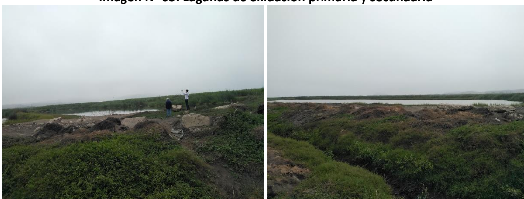
Imagen N° 63: Lagunas de oxidación primaria y secundaria
