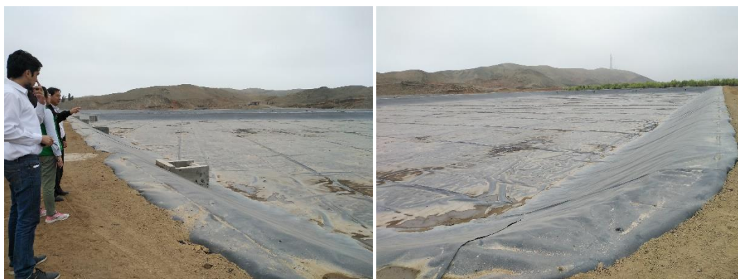
Imagen N° 70: Lagunas de Oxidación en construcción
