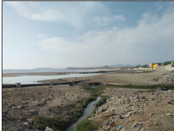
Imagen N° 45: Descarga de las aguas residuales sin tratamiento al mar
