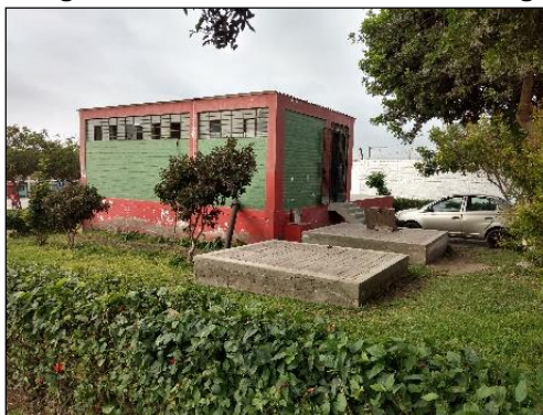
Imagen N° 43: Estación de bombeo de agua
