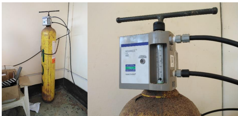
Imagen N° 61: Caseta de cloración
