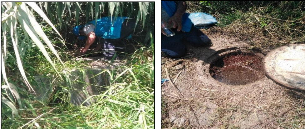
Imagen N° 8: Galería Vinto Buena Vista
