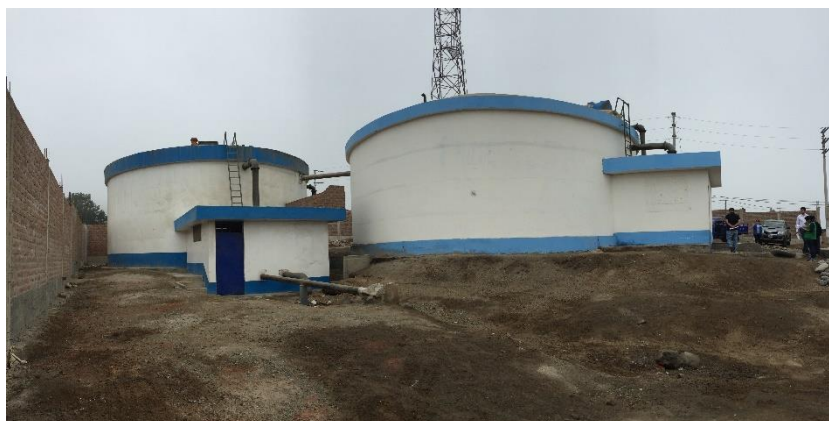
Imagen N° 67: Reservorios R-3 (izquierda) y R-2 (derecha)
