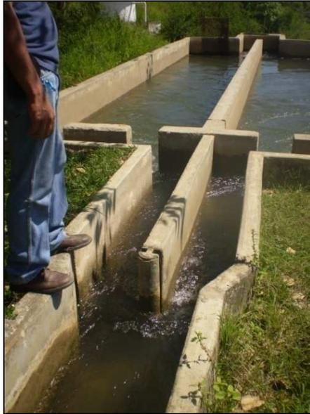
Cada desarenador está compuesto por una estructura de salida, que recolecta las aguas de rebose; y una tolva de acumulación de lodos. Esta última se drena periódicamente, mediante una compuerta tipo tarjeta, hacia el sistema de alcantarillado de la PTAP.
