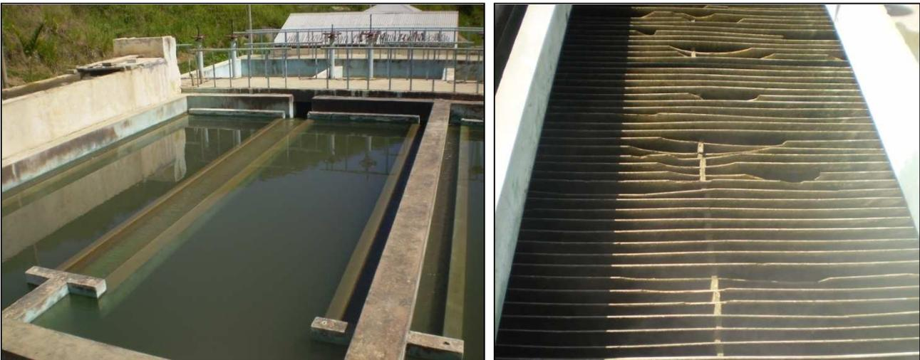
Se nota el deterioro de las placas de madera que componen el decantador.
