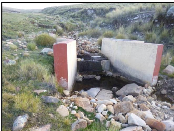
En la actualidad la captación es por gravedad, la diferencia de cotas permite conducir las aguas hasta la localidad de Santo Tomás, y abastecer de agua la zona baja y de la margen derecha del río Conde.
