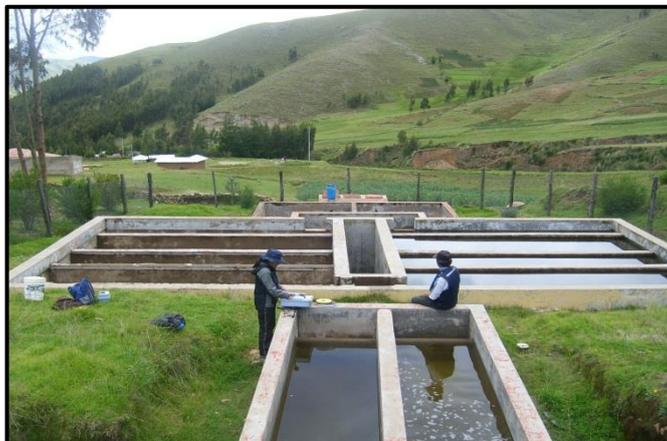
Actualmente la planta cuenta con grava seleccionada y lecho filtrante en una de las baterías de pre filtro y filtro lento se prevé adquirir en el año 2016. El material faltante.
