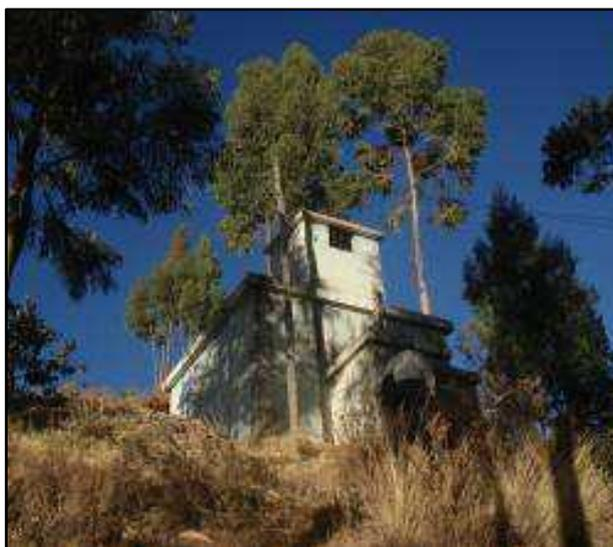
La estructura se encuentra sin protección ni señales que eviten el riesgo de contaminación de las aguas almacenadas, el estado y condiciones de funcionamiento son regulares.
