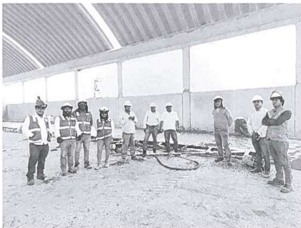
Imagen N.º 53: Se verifica el vaciado de concreto para las losas de concreto del piso del bloque N.º 16.
