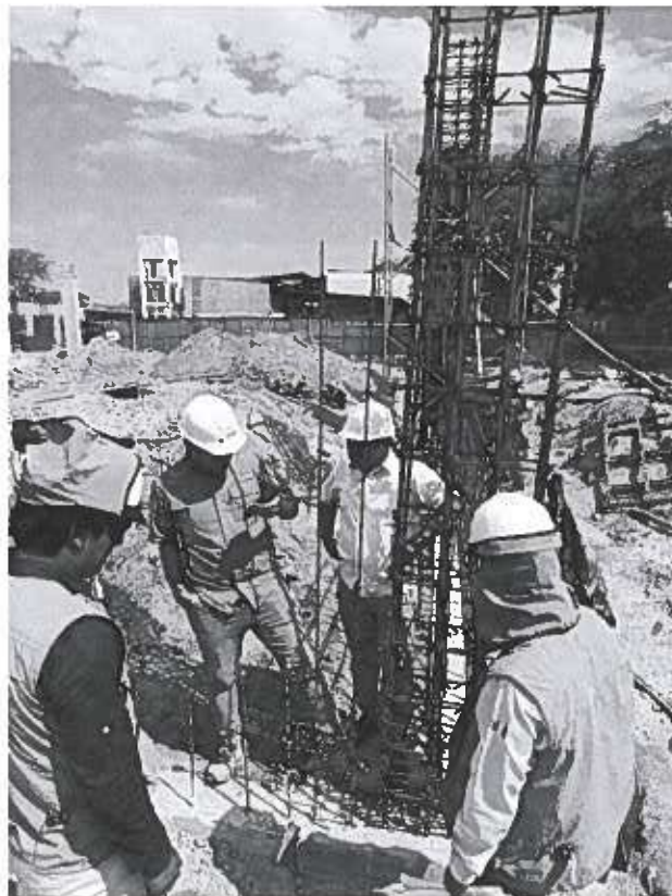
Imagen N.º 15: Se procedió a verificar el diámetro del acero de refuerzo y la distribución de estribos en las columnas del bloque N.º 15.
