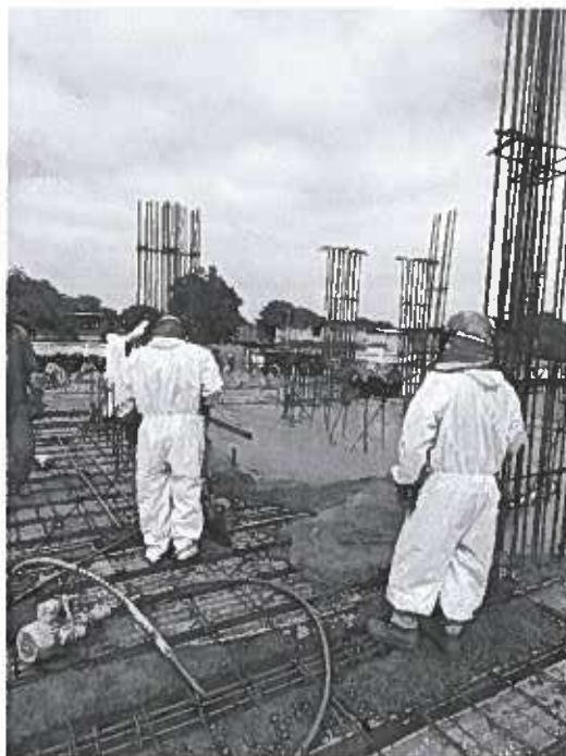
Imagen N.º 41: Se verifica el vaciado de concreto para la losa aligerada del bloque N.º 06.
