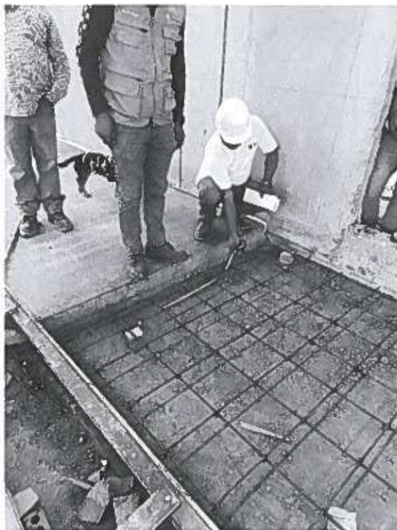
Imagen N.º 51: Se verifica el acero de refuerzo para las losas de concreto del piso en el bloque N.º 16.
