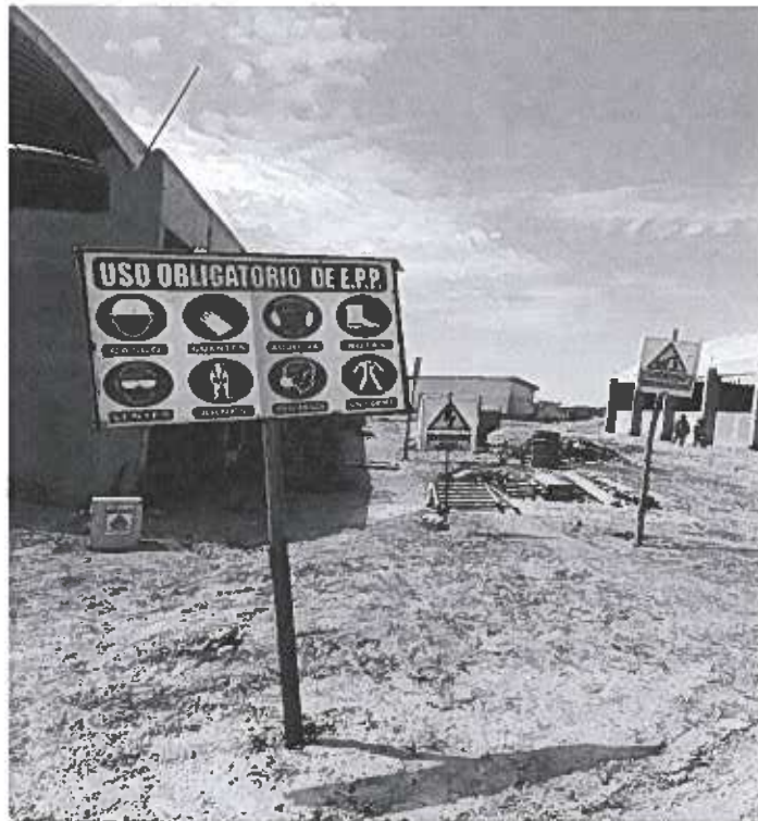
Imagen N.º 42: Señales informativas en la obra.
