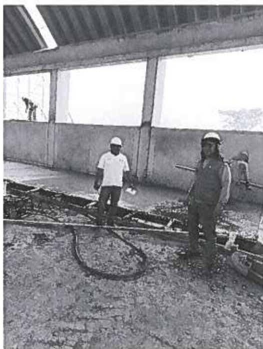
Imagen N.º 52: Se verifica el vaciado de concreto para las losas de concreto del piso del bloque N.º 16.
