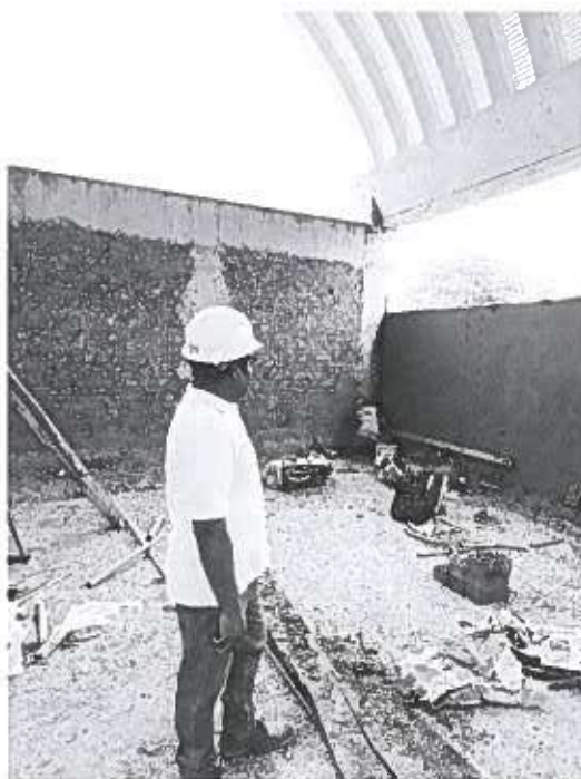
Imagen N.º 49: Se visualiza los trabajos de tarrajeo de muros y columnas en el bloque N.º 15.
