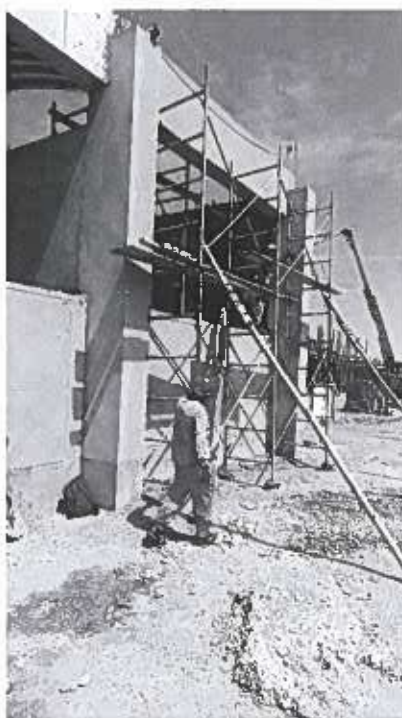
Imagen N.º 32: Se verifica los trabajos de tarrajeo de vigas y columnas en el bloque N.º 15.
