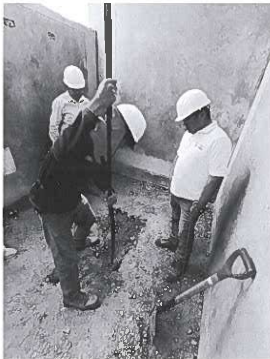
Imagen N.º 50: Se verifica el espesor de la capa de afirmado dentro del bloque N.º 15.
