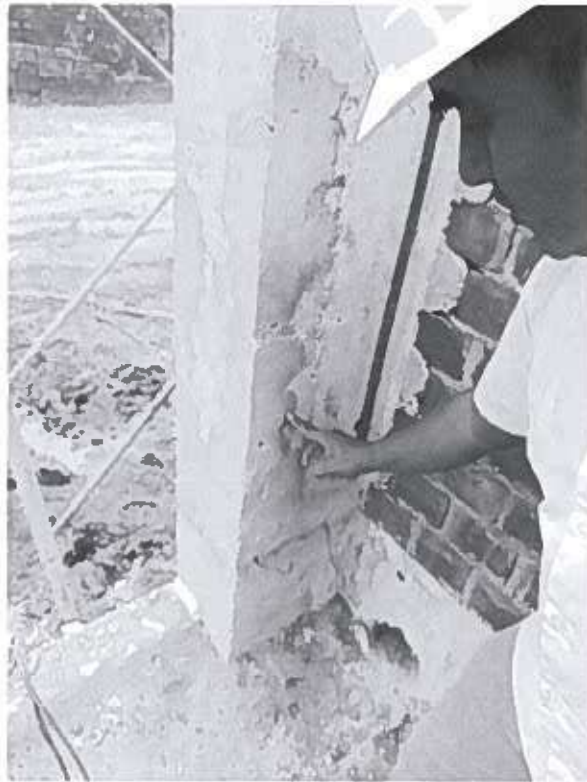
Imagen N.º 18: Visualizamos colocación de mortero en columna del bloque N.º 09.
