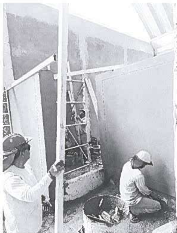
Imagen N.º 54: Tarrajeo de muros dentro del bloque N.º 15.
