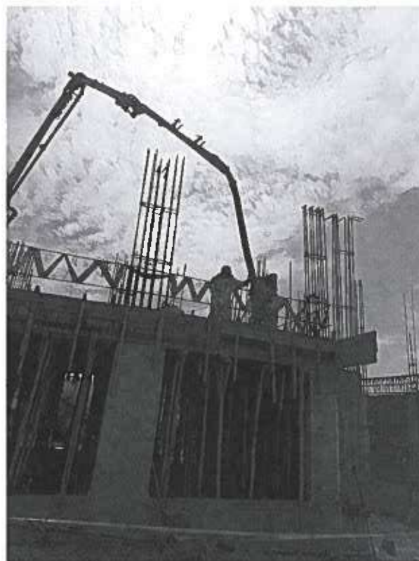
Imagen N.º 43: Vaciado de concreto premezclado con mixer.
