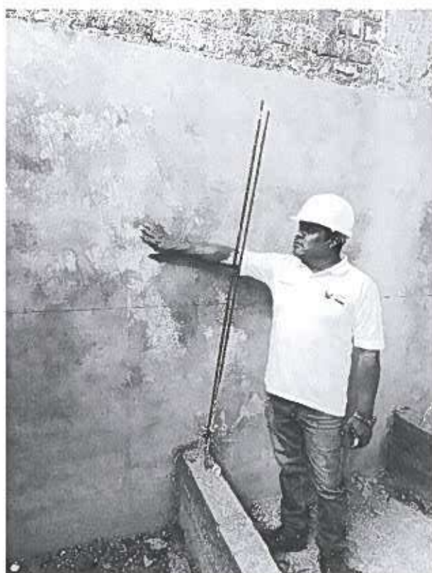
Imagen N.º 55: Se verifica los trabajos de Tarrajeo de muros dentro del bloque N.º
