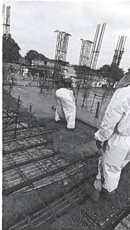
Imagen N.º 40: Se verifica el vaciado de concreto para la losa aligerada del bloque N.º 05.
