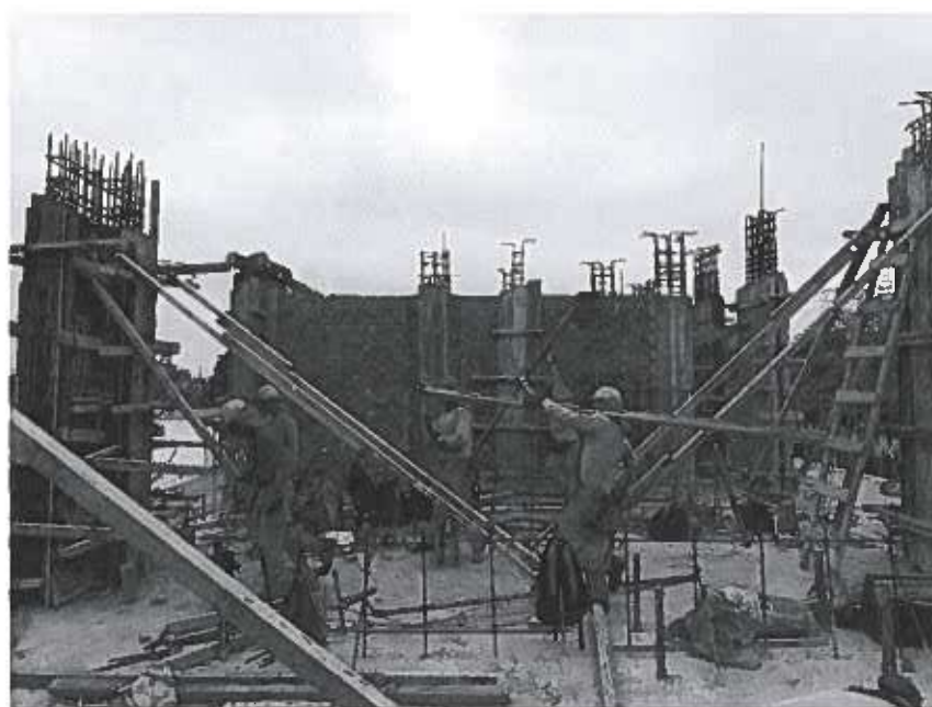
Imagen N.º 45: Se visualiza los trabajos de encofrado de las columnas del segundo nivel del bloque N.º 05.
