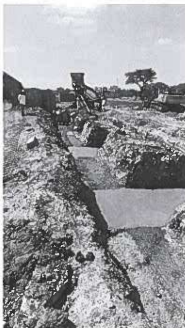
Imagen N.º 33: Se verifica el vaciado de concreto para el solado de las tribunas de la plataforma.
