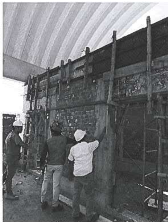
Imagen N.º 04: Se verifica el encofrado de vigas dentro del bloque N.º 15.
