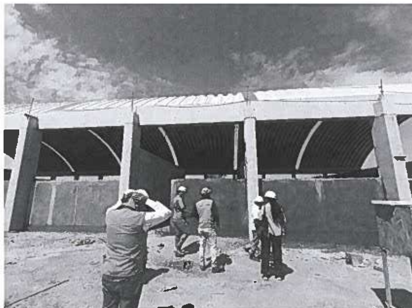
Imagen N.º 02: Se verifica los trabajos ejecutados en el bloque N.º 16.
