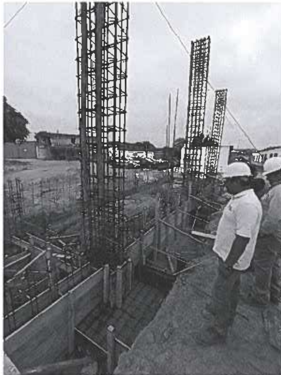
Imagen N.º 56: Se verifica el diámetro de acero y las dimensiones del sobrecimiento y columnas del bloque N.º 04.
