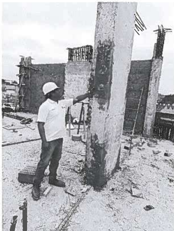
Imagen N.º 46: Se verifica la colocación de mortero en las columnas del segundo nivel del bloque N.º 06.
