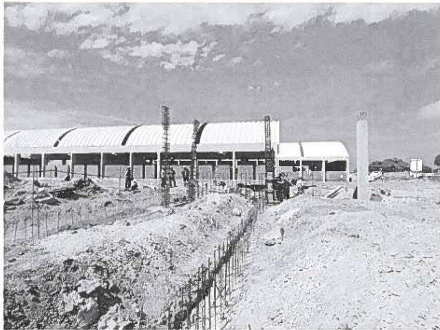
Imagen N.º 14: Se verifica el avance de los trabajos en el bloque N.º 15.
