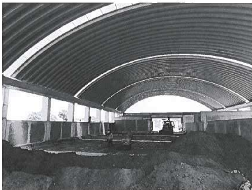
Imagen N.º 10: Se verifica el avance de los trabajos de compactación de material de relleno dentro del bloque N.º 16.
