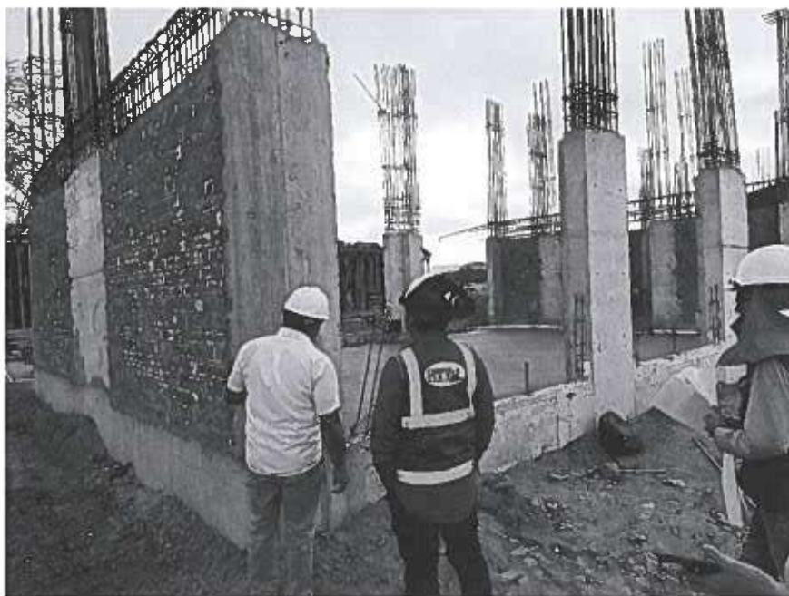
Imagen N.º 26: Se verifica los trabajos de vaciado de concreto para falso piso del bloque N.º 08.
