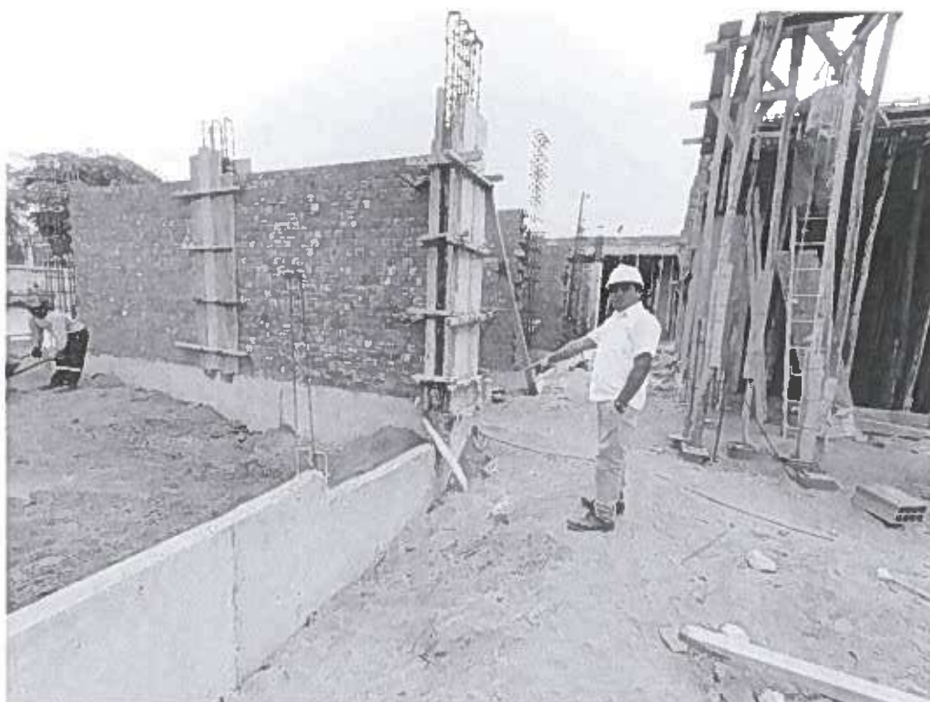
Imagen N.º 30: Se verifica la colocación de material de relleno dentro del bloque N.º 09.
