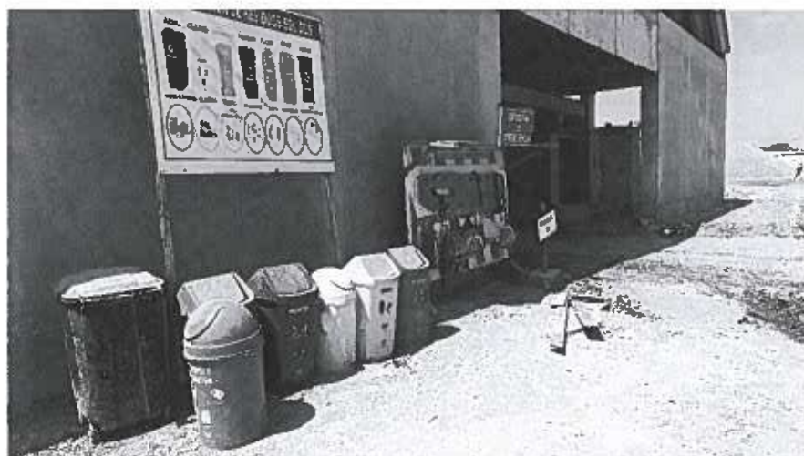
Imagen N.º 31: Se visualiza los tachos de residuos sólidos al lado de la estación de emergencia lo cual deberían estar alejados.
