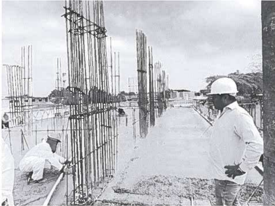
Imagen N.º 38: Se verifica el vaciado de concreto para la losa aligerada del bloque N.º 05.
