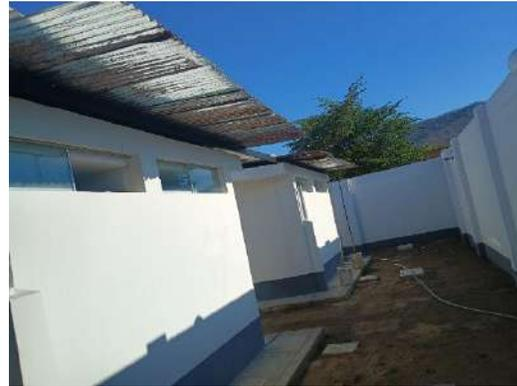
Techo oxidado, sin Sistema de drenaje pluvial y en el piso no existe sembrado de grass
