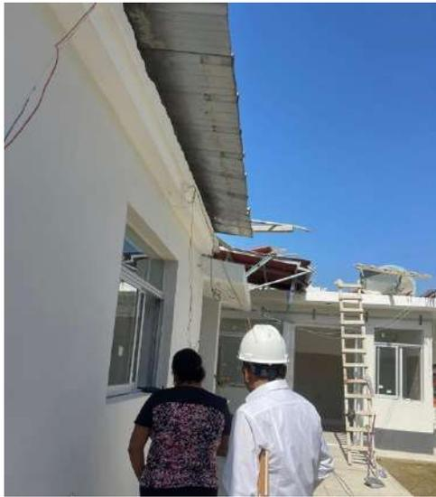
Techo sin cobertura metálica, sin sistema de drenaje pluvial y en el piso no existe grass.
