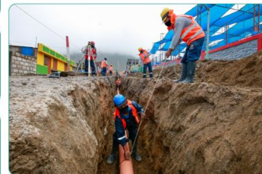
Ejecución de obras de alcantarillado
