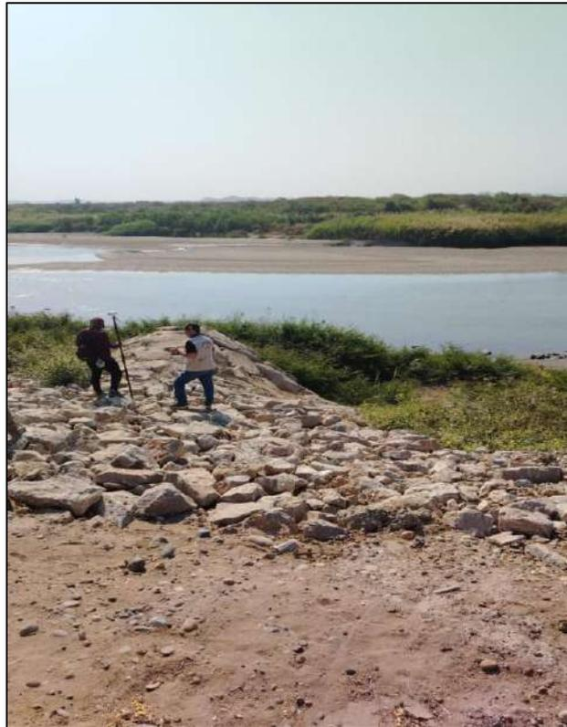
**Foto 8:** se verifica que el espigón 5 se encuentra en la progresiva 7+760 pero con una longitud de 11.72 mts y con su ancho de corona de 1 mt.
