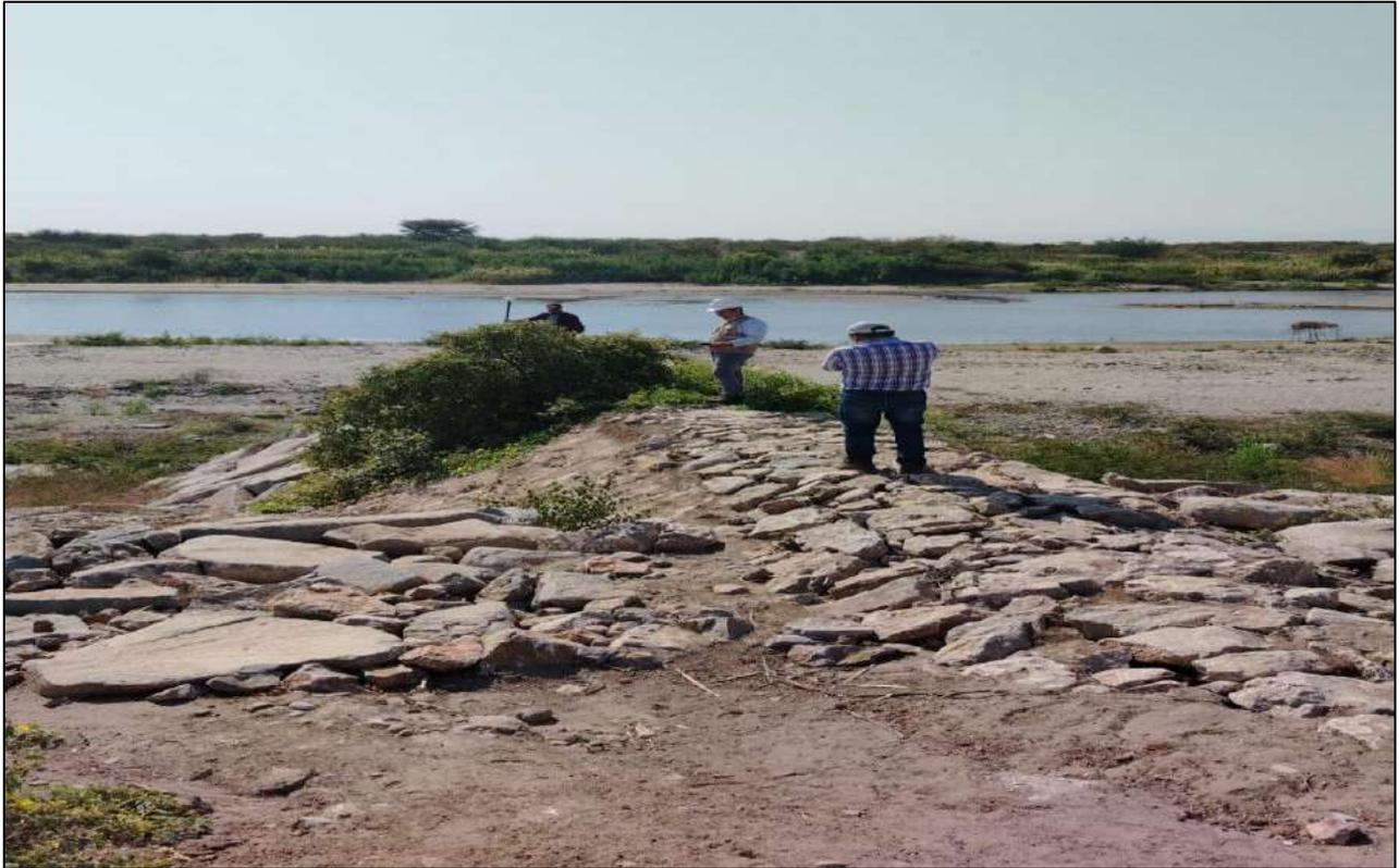
**Foto 5: se verifica que el espigón 2 se encuentra en la progresiva 7+540 pero con una longitud de 7.642 mts y con su ancho de corona de 1 mt.**
