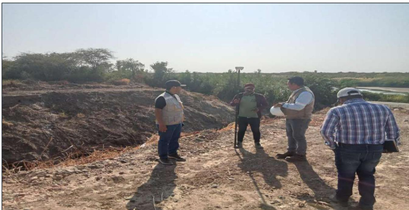
**Foto: se utiliza un GPS diferencial para determinar las coordenadas y distancias del proyecto ejecutado para corroborar lo expresado en expediente técnico.**
