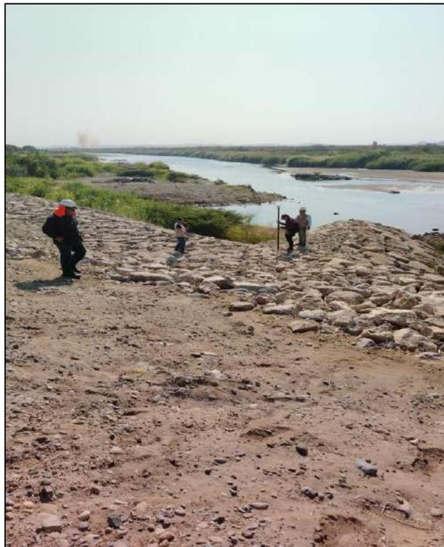
Foto 9: se verifica que el espigón 6 se encuentra en la progresiva 7+836 pero con una longitud de 23.59 mts y con su ancho de corona de 1 mt.
