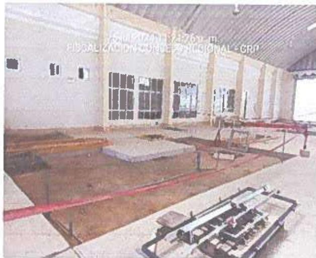
**Losas sin construir debido a ductos de diámetros inapropiados**
