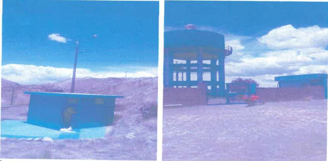
Como se observa la fotografía N°05 pertenece a la caseta de bombeo de emergencia del SAP de HECTOR TEJADA el cual se encuentra en un estado deteriorado y que requiere de intervención, del mismo modo la fotografía N° 06 pertenece al reservorio del mismo SAP el cual también requiere de mantenimiento.
