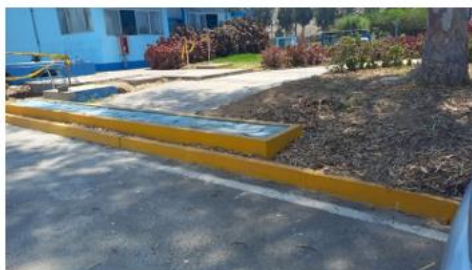
Canal de aproximación al vertedero de la línea del Vicentelo
