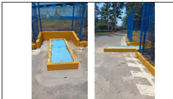
Sección de medición en el canal de aproximación vertedero La Menacho
