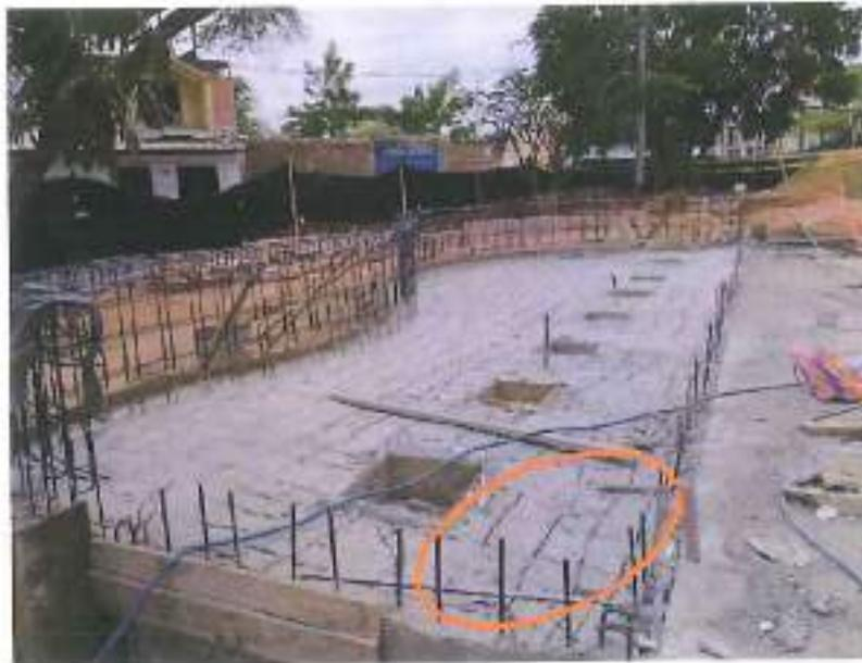
Falta de colocación de capuchones en acero expuesto, en la zona de pifeta de agua
