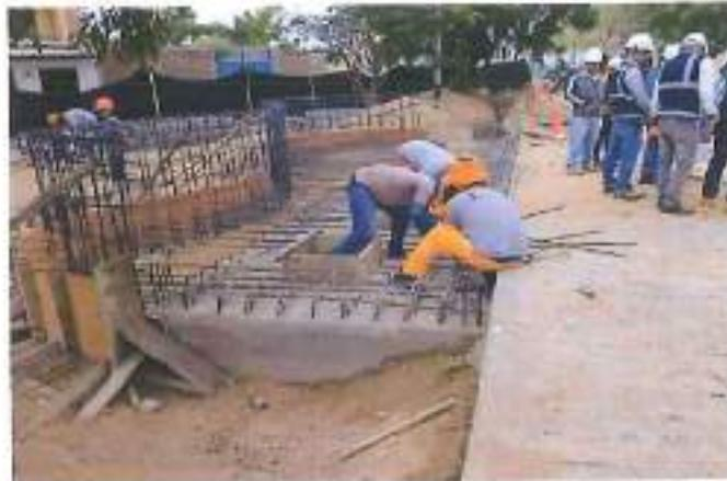
Colocación de acero en losa para fuente de agua de pileta
