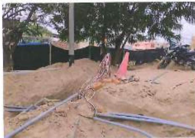
Tuberías eléctricas expuestas y con conductores eléctricos expuestos sin la debida protección y señalización
