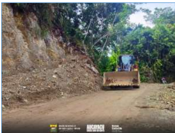
Apertura de carretera en caserío Alto Alianza
