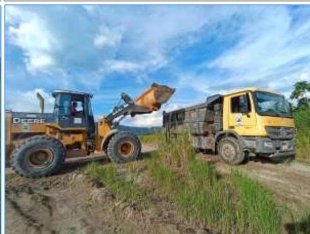
Ejecución de trabajos de limpieza del malecón Sangapilla
