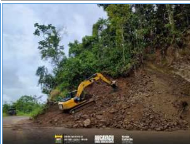
Apertura de carretera en el caserío de Santa Rosa de Magdalena
